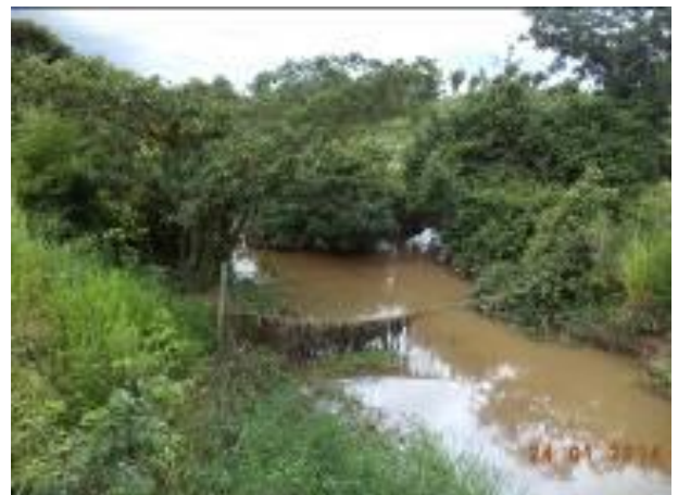
Foto 181: Jusante da travessia 96 em janeiro de 2014. Foto: Ampla
