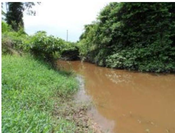
Foto 526: Montante da travessia 316 em dezembro de 2012. Foto: Amplo
