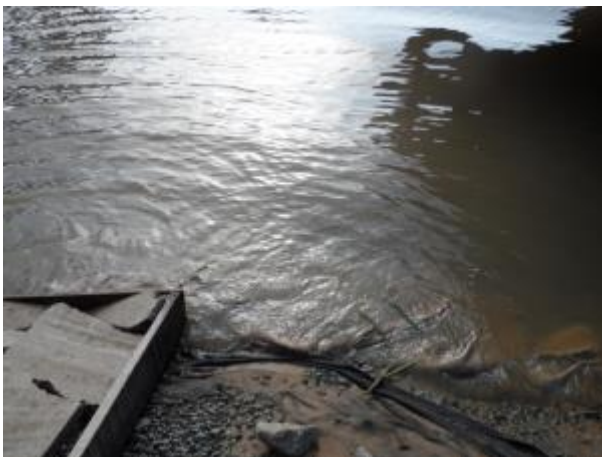
Foto 90: Montante da travessia 62 em janeiro/13. Foto: Amplo
