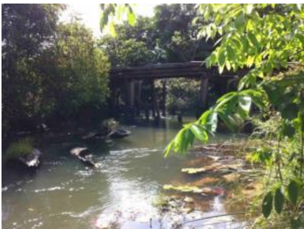
Foto 396: Montante da travessia 243 em julho de 2013. Foto: Amplo
