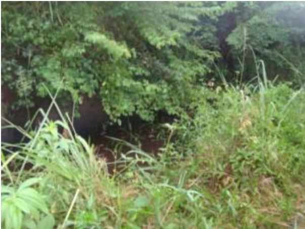
Foto 140: Montante da travessia 78 em abril/13. Foto: Amplo
