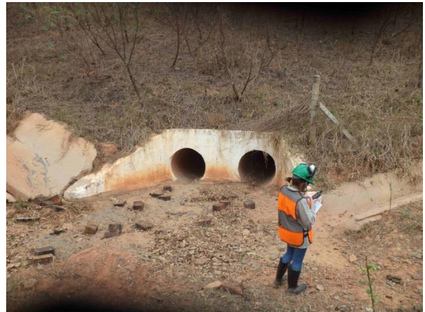
Foto 332: Montante da travessia 174, em outubro de 2013. Foto: Amplo
