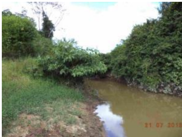
Foto 530: Montante da travessia 316 em julho de 2013. Foto: Amplo
