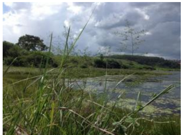
Foto 350: Jusante da travessia 191 em janeiro de 2013. Foto: Amplo
