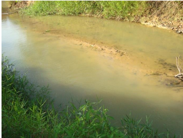
Foto 257: Detalhe do leito assoreado a jusante da travessia. Foto: Amplo
