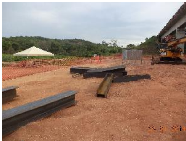
Foto 278: Detalhe da área a ser instalada a ponte ferroviária, janeiro de 2014. Foto: Amplo
