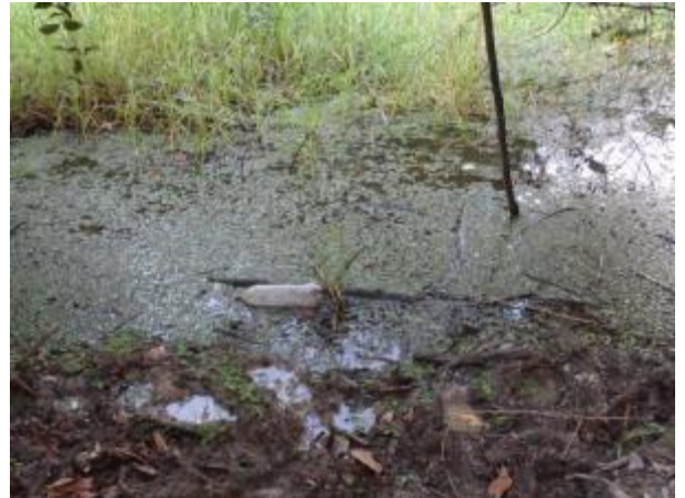
Foto 173: Detalhe do lixo a jusante da travessia.
