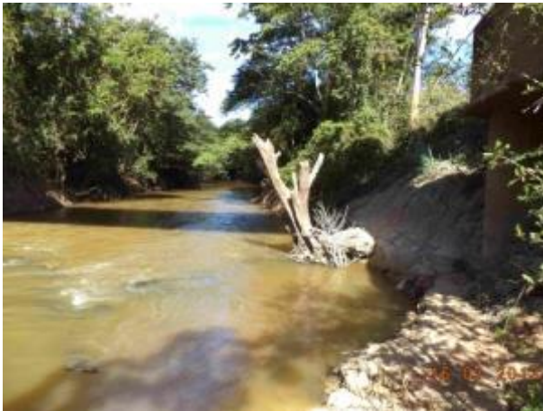
Foto 430: Montante da travessia 260 em julho de 2013. Foto: Ampla
