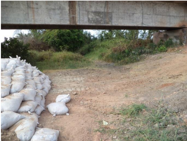
Foto 133: Montante da travessia 77 em outubro de 2013, com existência de sistema de contenção temporária (rip rap). Foto: Ampla
