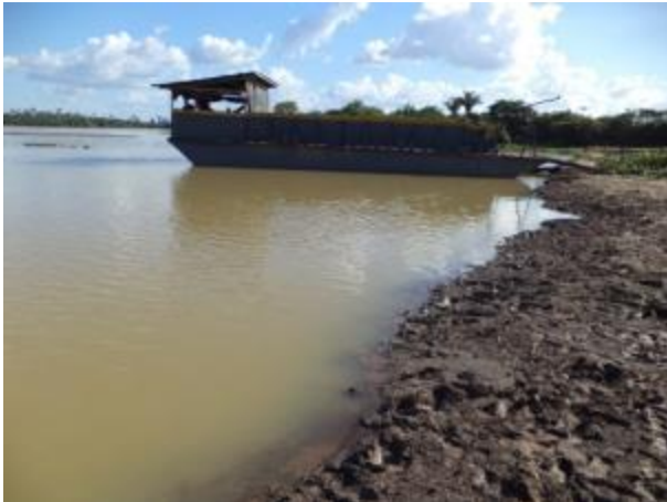
Foto 163: Montante da travessia 86 em julho de 2013. Foto: Amplo
