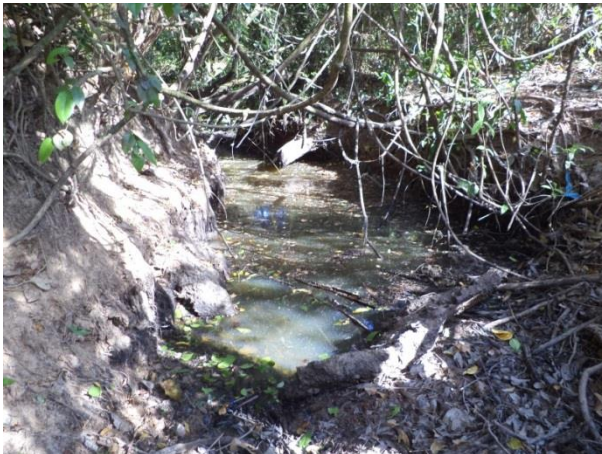
Foto 16: Montante da travessia 19 em outubro de 2013. Foto: Amplo
