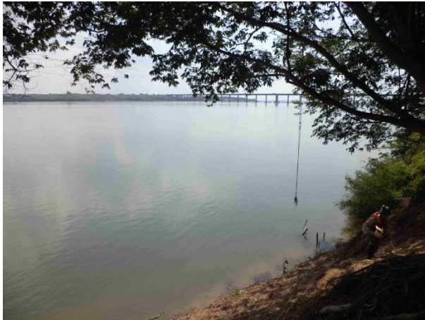
Foto 477: Montante da Travessia 275 em outubro de 2013. Foto: Amplo
