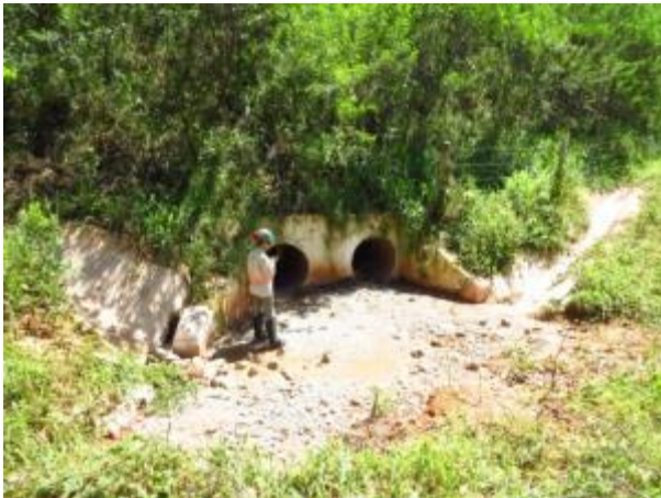
Foto 331: Montante da travessia 174, em julho de 2013. Foto: Amplo
