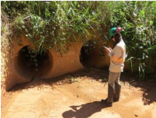
Foto 343: Montante da travessia 177, em julho de 2013. Foto: Amplo
