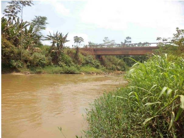
Foto 542: Montante da travessia 329 em outubro de 2013. Foto: Amplo
