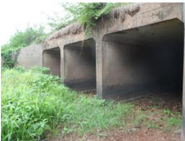
Foto 138: Montante da travessia 78 em janeiro/13. Foto: Amplo
