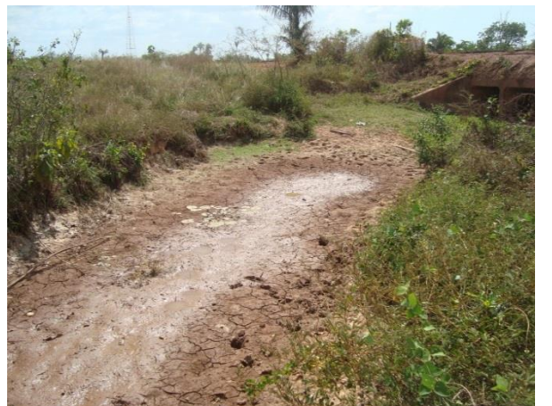
Foto 28: Jusante da travessia 35, no Igarapé Carema, em outubro/13. Foto: Amplo
