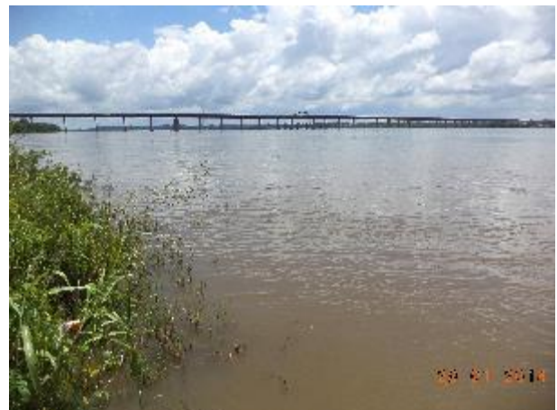
Foto 480: Jusante da Travessia 275 em janeiro de 2014. Foto: Amplo
