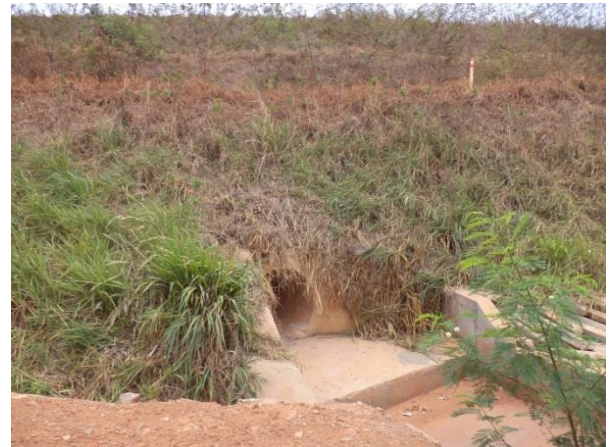
Foto 344: Montante da travessia 177, em outubro de 2013. Foto: Amplo
