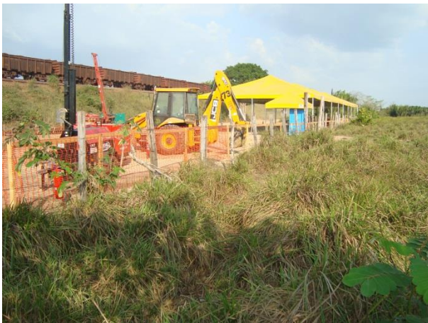
Foto 121: Detalhe dos equipamentos de obras. Foto: Amplo
