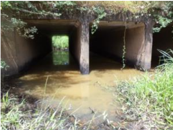
Foto 142: Jusante da travessia 78 em julho/13. Foto: Amplo
