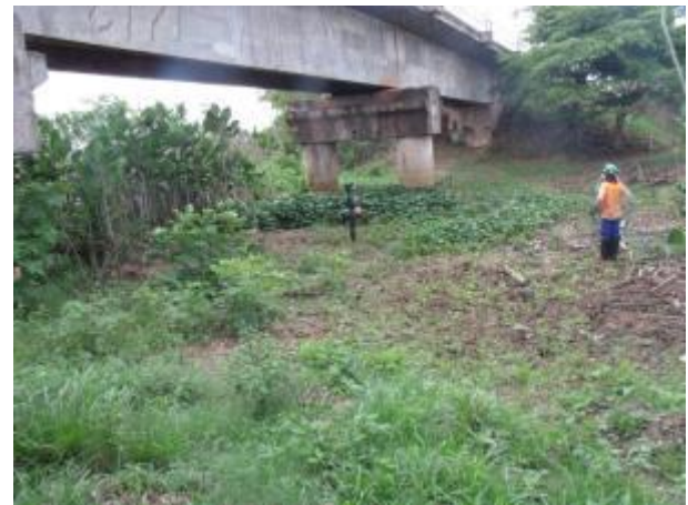
Foto 114: Jusante da travessia 63 em janeiro/13. Foto: Amplo
