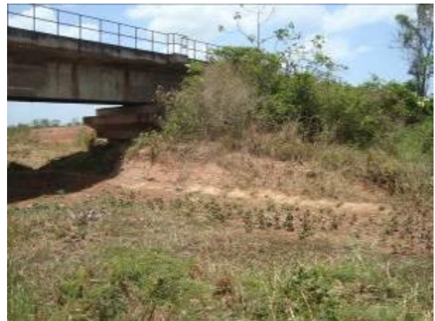
Foto 66: Jusante da travessia 61 em janeiro/13. Foto: Amplo
