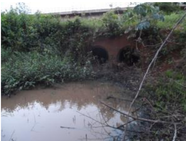
Foto 46: Montante da travessia 57 em janeiro/13. Foto: Amplo
