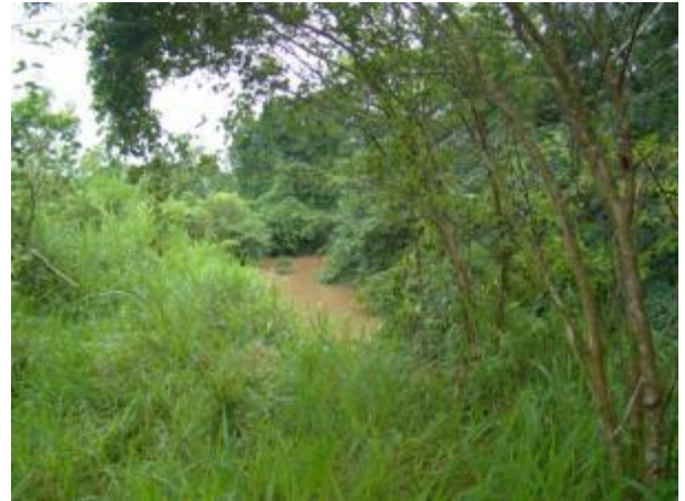
Foto 518: Jusante da travessia 301 em janeiro de 2013. Foto: Amplo
