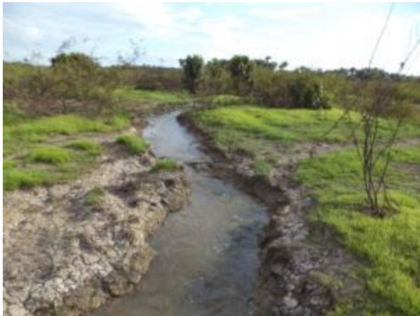
Foto 186: Montante da travessia 100 em julho de 2013. Foto: Amplo
