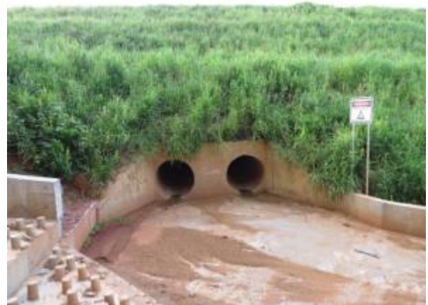
Foto 342: Montante da travessia 177, em abril de 2013. Foto: Amplo
