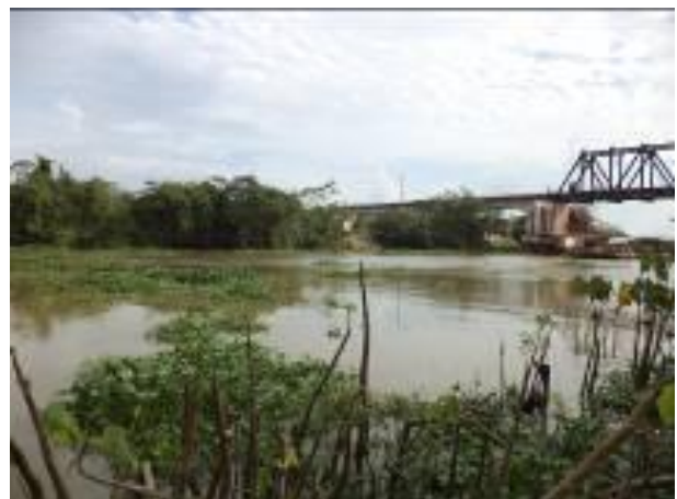
Foto 102: Jusante da travessia 62 em janeiro de 2014. Foto: Amplo
