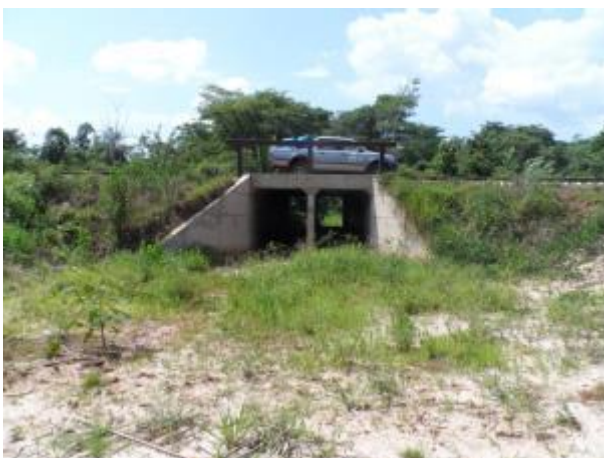
Foto 37: Montante da travessia 48 em janeiro/13. Foto: Amplo
