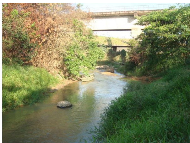
Foto 256: Jusante da Travessia 132 em outubro de 2013. Foto: Amplo
