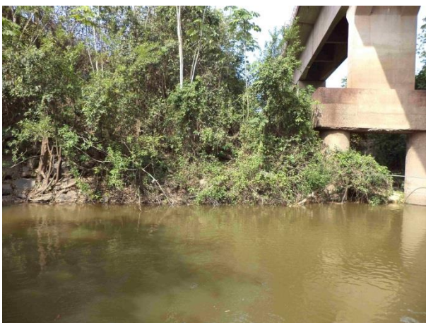
Foto 432: Montante da travessia 260 em outubro de 2013. Foto: Ampla
