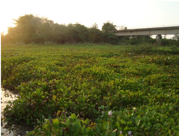
Foto 84: Montante da travessia 359 em outubro de 2013. Foto: Amplo
