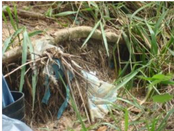
Foto 393: Lixo na travessia 243 jusante.
