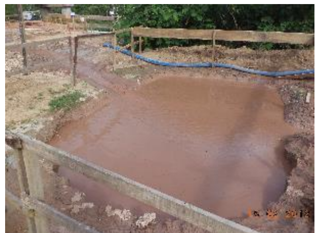
Foto 126: Detalhe da drenagem da água utilizada na perfuração das estacas raiz da ponte ferrov. Praqueú. Foto: Amplo
