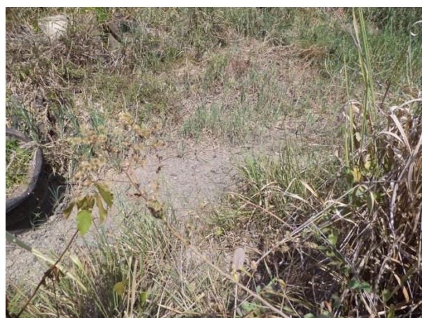
Foto 239: Montante da Travessia 116 em outubro de 2013. Foto: Amplo
