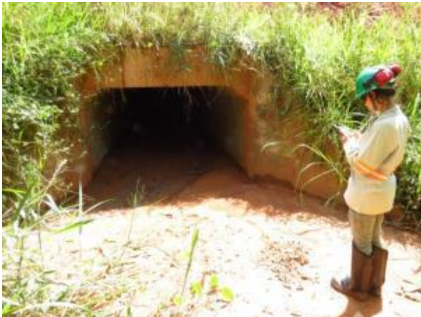
Foto 335: Montante da travessia 175, em julho de 2013. Foto: Amplo
