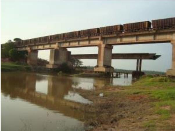
Foto 158: Montante da travessia 86 em dezembro/12. Foto: Amplo
