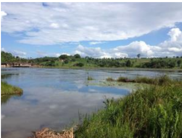
Foto 349: Montante da travessia 191 em janeiro de 2013.
