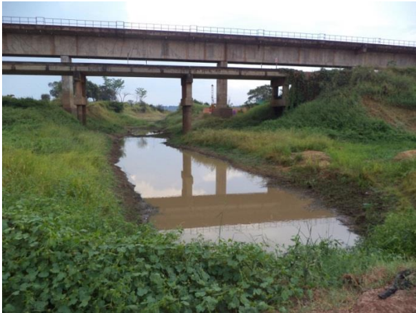
Foto 152: Montante da travessia 83 em outubro de 2013. Foto: Amplo
