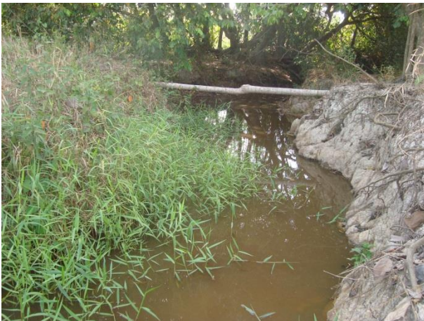
Foto 228: Montante da travessia 113 em outubro de 2013. Foto: Amplo
