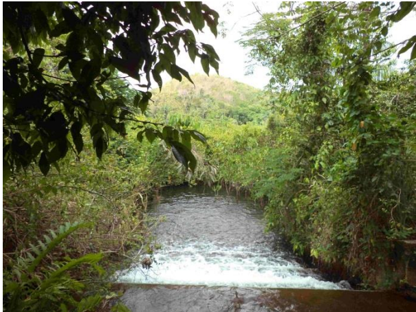
Foto 317: Montante da travessia 166, em outubro de 2013. Foto: Amplo
