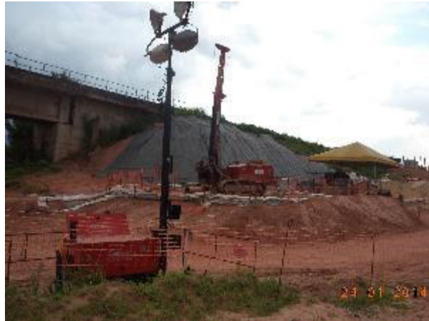
Foto 169: Detalhe da área onde será o Encontro 01 da ponte ferroviária Zutúia, janeiro de 2014. Foto: Amplo
