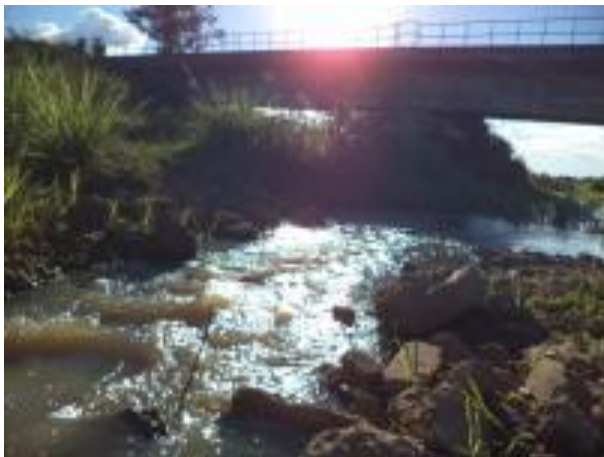
Foto 70: Montante da travessia 61 em julho de 2013. Foto: Amplo
