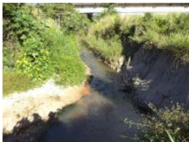
Foto 237: Montante da Travessia 116 em julho de 2013. Foto: Amplo
