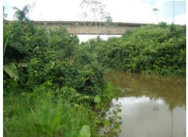
Foto 411: Jusante da travessia 252 em janeiro de 2013. Foto: Amplo
