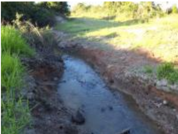
Foto 209: Montante da travessia 108 em julho de 2013. Foto: Amplo
