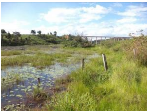
Foto 359: Montante da travessia 191 em janeiro de 2014. Foto: Ampla
