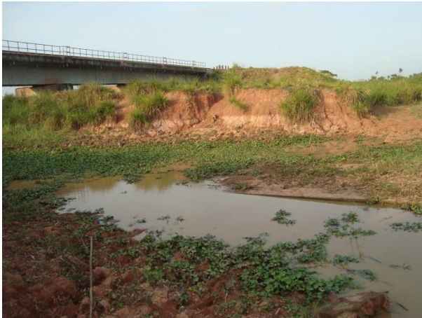
Foto 62: Montante da travessia 60 em outubro de 2013. Foto: Amplo
