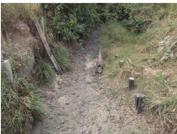
Foto 238: Montante da travessia 116 em outubro de 2013. Foto: Amplo
