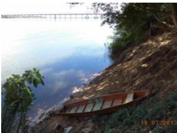
Foto 475: Montante da Travessia 275 em julho de 2013. Foto: Amplo
