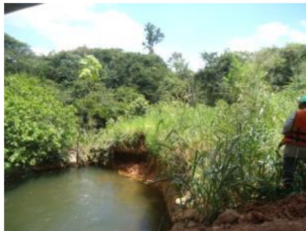
Foto 314: Jusante da travessia 166, no Rio dos Sonhos, em abril de 2013. Foto: Amplo
