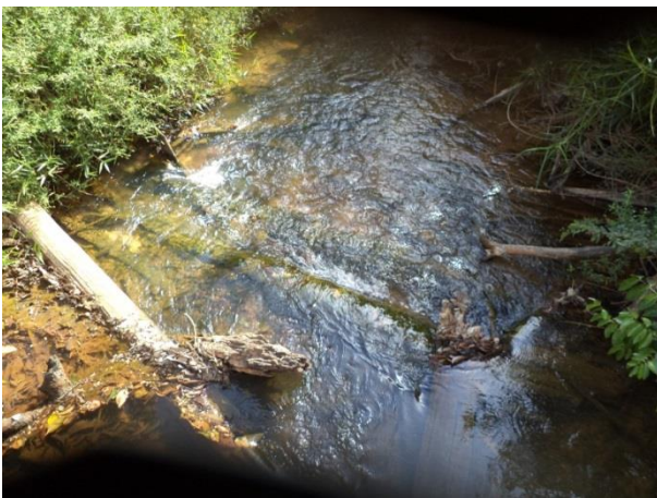
Foto 264: Montante da travessia 134 em outubro de 2013. Foto: Amplo
