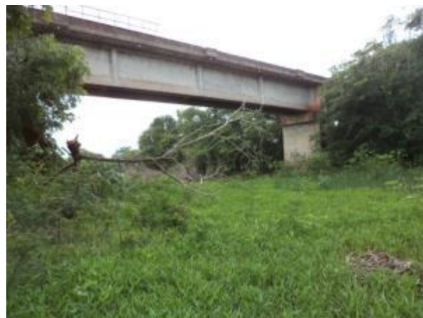
Foto 112: Jusante da travessia 360 em janeiro de 2014. Foto: Amplo
