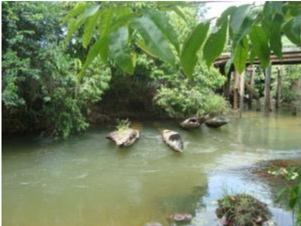
Foto 391: Montante da travessia 243 em janeiro de 2013. Foto: Ampla
