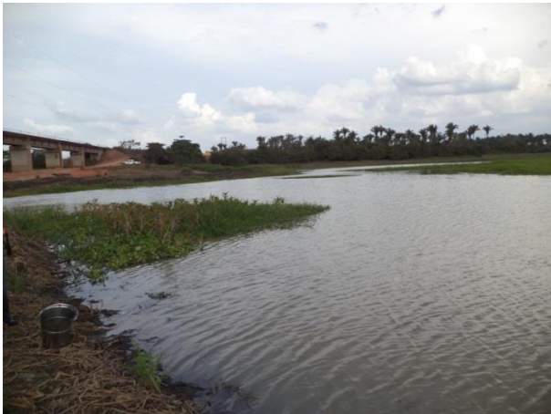
Foto 165: Montante da travessia 86 em outubro de 2013. Foto: Amplo
