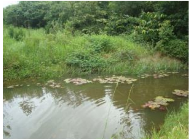
Foto 384: Jusante da travessia 240 em janeiro de 2013. Foto: Amplo
