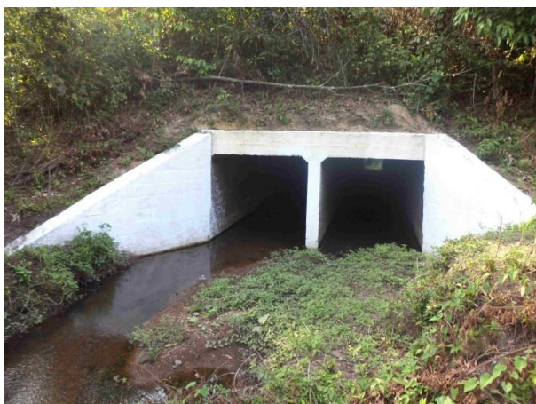
Foto 487: Montante da travessia 281 em outubro de 2013. Foto: Ampla
