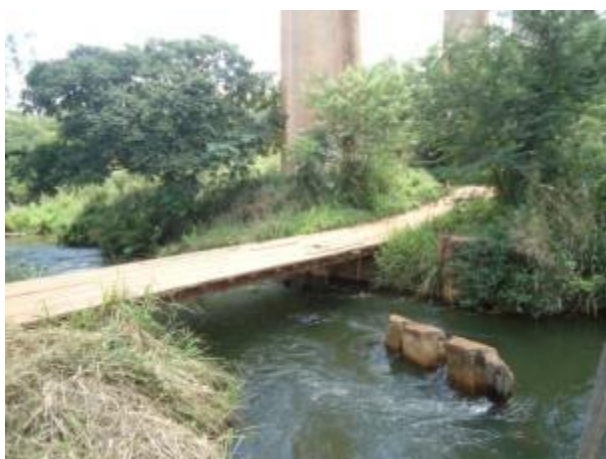
Foto 353: Montante da travessia 191 em abril de 2013. Foto: Amplo
