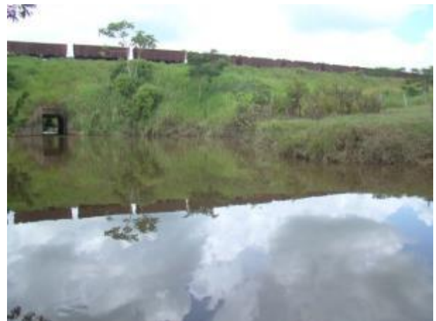
Foto 437: Jusante da travessia 265 em janeiro de 2013. Foto: Amplo
