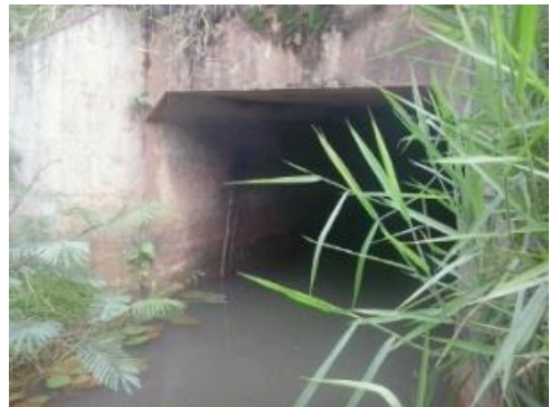
Foto 362: Jusante da travessia 197 em janeiro de 2013. Foto: Ampla
