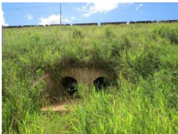
Foto 339: Montante da travessia 176, em julho de 2013. Foto: Amplo
