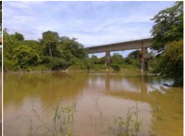
Foto 490: Jusante da travessia 283 em janeiro de 2013. Foto: Amplo
