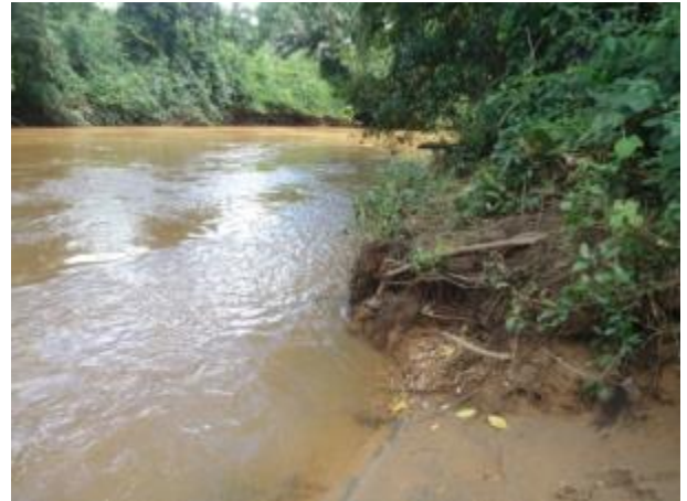
Foto 539: Jusante da travessia 329 em abril de 2013. Foto: Amplo
