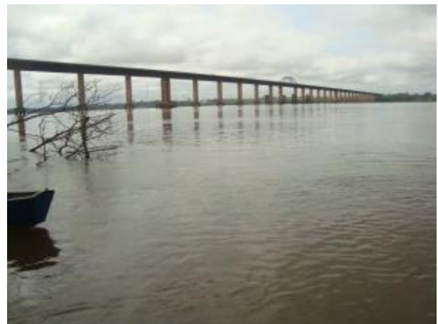
Foto 470: Jusante da Travessia 275 em janeiro de 2013. Foto: Amplo
