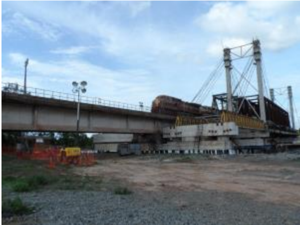
Foto 3: Detalhe da área de entorno do ponto amostral. Foto: Amplo
