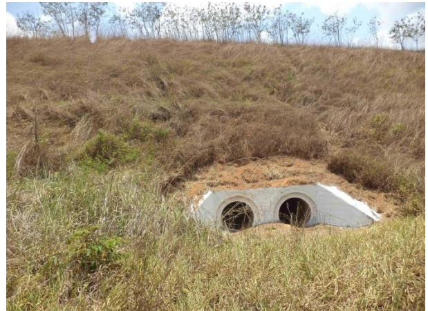
Foto 348: Montante da travessia 179 em outubro de 2013. Foto: Amplo
