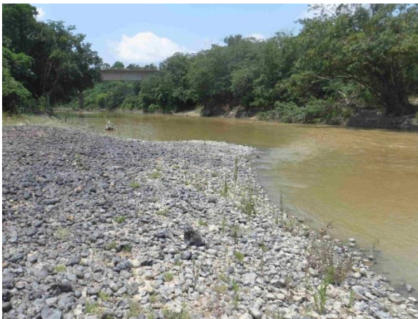
Foto 495: Montante da travessia 283 em outubro de 2013. Foto: Ampla
