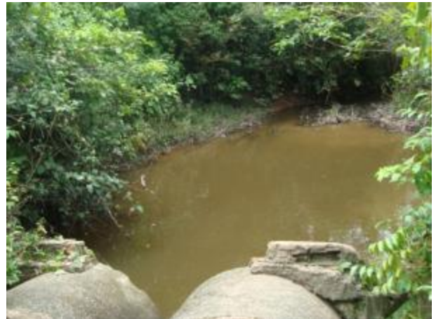
Foto 49: Jusante da travessia 57 em abril de 2013. Foto: Amplo
