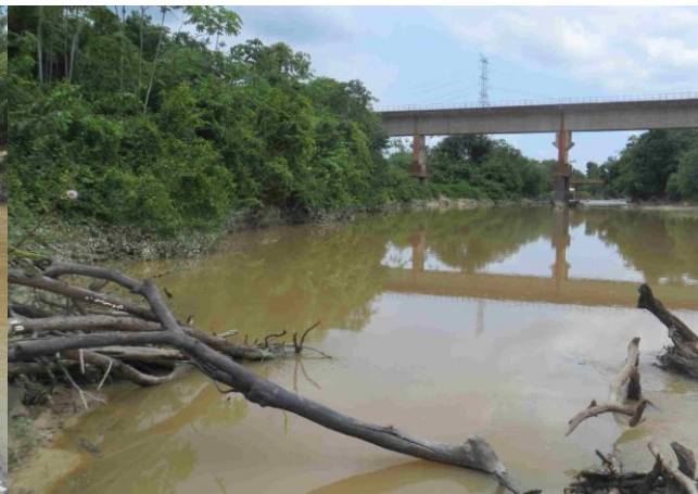
Foto 496: Jusante da travessia 283 em outubro de 2013. Foto: Ampla
