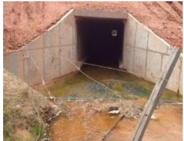
Foto 500: Jusante da travessia 286 em janeiro de 2013. Foto: Amplo
