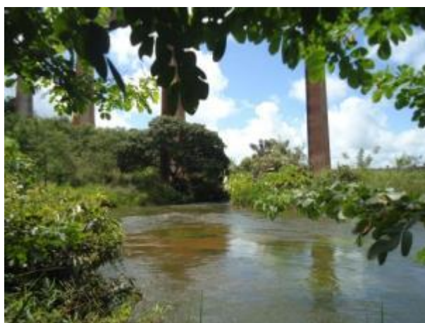
Foto 354: Jusante da travessia 191 em abril de 2013. Foto: Amplo
