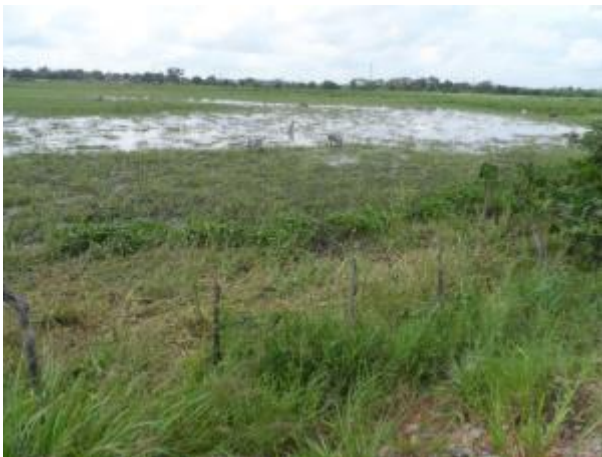
Foto 65: Montante da travessia 61 em janeiro/13. Foto: Amplo
