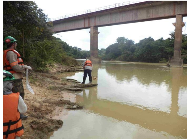
Foto 516: Jusante da travessia 290 em outubro de 2013. Foto: Amplo
