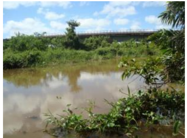
Foto 59: Jusante da travessia 60 em abril de 2013. Foto: Amplo
