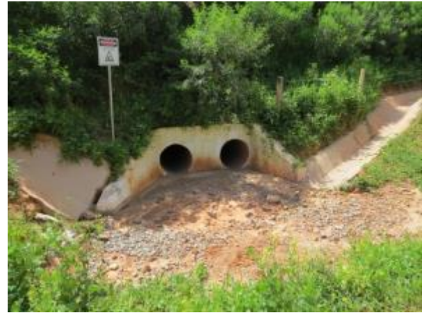
Foto 330: Montante da travessia 174, em abril de 2013. Foto: Amplo
