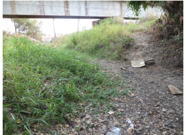
Foto 134: Jusante da travessia 77 em outubro de 2013. Foto: Ampla
