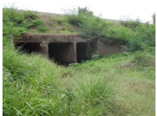
Foto 139: Jusante da travessia 78 em janeiro/13. Foto: Amplo
