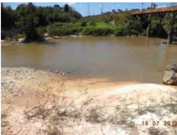
Foto 493: Montante da travessia 283 em julho de 2013. Foto: Amplo
