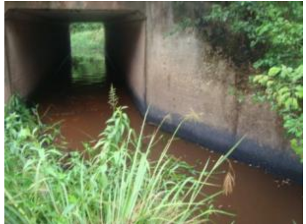
Foto 141: Jusante da travessia 78 em abril/13. Foto: Amplo
