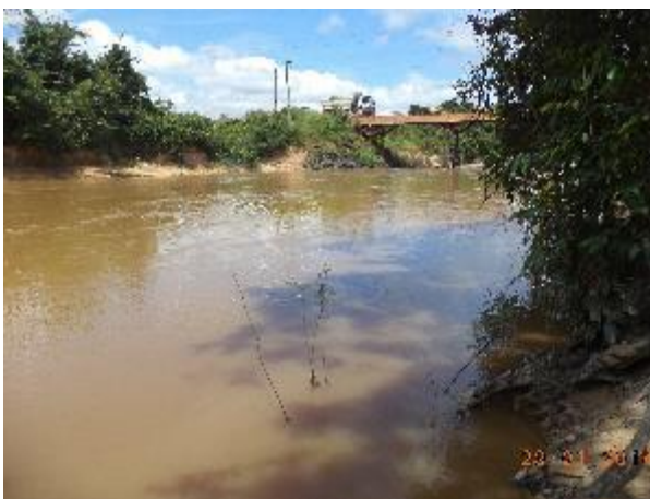
Foto 497: Montante da travessia 283 em janeiro de 2014. Foto: Ampla
