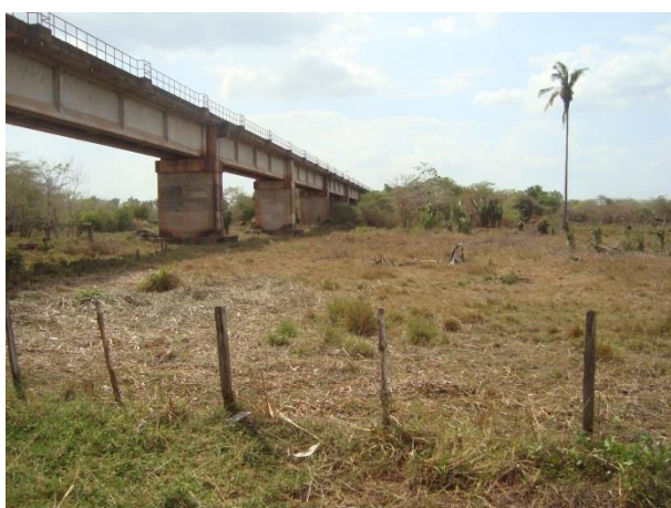
Foto 109: Montante da travessia 360 em outubro de 2013. Foto: Amplo
