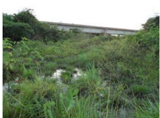
Foto 104: Jusante da travessia 360 em janeiro/13. Foto: Amplo
