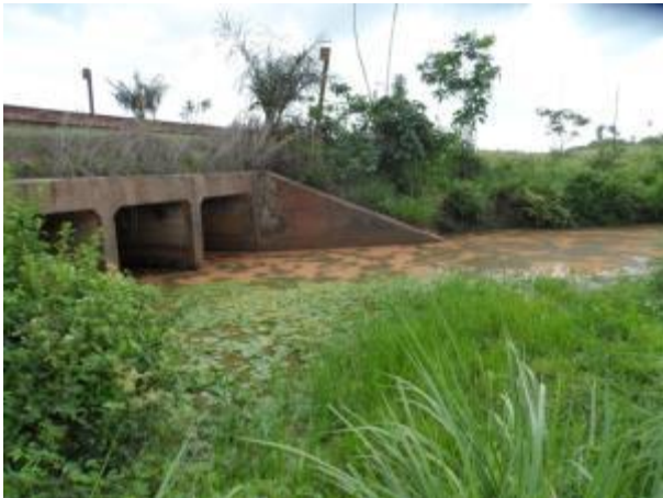
Foto 20: Montante da travessia 35 em janeiro/13. Foto: Amplo
