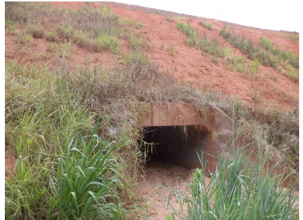
Foto 336: Montante da travessia 175, em outubro de 2013. Foto: Amplo
