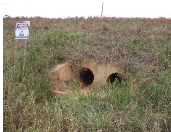
Foto 340: Montante da travessia 176, em outubro de 2013. Foto: Amplo
