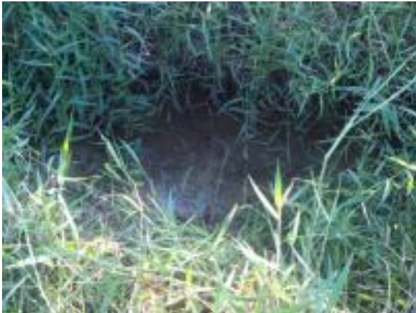
Foto 226: Montante da travessia 113 em julho de 2013. Foto: Amplo
