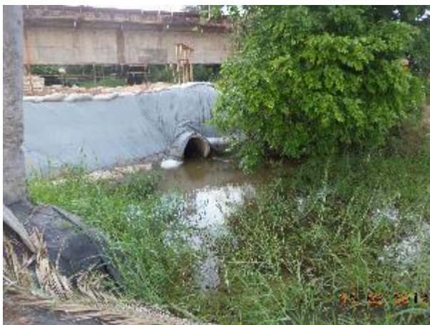
Foto 136: Montante da travessia 77 em janeiro de 2014, com aterro de conquista temporário já instalado, Foto: Ampla
