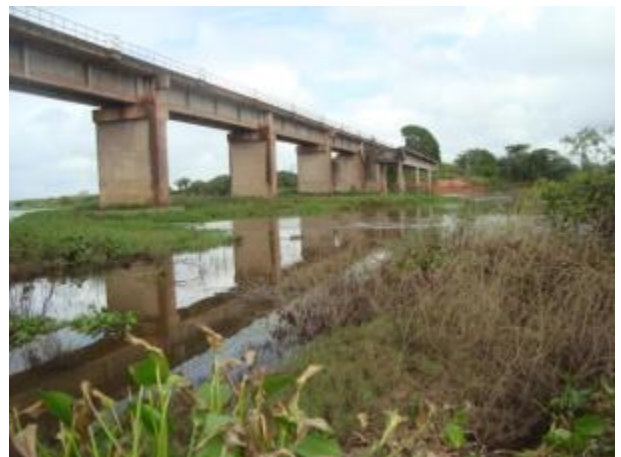
Foto 162: Jusante da travessia 86 na em abril de 2013. Foto: Amplo
