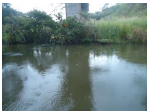
Foto 297: Jusante da travessia 156 em abril de 2013. Foto: Amplo
