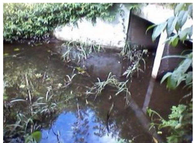
Foto 482: Jusante da travessia 281 em janeiro de 2013. Foto: Amplo
