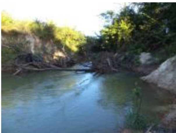
Foto 253: Montante da travessia 132 em julho de 2013. Foto: Amplo
