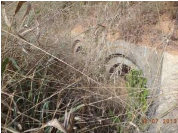
Foto 347: Montante da travessia 179 em julho de 2013. Foto: Amplo
