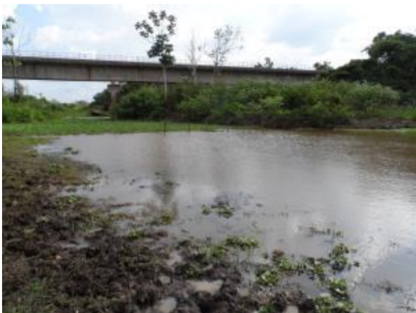
Foto 77: Montante da travessia 359 em janeiro/13. Foto: Amplo
