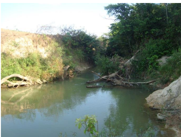
Foto 255: Montante da travessia 132 em outubro de 2013. Foto: Amplo
