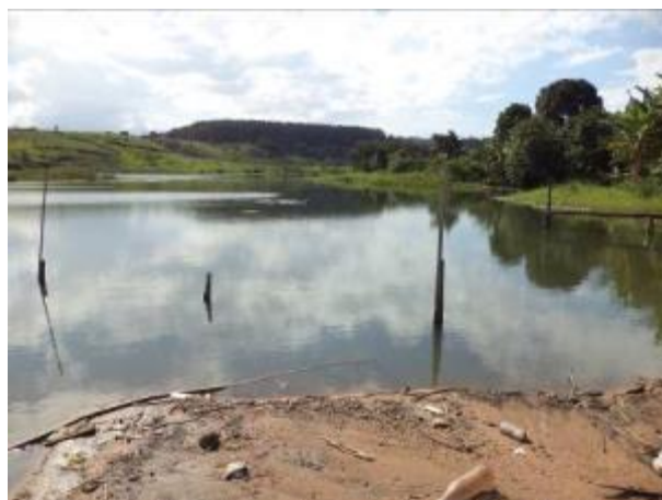
Foto 360: Jusante da travessia 191 em janeiro de 2014. Foto: Ampla
