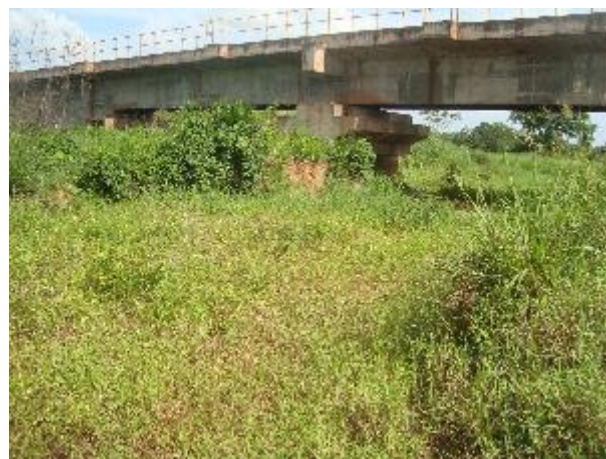
Foto 76: Jusante da travessia 61 em janeiro de 2014. Foto: Amplo
