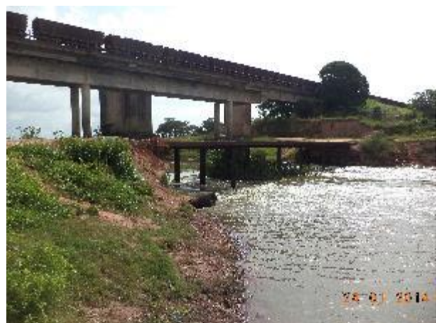
Foto 168: Jusante da travessia 86 na em janeiro de 2014. Foto: Amplo
