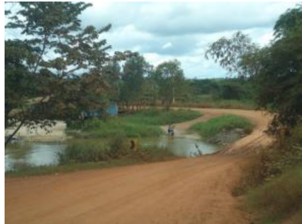
Foto 8: Ponte de madeira para transposição de curso d'água. Fonte: Amplo, 2013.
