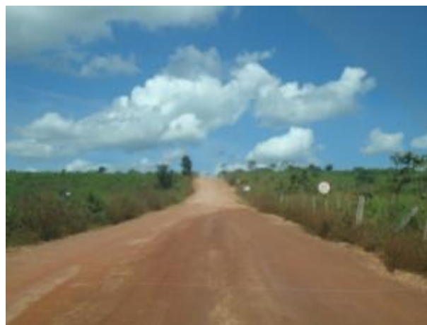
Foto 17: Via com cobertura de piçarra e sinalização vertical. Fonte: Amplo, 2013.
