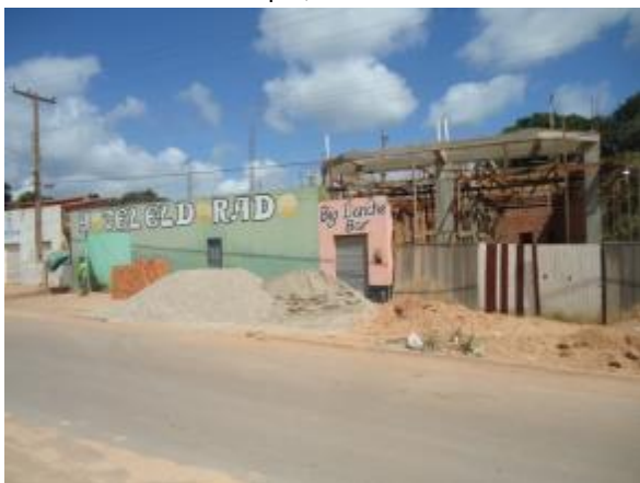
Foto 3: Hotel Eldorado (esq.) e comércio em construção (dir.). Fonte: Amplo, 2013.
