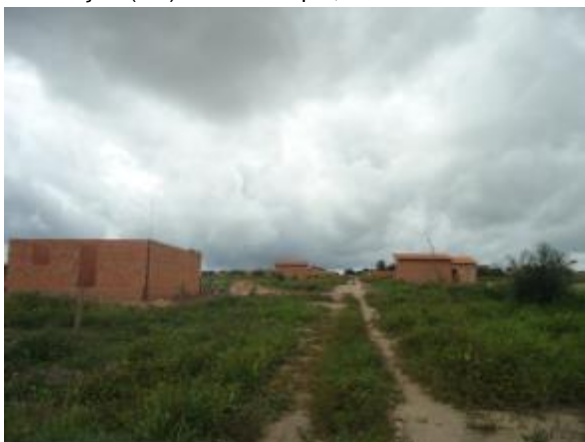
Foto 5: Habitações em Construção no bairro Nestor
