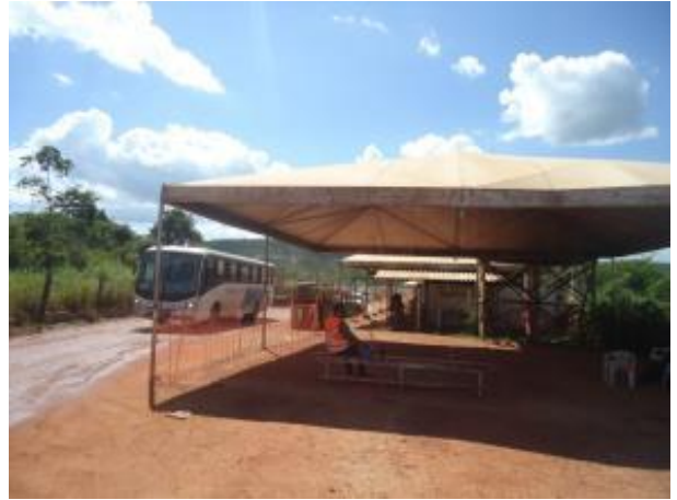
Foto 19: Canteiro avançado às margens do acesso viário, próximo à ferrovia. Fonte: Ampla, 2013
