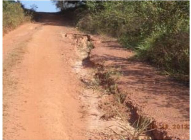
Foto 30: Processo erosivo na via. Fonte: Amplo, 2013.
