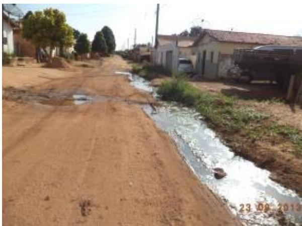
Foto 11: Rua interna à Sede Municipal de Cidelândia, sem pavimentação; Efluente líquido lançado à céu aberto. Fonte: Amplo, 2013.
