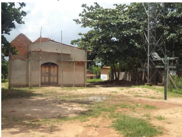
Foto 41: Edificação em construção na localidade Vila União. Fonte: Amplo, 2014.
