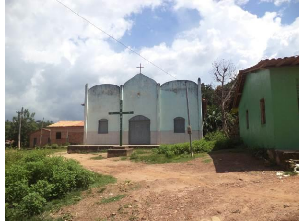
Foto 56: Igreja Católica, existente na localidade Vila Pindaré. Fonte: Amplo, 2014.
