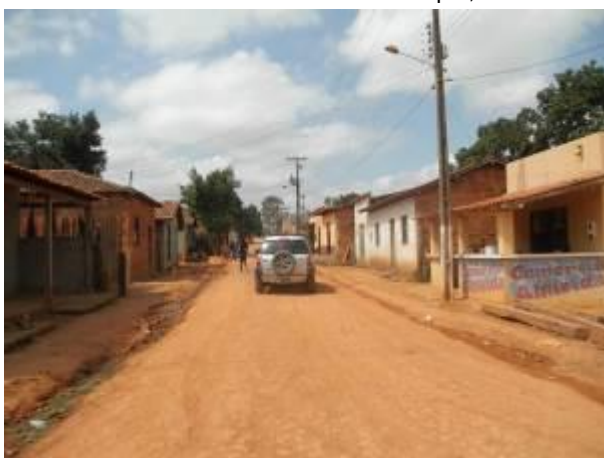
Foto 89: Comércio (dir.) e habitações às margens da via de acesso inserida na Vila Tropical. Fonte: Amplo, 2013.
