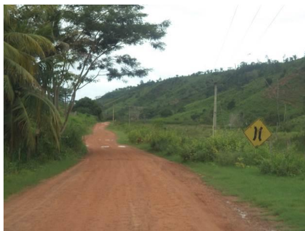
Foto 76: Sinalização existente no Acesso Viário BU01. Fonte: Amplo, 2014.
