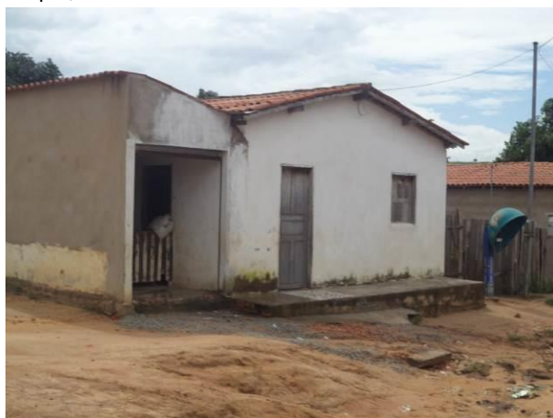
Foto 48: Equipamento de telefonia público existente na Vila Concórdia. Fonte: Ampla, 2014.
