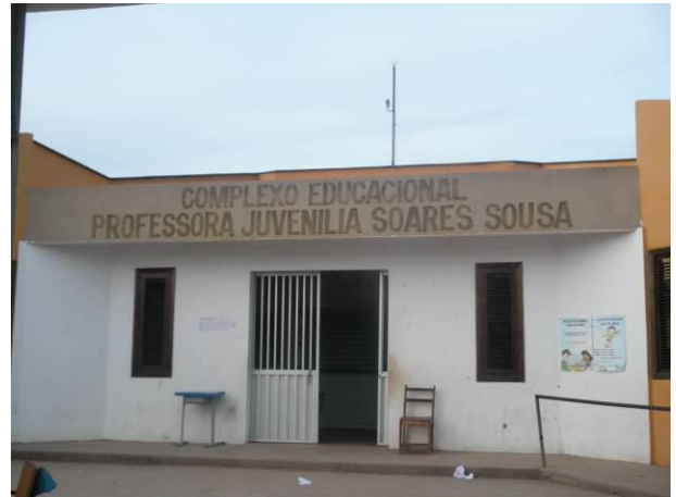
Foto 8: Unidade de ensino da rede estadual “Complexo Educacional Professora Juvenília Soares Sousa”, localizada na Sede Municipal de Buriticupu/MA. Fonte: Amplo, 2013.
