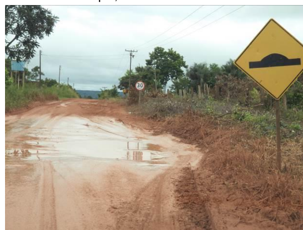
Foto 84: Sinalização existente no Acesso Viário. Fonte: Ampla, 2014.
