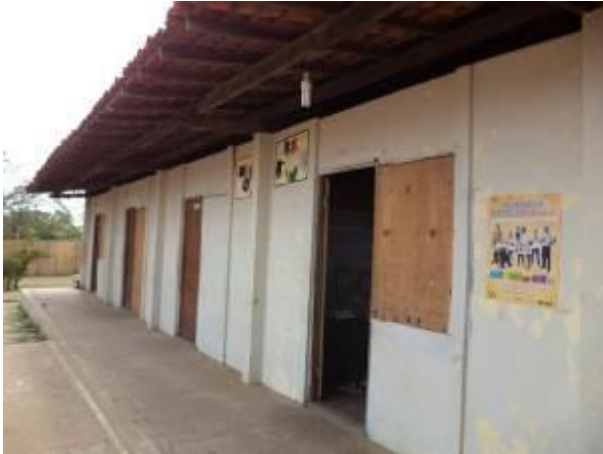
Foto 13: Salas de Aula da Unidade Integrada Manoel Campos Sousa, com funcionamento no Alojamento Nova Vida para atendimento à população da Vila Tropical. Fonte: Ampla, 2013.
