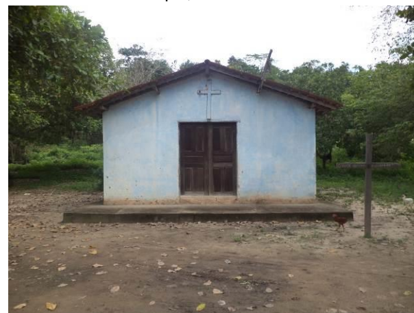
Foto 66: Igreja católica existente na localidade Centro dos Farias. Fonte: Amplo, 2014.
