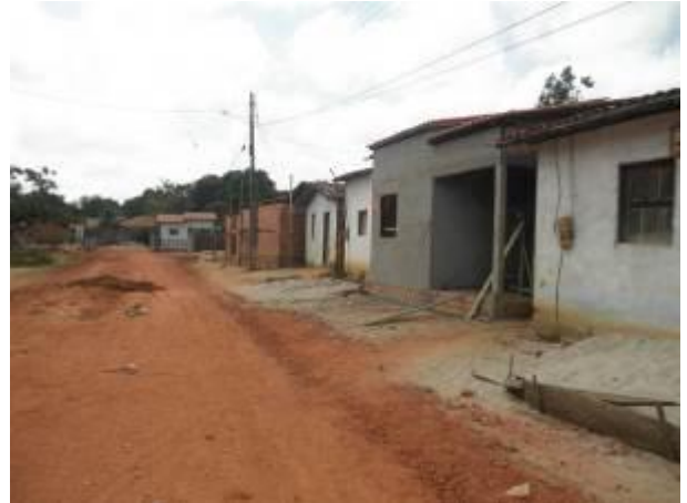
Foto 14: Residência de alvenaria em construção na Vila Tropical. Fonte: Ampla, 2013.
