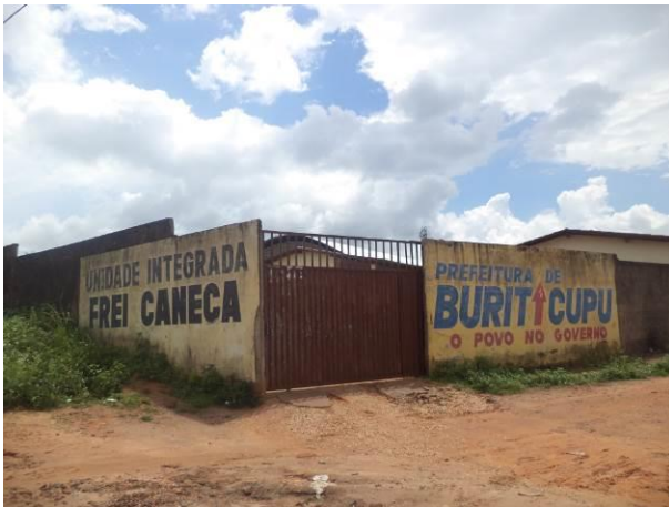
Foto 51: Unidade Integrada Frei Caneca, escola existente na localidade Vila Pindaré. Fonte: Ampla, 2014.
