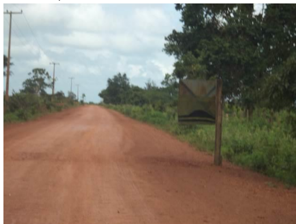
Foto 78: Sinalização improvisada no Acesso Viário. Fonte: Amplo, 2013.
