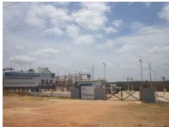
Foto 6: Subestação de distribuição de energia elétrica do município de Buriticupu. Fonte: Amplo, 2013.
