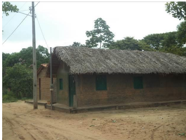
Foto 68: Residências existentes na localidade Centro dos Farias. Fonte: Ampla, 2014.
