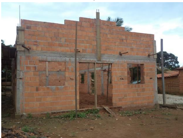
Foto 29: Edificação em construção na localidade Vila Pau Ferrado. Fonte: Ampla, 2014.
