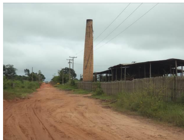
Foto 82: Fábrica de cerâmica localizada no Acesso BU02. Fonte: Ampla, 2014.
