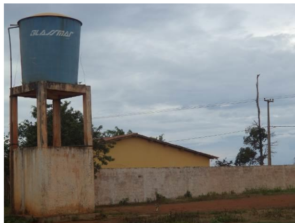
Foto 32: Caixa d'água existente na localidade Vila Pau Ferrado. Fonte: Ampla, 2014.
