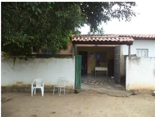
Foto 43: Unidade Básica de Saúde existente na localidade Vila União. Fonte: Ampla, 2014.
