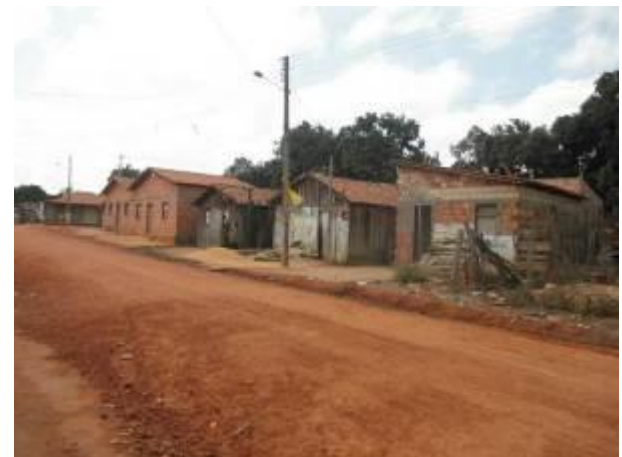
Foto 10: Condições de uma via e residências de taipa e alvenaria, Vila Tropical. Fonte: Amplo, 2013.
