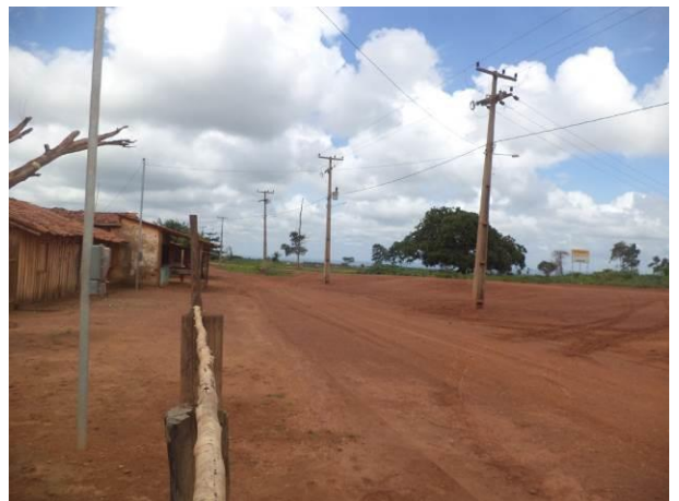
Foto 28: Trecho com iluminação pública na localidade Vila Pau Ferrado. Fonte: Ampla, 2014.
