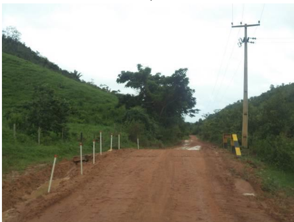
Foto 77: Ponte que perpassa o Acesso BU01. Fonte: Amplo, 2013.
