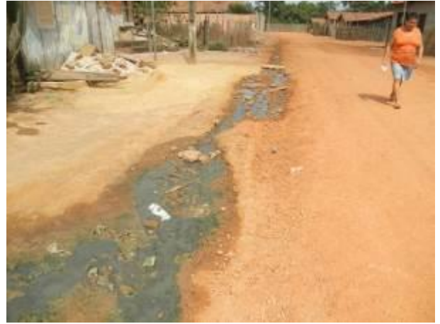
Foto 92: Esgoto a céu aberto na via de acesso inserida na Vila Tropical. Fonte: Amplo, 2013.
