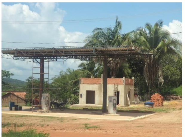
Foto 54: Posto de Gasolina em construção na localidade Vila Pindaré. Fonte: Ampla, 2014.
