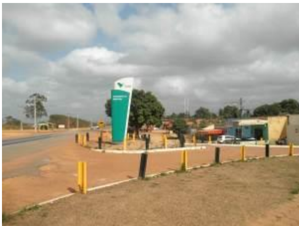
Foto 87: Via de acesso ao alojamento Nova Vida, derivada da BR 222. Presença de pequenos estabelecimentos comerciais. Fonte: Amplo, 2013.
