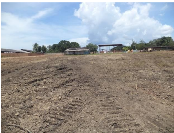
Foto 16-19: Área destinada à implantação do canteiro de obras principal em Santa Inês/MA. Fonte: Amplo, 2014.
