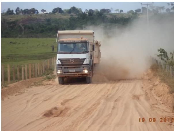
Foto 16-99: Condições da pavimentação e tráfego de veículo pesado na Via de Acesso CI02, em Cidelândia/MA. Fonte: AMPLO, 2014.
