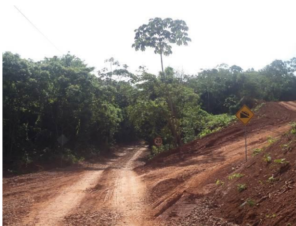
Foto 16-125: Condições de pavimentação e sinalização existente no Acesso AC01C, em Açailândia/MA. Fonte: Ampla, 2014.
