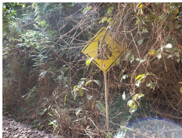
Foto 16-126: Sinalização coberta pela vegetação no Acesso Viário AC01C. Fonte: Ampla, 2014.
