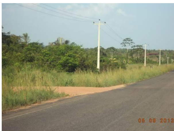
Foto 16-107: Início do acesso SP03, São Pedro da Água Branca. Fonte: AMPLO, 2013.
