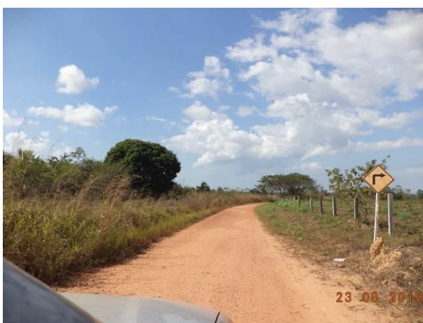
Foto 16-137: Condições de pavimentação e sinalização no acesso MB01, em Marabá/PA. Fonte: Ampla, 2013
