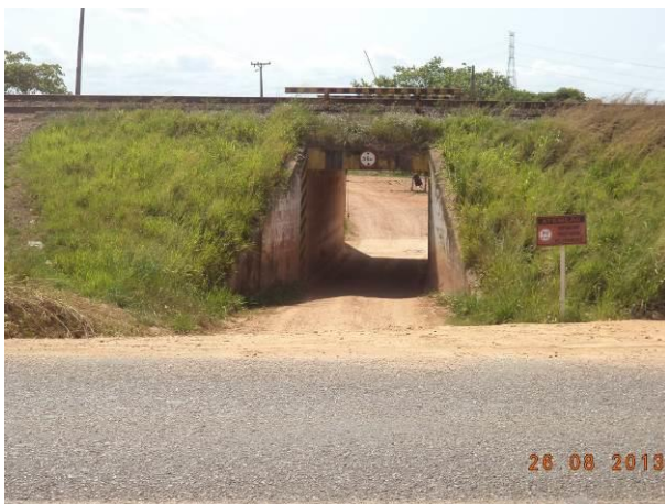
Foto 16-141: Passagem Inferior presente no acesso MB04, em Marabá/PA. Fonte: Ampla, 2013
