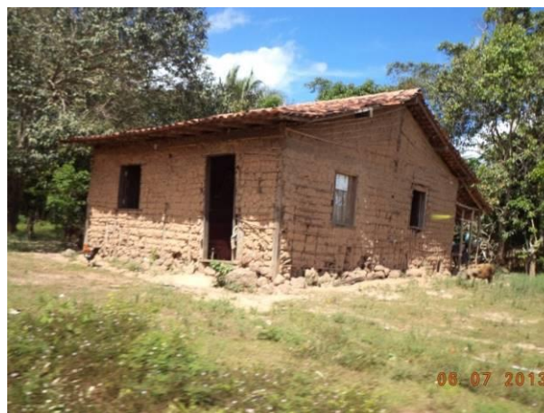
Foto 16-162: Condições de residência da comunidade de Ribeiro; habitação de taipa. Fonte: AMPLO, 2013.
