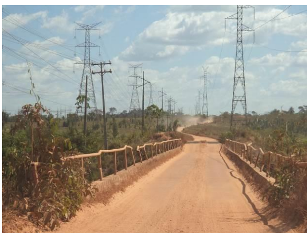
Foto 16-157: Ponte existente no acesso MB12, em Marabá/PA. Fonte: Ampla, 2013
