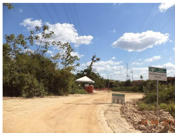
Foto 16-158: Trecho do acesso MB12, em Marabá/PA. Fonte: Ampla, 2013.
