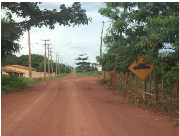
Foto 16-89: Condições da pavimentação e sinalização existente na via de Acesso BU01, em Buriticupu/MA. Fonte: AMPLO, 2014.
