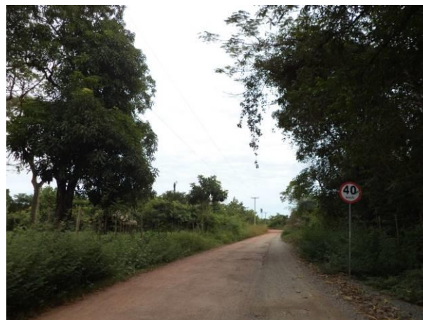
Foto 16-160: Condições da via de acesso SR01; sinalização. Fonte: AMPLO, 2013.
