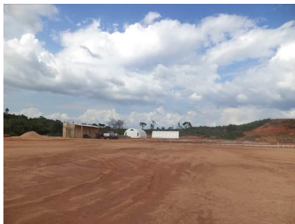
Foto 16-22: Visita e caracterização da área destinada à instalação do Canteiro de Obras Principal em Açailândia – MA. Fonte: Amplo, 2014.
