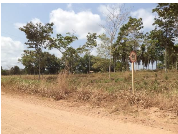
Foto 16-149: Aspectos da pavimentação e da sinalização existentes no acesso MB08, em Marabá/PA. Fonte: Ampla, 2013
