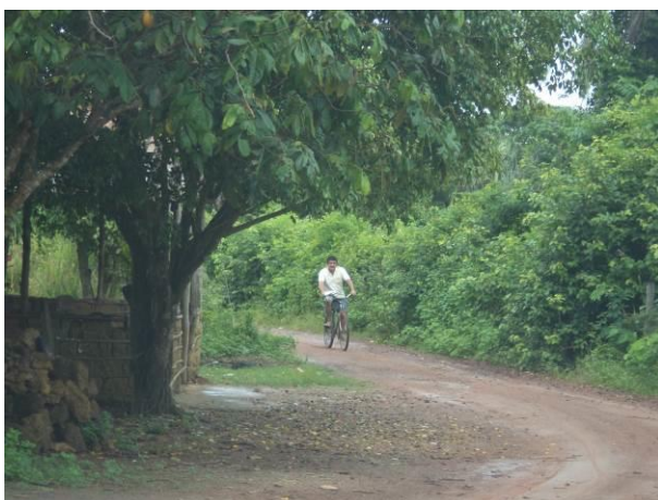
Foto 16-171: Condições da pavimentação, e usuário na via de acesso SR06B, em Pacova, Anajatuba/MA. Fonte: Ampla, 2014
