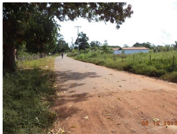
Foto 16-166: Condições da via do acesso SR04, comunidade de Oiteiro dos Nogueiras. Fonte: AMPLO, 2013.
