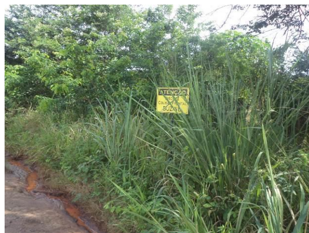
Foto 16-130: Sinalização coberta pela vegetação no Acesso Viário AC03, em Açailândia/MA. Fonte: Ampla, 2014.
