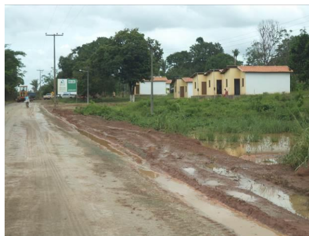
Foto 16-174: Perfil de ocupação e condições da via de acesso SR07, em Monte Lindo II, Anajatuba/MA. Fonte: Ampla, 2014
