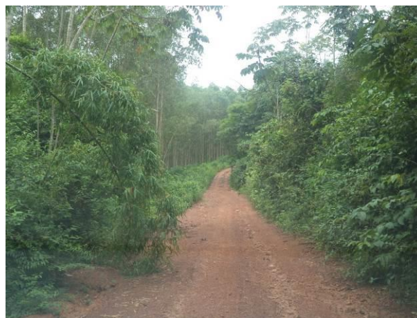
Foto 16-136: Trecho do Acesso AC07 com vegetação às margens, em Açailândia/MA. Fonte: Amplo, 2014.
