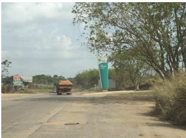
Foto 16-151: Trecho do acesso MB09, em Marabá/PA. Fonte: Ampla, 2013
