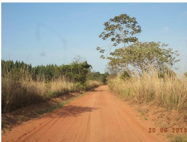
Foto 16-95: Condições da pavimentação do Acesso Viário CI01, Cidelândia/MA. Fonte: AMPLO, 2014.
