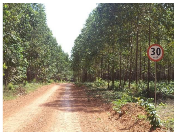
Foto 16-124: Condições da pavimentação e sinalização existente no Acesso Viário AC01AB. Fonte: Ampla, 2014.
