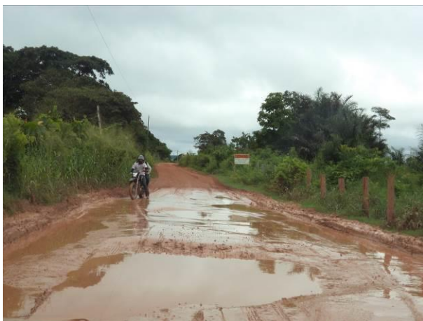
Foto 16-91: Condições da pavimentação do Acesso Viário BU02, em Buriticupu/MA. Fonte: AMPLO, 2014.
