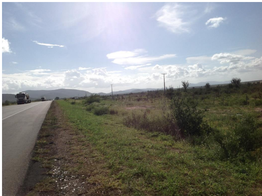
Foto 6: Km 501+200, pista sul. Vista da faixa de domínio da rodovia a ser duplicada.
