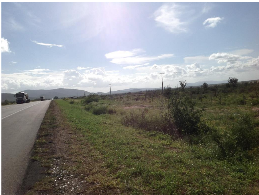
Foto 6: Km 501+200, pista sul. Vista da faixa de domínio da rodovia a ser duplicada.
