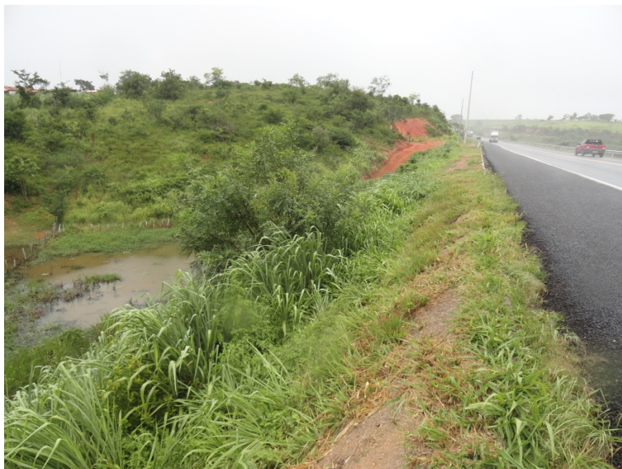
Foto 16. Km 844+650, Pista Sul. Vegetação antrópica em APP.
