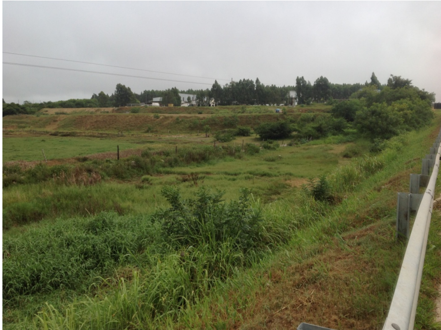
Foto 05. Km 830+500, Pista Sul. Vala em faixa de domínio.
