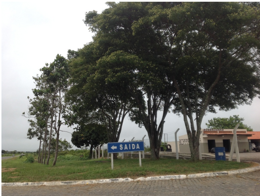
Foto 10. Km 836+600, Pista Sul. Vista geral da área a ser duplicada.
