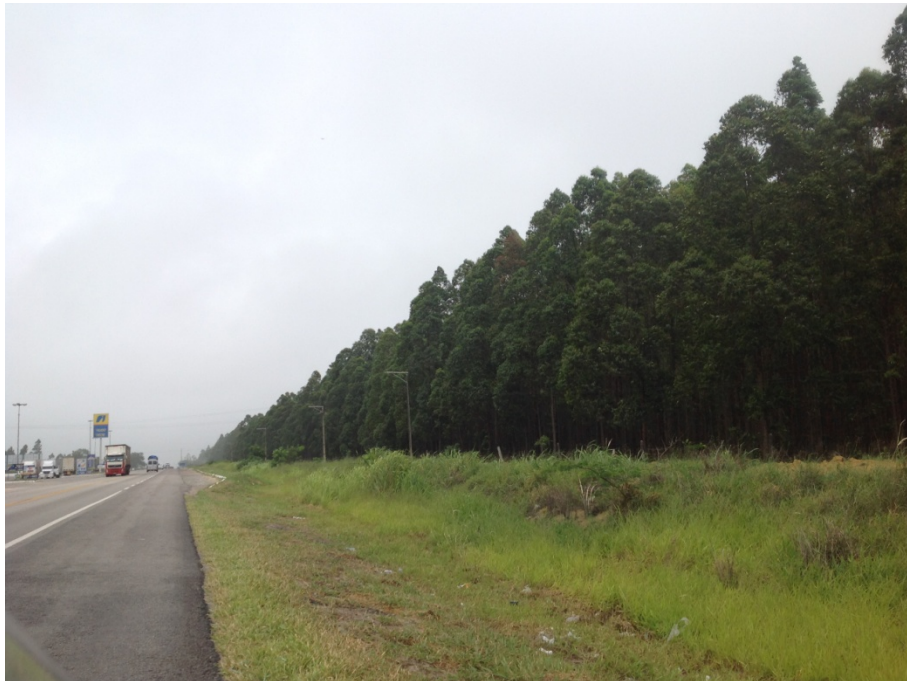
Foto 07. Km 834+100, Pista Sul. Vista geral da área a ser duplicada.
