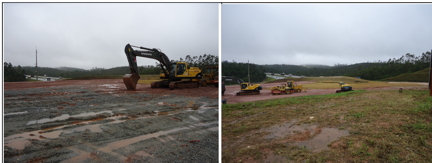
Fotos 2 e 3: Vista geral do trevo de ligação entre o trecho Sul do Rodoanel e a Avenida Papa João XXII, município de Ribeirão Pires, dentro do qual ficarão todas as obras do Lote 01 do trecho Leste.
