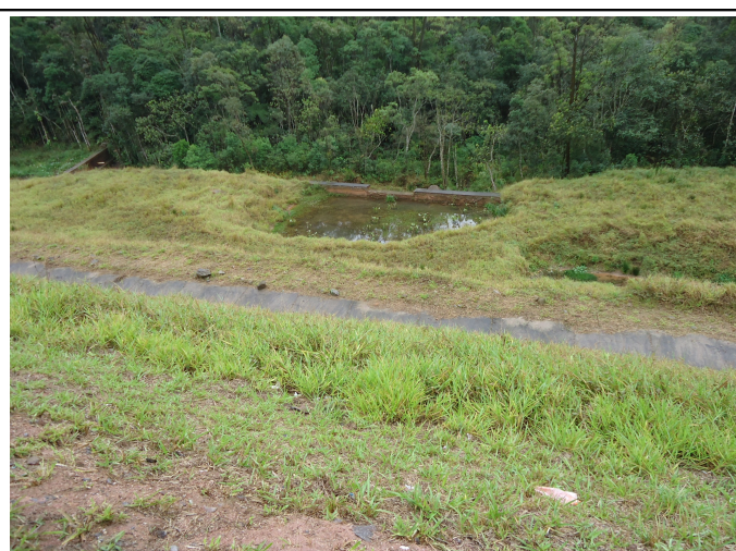
Foto 7: Poucos metros a frente do ponto da Foto 6, estrutura para contenção provisória de sedimentos, oriundos da drenagem do trevo.
