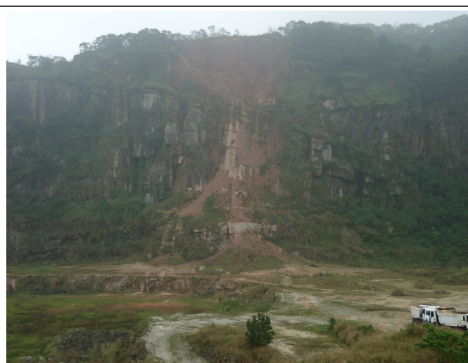
Foto 16: Cava da pedreira no ponto do emboque sul do Túnel Santa Luzia (Lote 02), mostrando desmoronamento (ao centro) e presença de caminhões (canto inferior direito).
