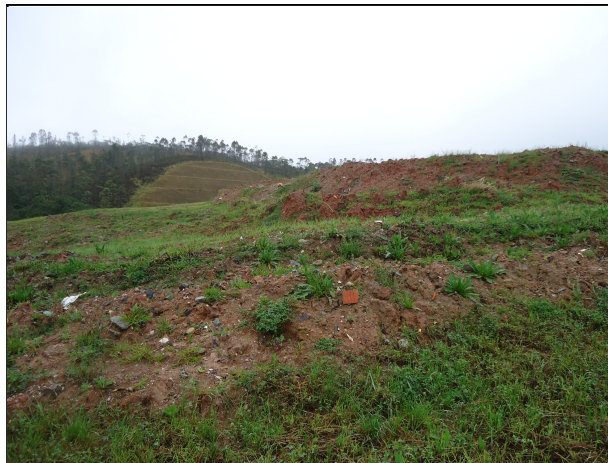
Fotos 4 e 5: Acúmulo de terra no interior do trevo, recoberta com gramínea. Esse material será reaproveitado nas obras do Lote 01 do trecho Leste.
