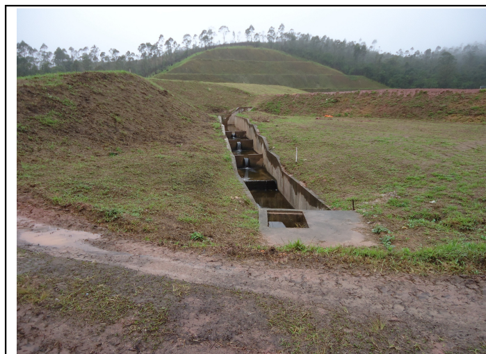
Foto 8: Drenagem com dissipador de energia na saída do trevo em direção à Av. Papa João XXIII.
