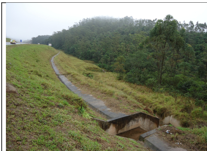
Foto 6: Bueiro e dissipador de energia da drenagem, à direita do trevo de conexão trechos Sul, Leste e Av. Papa João XXIII, na Faixa de Domínio do Rodoanel.
