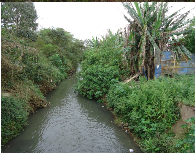
Foto 22 (à esquerda): Rio Guaió já com a várzea totalmente descaracterizada no ponto final do Lote 03 do Rodoanel, com vegetação restrita a poucos metros das margens, bairros periféricos na divisa entre Suzano e Poá/SP.
