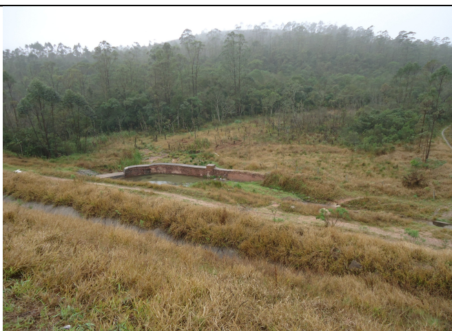
Foto 9: Vizinho ao trevo, local que alagou matando árvores (frondes secas no centro), e estrutura tipo gabião com mureta alta para retenção provisória de sedimentos.
