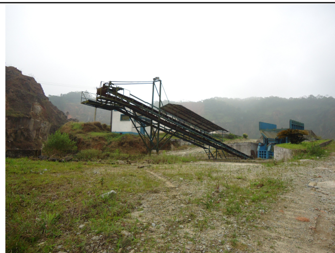
Fotos 13: Estruturas não mais utilizadas pela pedreira, que permanecem no terreno, próximo à cava onde será instalado o Túnel Santa Luzia.
