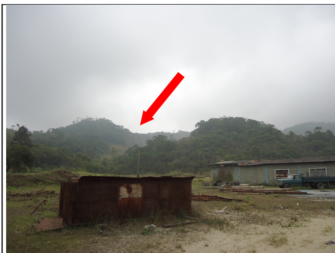
Foto 15: A seta vermelha indica área anterior ao emboque sul do túnel (Lote 02) no terreno da pedreira, por onde passará o trecho Leste do Rodoanel. Pouca vegetação remanescente, pioneira ou em estágio inicial de regeneração.
