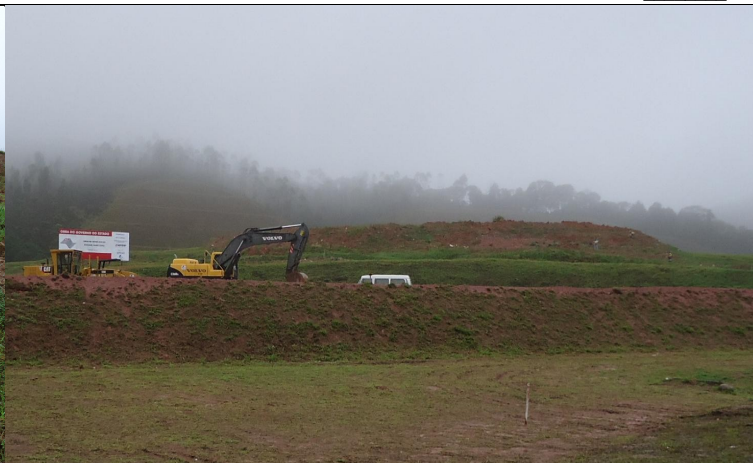
Fotos 4 e 5: Acúmulo de terra no interior do trevo, recoberta com gramínea. Esse material será reaproveitado nas obras do Lote 01 do trecho Leste.
