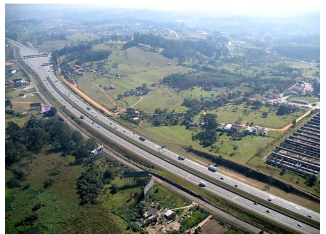
Foto 58: Rodovia Ayrton Senna (sentido São Paulo), área de fazendas à direita e um galpão industrial abandonado na Avenida do Bonsucesso que segue em direção a Guarulhos.
