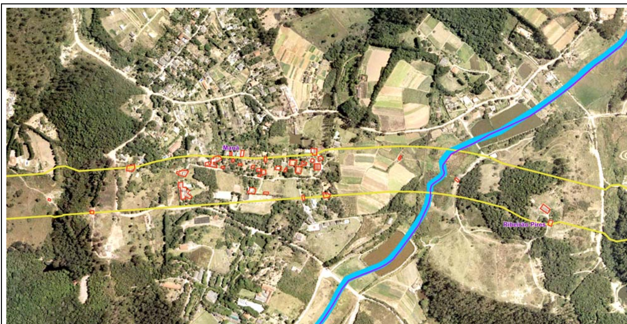
Imagem 7: Edificações do bairro Recanto Vital Brasil e arredores na região da estrada Nossa Senhora do Pilar e rio Guaió - divisa dos municípios de Mauá e Ribeirão Pires
