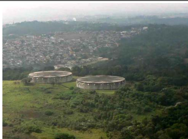
Foto 33: Reservatórios de água da SABESP para abastecimento público ao sul da franja urbanizada do município de Suzano.
