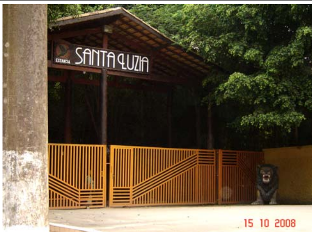
Foto 27: Detalhe da entrada do Hotel e Estância Santa Luzia na Avenida Nossa Senhora do Pilar, município de Mauá.
