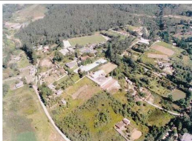
Foto 28: Visão área das instalações do Hotel e Estância Santa Luzia disponível no site da própria empresa.
