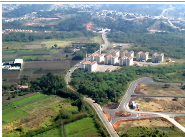
Foto 35: Conjunto Habitacional não ocupado e Loteamento Quaresmeira em implantação, município de Suzano. Ao fundo várzea do Rio Guaió atravessado pela Estrada de Santa Mônica.
