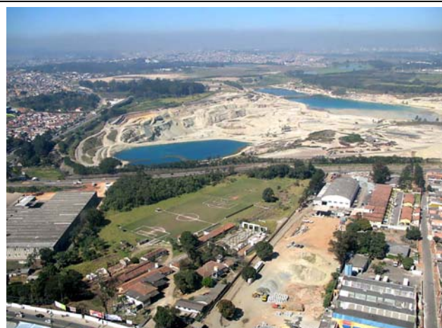
Foto 54: Usos industriais e comerciais e terrenos abandonados ao longo da SP-056 – Estrada de Santa Isabel. Ao fundo as cavas de mineração.
