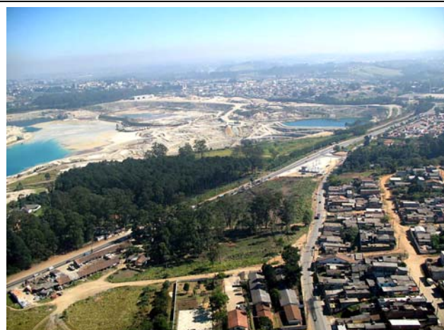
Foto 53: Bairros em consolidação ao longo da ligação Ayrton Senna - Poá (em Implantação pelo DER). Bairros Campo Limpo e do Mandi. Do outro lado da avenida as cavas de mineração. Em meio à vegetação localiza-se a Fazenda Casa Grande Velha.
