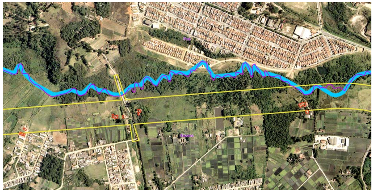
Imagem 11: Edificações isoladas na várzea do rio Guaió – divisa de municípios entre Poá e Suzano.
