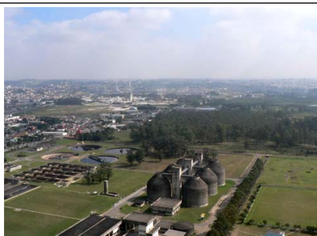
Foto 41: Instalações da Estação de Tratamento de Esgoto (ETE) da SABESP em Suzano, na várzea do Rio Tietê. Ao fundo os bairros consolidados de Vila Lúcia e Maria de Magi.
