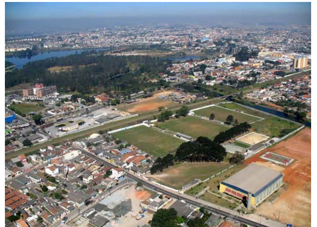
Foto 56: Estrada de Santa Isabel e ferrovia (ramal de cargas da MRS) atravessando áreas urbanas consolidadas e o Rio Tietê em direção ao centro da cidade. Em destaque o Ginásio Municipal.
