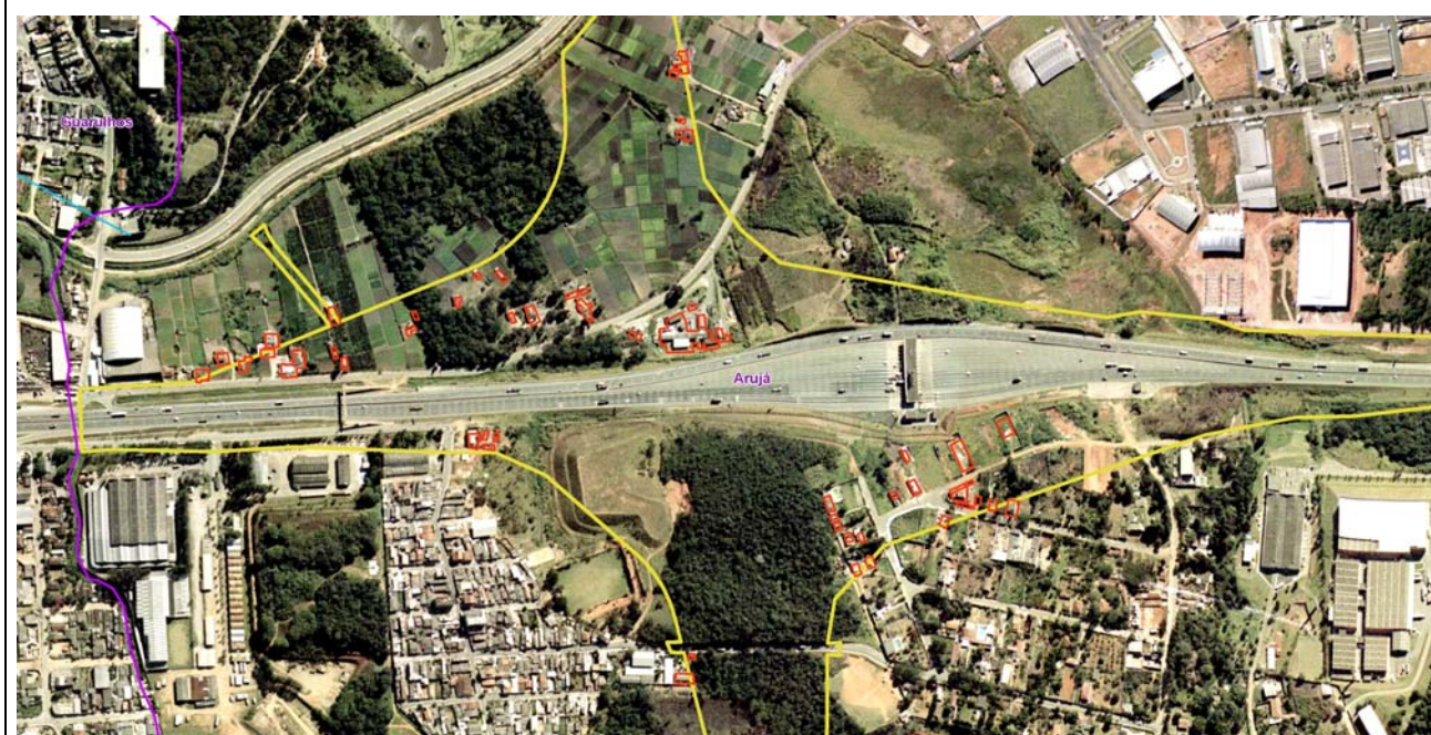
Imagem 22: Edificações ao longo da rodovia Presidente Dutra, onde está prevista a implantação da interseção do trecho Leste do Rodoanel. Bairros Cidade Aracília, Jardim Emília, Jardim Leica, Jardim Jóia, Jardim Tupi – Arujá
