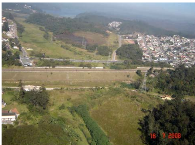
Foto 07: Avenida Humberto de Campos e Ferrovia (CPTM) atravessando a várzea de córrego afluente ao ribeirão Pires e a linha de alta tensão.
