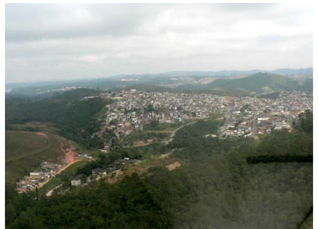
Foto 16: Visão parcial do núcleo de Bairros Jd. Lusitano, Jd. São Sebastião, Vila Real, entre outros, na franja urbana leste de Mauá avançando na divisa municipal com Ribeirão Pires.
