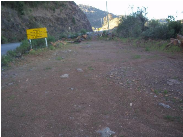
Foto 03: Área disponibilizada como depósito emergencial de eventuais escorregamentos de encostas, km 10+850 (LD), Lote III.
