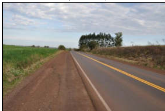
Foto 2. Trecho coincidente com a ERS-344 já em operação. Coord.: -28,203477° e -54,322472°.
