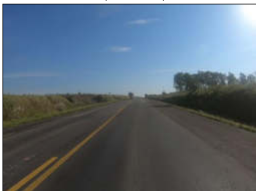
Foto 1. Trecho coincidente com a BR-392 já em operação. Coord.: -29,88952° e -53,731604°.
