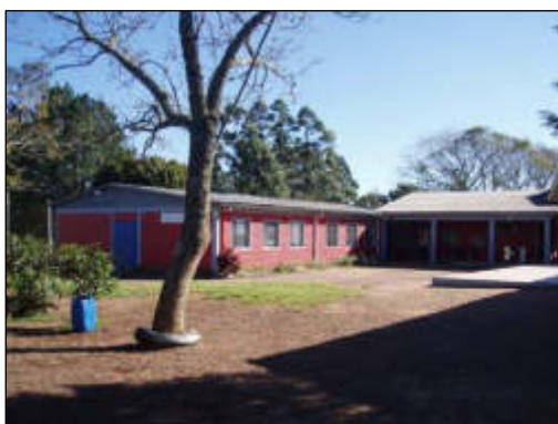
Foto 517. Escola Estadual de Ensino Fundamental Almiro Bretame no distrito Boca do Monte.
