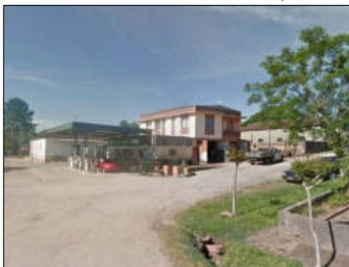
Foto 520. Acesso a Vila Block, São Sepé.
