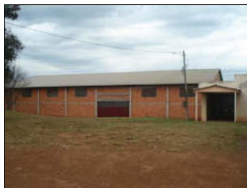
Foto 493. Salão comunitário da localidade de São João das Missões.
