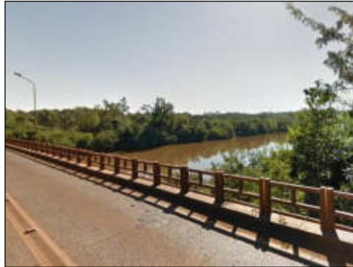
Foto 543. Ponte sobre o Rio Ijuí, entre Santo Ângelo e Entre-Ijuís.
