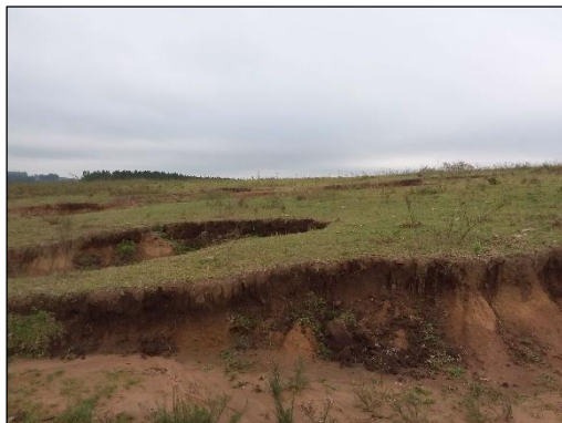
Foto 126. Processo erosivo de ravinamento, vista lateral. Coord.: -29,620873° e -54,053583°.
