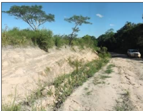
Foto 17. Talude em corte de estrada. Coord.: -29,785600° e -53,888300°.
