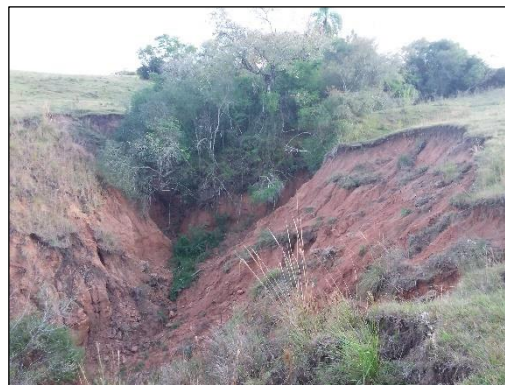
Foto 129. Voçoroca, vista lateral. Coord.: -29,702044° e -54,007477°.
