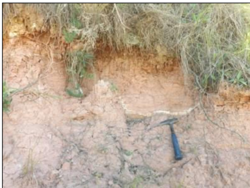
Foto 15. Talude em corte de estrada com rocha intemperizada. Coord.: -29,872400° e -53,739600°.
