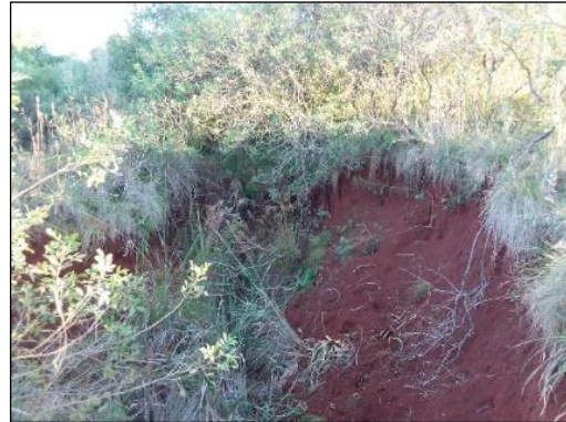
Foto 102. Ocorrência de ravinamento. Coord.: -28,583814° e -54,421993°.
