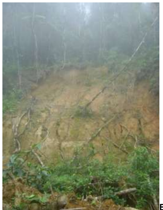
Figura 06 - Exemplos de deslizamento em que a cobertura vegetal atuou potencializando o efeitos dos deslizamentos após o solo ter se tornado saturado em água. Ponto 1EPC-25 (=2EPC-14). Deslizamento de massa de solo e blocos de rocha, em direção à estrada, em encosta muito íngreme. Pequenas ravinas cortam o solo. O deslizamento se deu na interface solo-rocha. Solo de pequena
