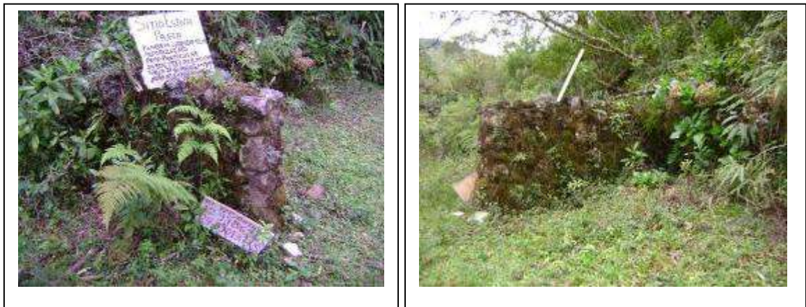
Figs. 13 e 14 Ruínas de muro de pedra
