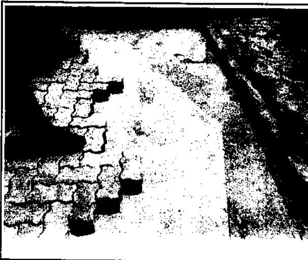
Foto 31: assentamento dos blocos intertravados de concreto (23°10'11.63"S / 44°50'23.34"O).
