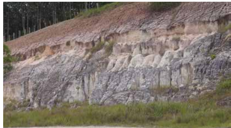
Erosão em sulcos e pequenas rupturas em talude da Formação Barreiras
