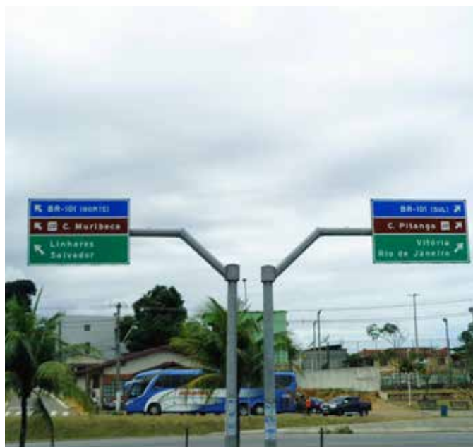
Acesso a BR-101/ES/BA Sentido Norte e Sul no município de Serra
