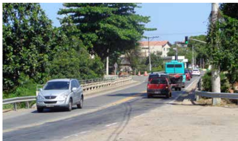
Tráfego intenso na BR-101/ES/BA, próxima à área urbana de Fundão, em trecho de travessia em ponte.
