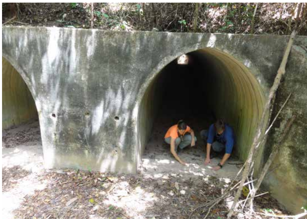
Avaliação de dispositivos de drenagem.
