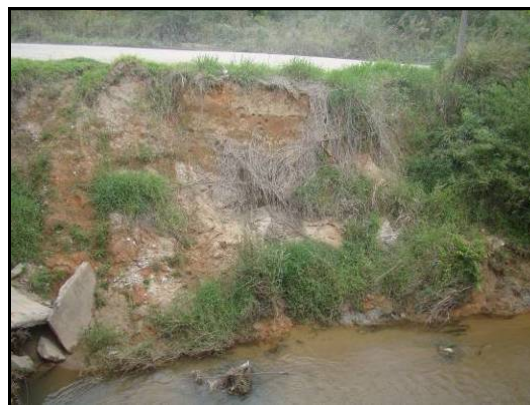
Figura 31: APP do rio Forquilha muito alterada, que será transposto pelo contorno. Nota-se nesse ponto que a área da APP, foi totalmente removida com ocorrência de processo erosivo ativo na ADA.
