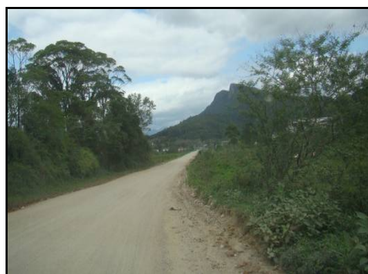
Figura 34: Vista da AID e ADA, sentido Palhoça/SC, onde a formação original foi totalmente descaracterizada.
