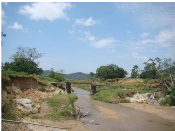
Figura 79: C10 - APP do ribeirão Forquilha em péssimo estado de conservação.
