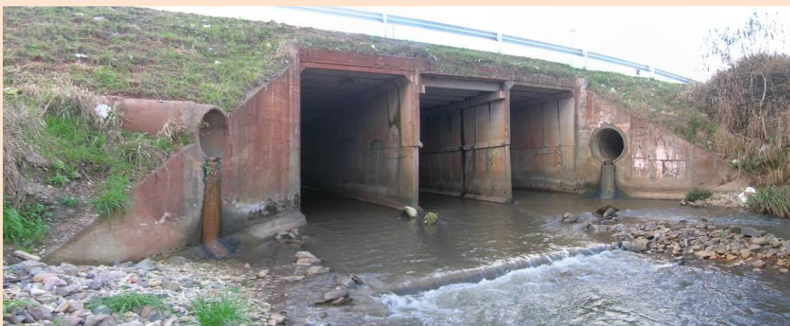
FIGURA 66 – DRENAGEM DO RIO PALMITAL SOBRE A BR-476 (ESTRADA DA RIBEIRA) NAS IMEDIAÇÕES DO PONTO OHL 06
