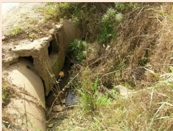
FIGURA 75 – CONFLUÊNCIA DE DRENAGENS A MONTANTE DO PONTO OHL 08
