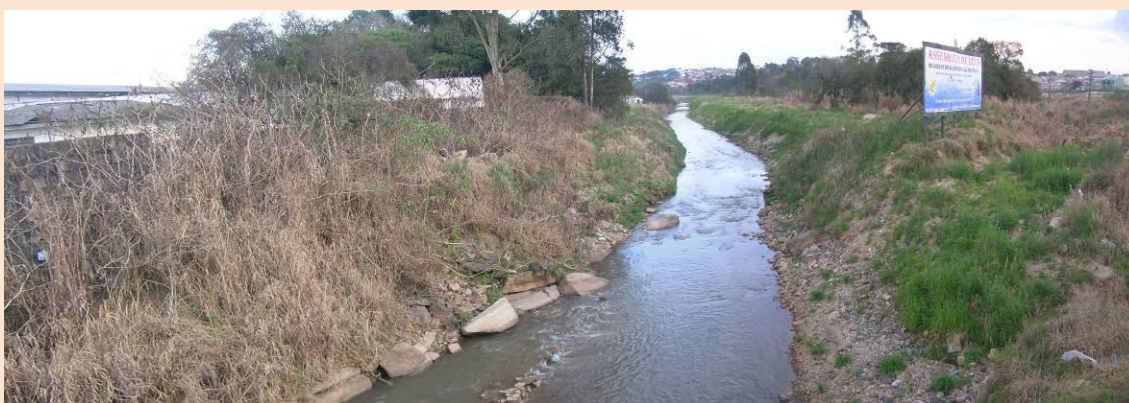
FIGURA 67 – DETALHES DA DRENAGEM DO RIO PALMITAL SOBRE A BR-476 (ESTRADA DA RIBEIRA) NAS IMEDIAÇÕES DO PONTO OHL 06
