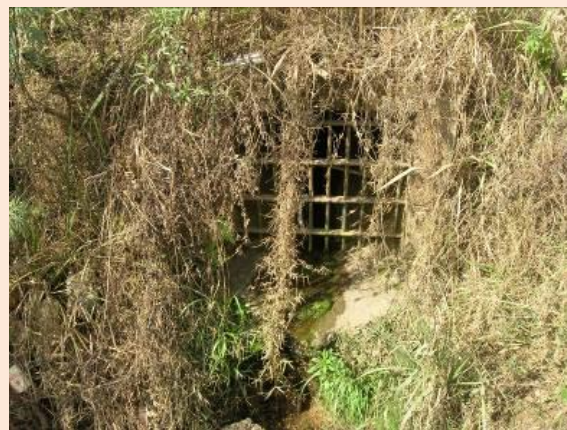
FIGURA 74 – DETALHE DA CONFLUÊNCIA DE DRENAGENS A MONTANTE DO PONTO OHL 08
