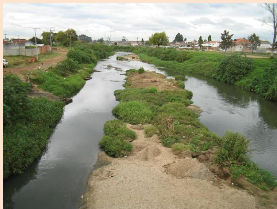
FIGURA 48 – BANCO DE AREIA EM TRECHO DO RIO ATUBA
