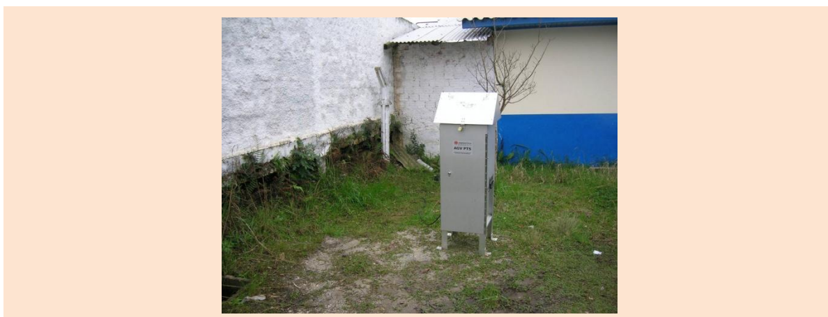
FIGURA 2 – AGV-PTS INSTALADO NA ESCOLA ESTADUAL DE GUARAITUBA
