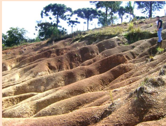
FIGURA 28 – SUPERFÍCIE COM DESENVOLVIMENTO DE EROSIÃO EM SULCOS E RAVINAS, PRESENTE NA FORMAÇÃO GUABIROTUBA, PLANALTO DE CURITIBA
