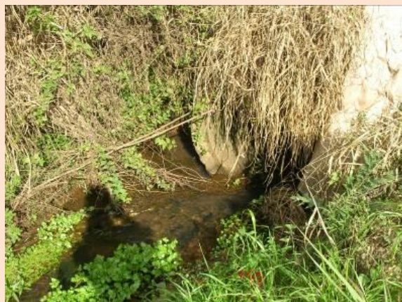
FIGURA 73 – CONFLUÊNCIA DE DRENAGENS A MONTANTE DO PONTO OHL 08
