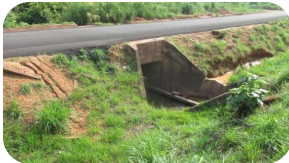
Travessia de drenagem com ocorrência de processos erosivos e assoreamento. Área classificada como de Inundação no centro urbano de Cacoal/RO devido ao represamento das águas dos rios pelo rio Machado (km 242,43)
