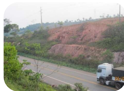
Corte em rochas graníticas alteradas com processos erosivos intensos (km 648,5) em área do município de Ouro Preto do Oeste/RO (3) e escorregamentos rotacionais em trechos de Ariquemes/RO (4).
