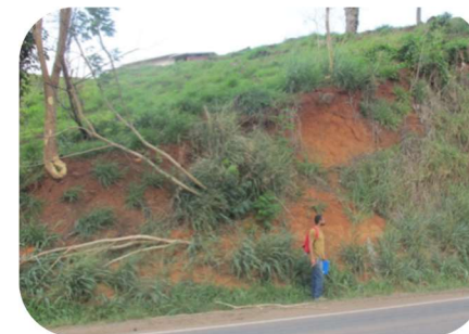
Corte em rochas graníticas alteradas com processos erosivos intensos (km 648,5) em área do município de Ouro Preto do Oeste/RO (3) e escorregamentos rotacionais em trechos de Ariquemes/RO (4).
