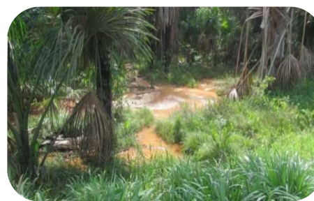
Travessia de Igarapé assoreado (km 109,05) em Chupinguaia/Pimenta Bueno/RO
