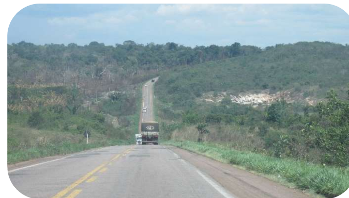
Vista de uma voçoroca localizada à direita da BR-364 e da foto acima, em trecho de desnível mais acentuado (km 117) em área do Município de Pimenta Bueno/RO
