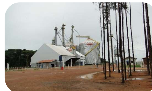
Silo de grãos Kagioli, Comodoro/MT
