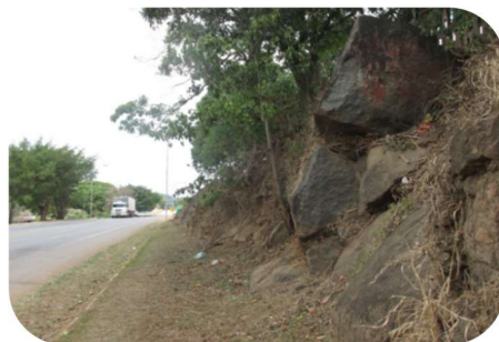
Relevos de colinas e morros baixos, com blocos adjacentes à rodovia e processos erosivos em zona de cabeceira de drenagem (km 546), em Alto Paraíso/Rio Creso/RO (1). Blocos instáveis em corte da BR-364 em Ouro Preto d'Oeste (2).
