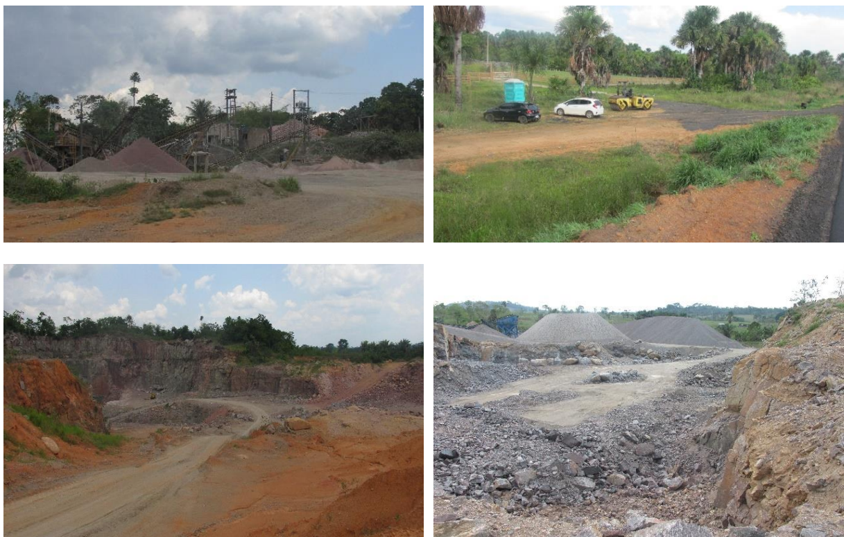
Figura 3: Visão Geral de Áreas de Apoio a Obras de Adequação do BR-364
