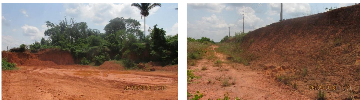
Figura 1: Áreas de Empréstimo em locais de ocorrência de Coberturas Detrito-Lateríticas em Candeias do Jamari/RO
