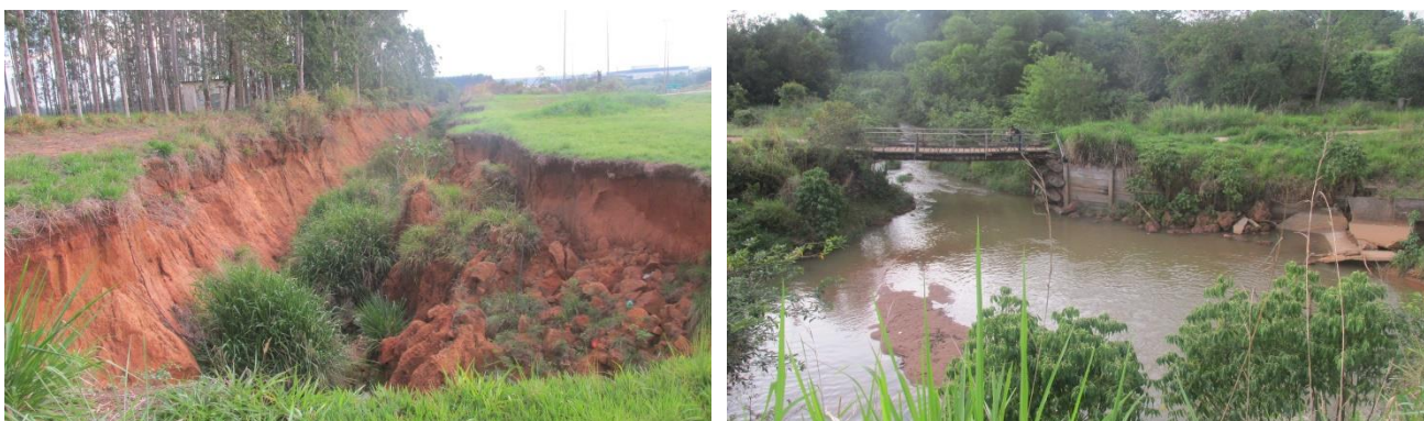
Figura 6: Voçoroca formada a partir de fluxos d'água laterais e paralelos à rodovia BR-364 MT/RO em zona urbana de Vilhena (foto à esquerda) e igarapé assoreado por material proveniente da voçoroca e com processos erosivos a jusante (foto à direita).
