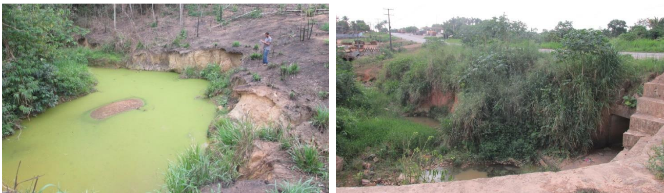
Figura 5: Processos erosivos em margens de igarapé e em taludes de aterro em zonas periurbana e urbana de Ji-Paraná, ao longo da rodovia BR-364. Na foto da esquerda ainda se notam evidências de processo de eutrofização pelo aporte de nutrientes orgânicos, além de assoreamento do corpo d'água.
