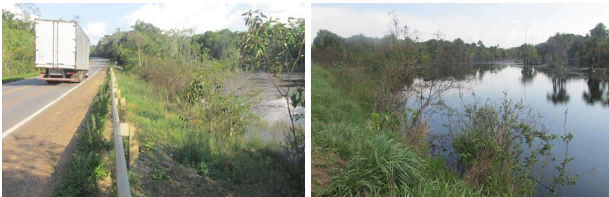
Figura 13: Travessias de igarapé com alagamentos à montante devido à insuficiência de dispositivo de drenagem em Comodoro (foto à esquerda) e em Vilhena (foto à direita).
