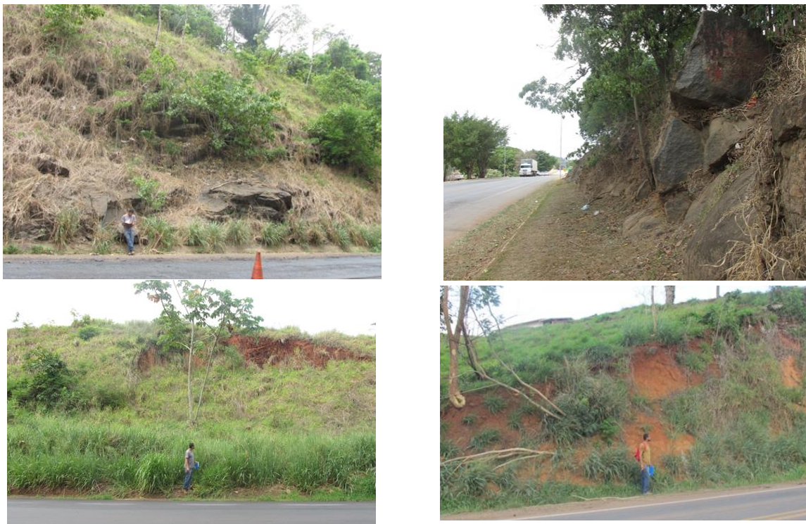
Figura 9: Movimentos de Massas em taludes de corte ao longo da rodovia BR-364 MT/RO, com blocos rolados nos trechos de Jarú/Theobroma (foto acima e à esquerda) e Ouro Preto d'Oeste (acima à direita) e escorregamentos rotacionais em trechos de Cacaulândia/Ariquemes (foto abaixo e à esquerda) e Ariquemes (foto abaixo e à direita).
