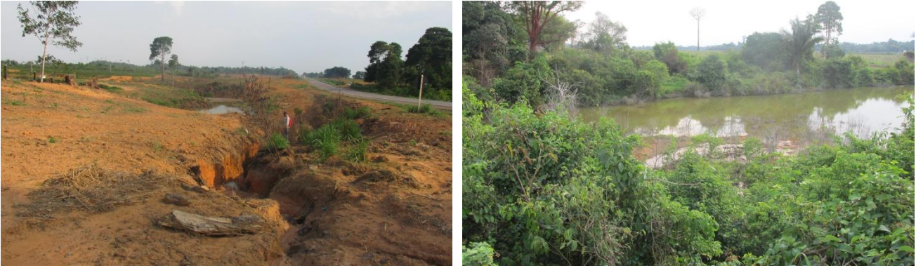
Figura 7: Processos erosivos intensos, paralelos e à montante da rodovia BR-364 MT/RO (foto à esquerda) e à jusante assoreamento do corpo d'água (foto à direita) em trecho de Alto Paraíso/Rio Crespo
