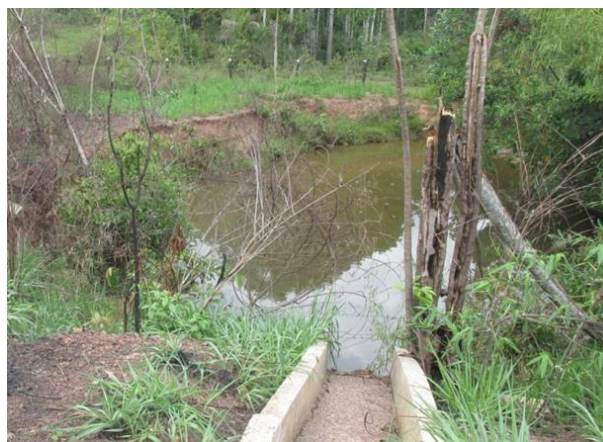
Figura 12: Processos erosivos em taludes sobre travessias de igarapés, bem como em margens de drenagens a jusante destes, por insuficiência de dispositivo de drenagem, ademais de insuficiência de disciplinamento das águas provenientes da pista (trecho de Cacoal em foto à esquerda e de Pimenta Bueno à direita)
