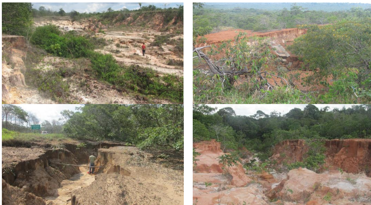
Figura 10: Voçorocas com dezenas de metros de extensão formadas com contribuição de drenagens da rodovia em Pimenta Bueno (foto acima e à esquerda), Vilhena (foto acima e à direita), Comodoro (foto abaixo e à esquerda) e novamente Vilhena (foto abaixo e à direita).
