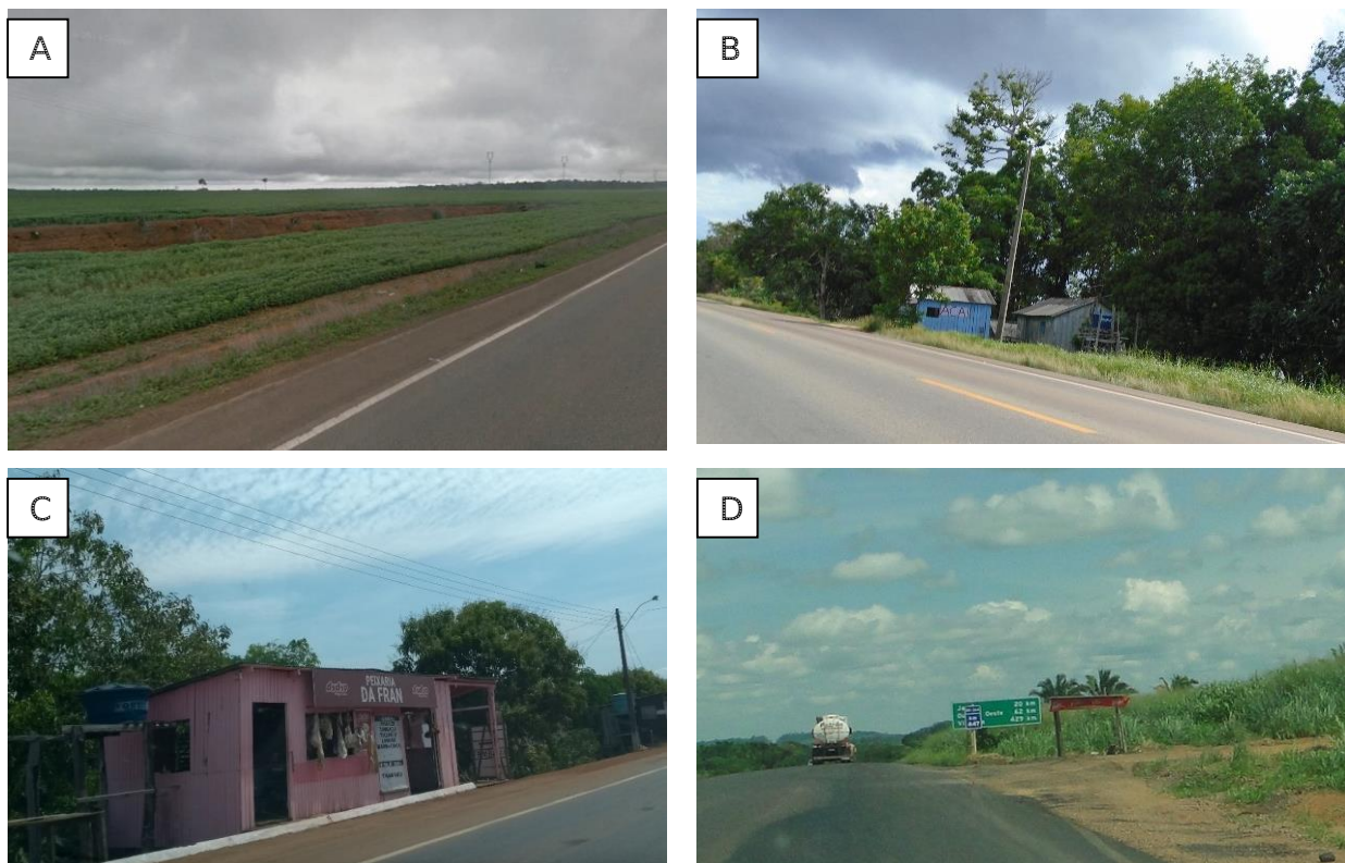
Figura 36: Principais tipologias de passivos do meio socioeconômico: (A) cultivos (B e C) edificações e (D) abrigos lindeiros à faixa de domínio
