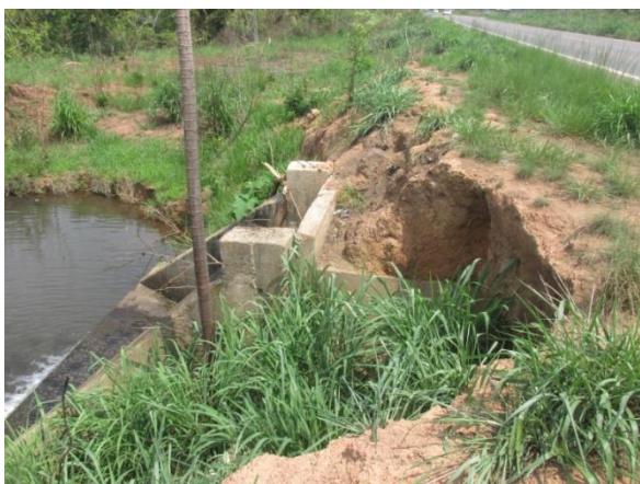
Figura 12: Processos erosivos em taludes sobre travessias de igarapés, bem como em margens de drenagens a jusante destes, por insuficiência de dispositivo de drenagem, ademais de insuficiência de disciplinamento das águas provenientes da pista (trecho de Cacoal em foto à esquerda e de Pimenta Bueno à direita)
