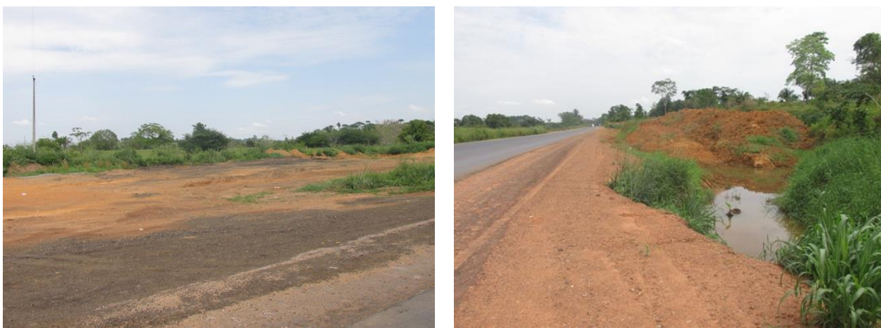
Figura 18: Canteiro de obras em desuso não totalmente recuperado em Jaru/Theobroma (foto à esquerda), e pilhas de materiais excedentes de obras, em Cacaúlândia (foto à direita).
