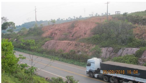
Figura 53: À esquerda corte em rochas alteradas da Suíte Alto Candeias com processos erosivos intensos (km 648,5) e à direita matacões em meio superfície de aplainamento (altura do km 670,5), ambos em área do Município de Candeias do Jamari
