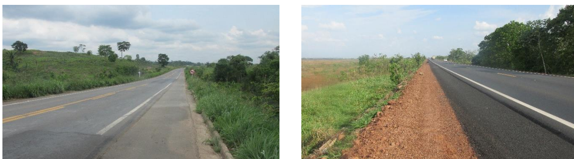
Figura 42:À esquerda Relevo de Superfícies aplainadas com processos erosivos em sulcos e ravinas ao longo de encostas (km 219) e à direita relevo em Baixos Platôs com processos erosivos incipientes (km 173)
