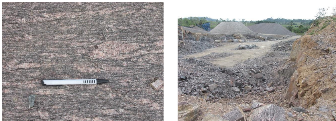
Figura 54: Pedreira em exploração de rochas da Suíte Serra da Providência para uso em obras de readequação da BR-364 (altura do km 395,5), no Município de Ouro Preto do Oeste/RO
