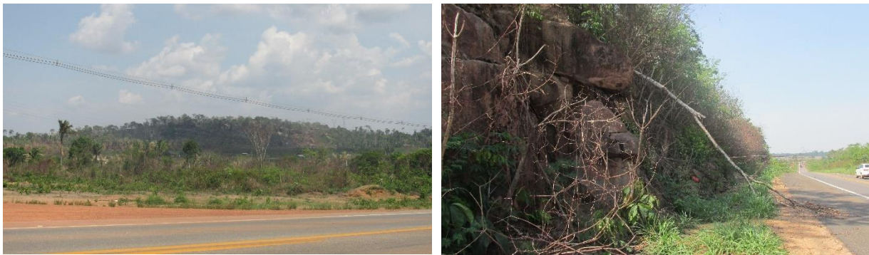
Figura 44: À esquerda relevo de Superfície aplainadas degradadas, vista a partir da rodovia BR 364, onde notam-se campos de blocos (km 575), Itapuã do Oeste. À direita, Blocos instáveis em corte da BR-364 (km 545) em travessia de relevo de Colinas dissecadas e morros baixos
