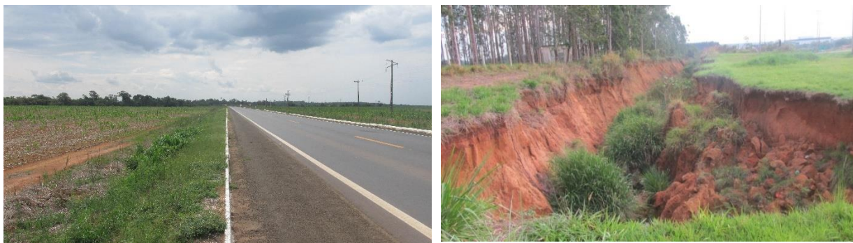
Figura 38: Relevo de Chapadas e platôs nas proximidades do km 42 da BR-363, em Vilhena (foto à esquerda) e voçoroca desenvolvida nos limites do padrão de relevo de Chapadas e Platôs-Planaltos, nas proximidades da cidade de Vilhena por mal disciplinamento das águas pluviais laterais à rodovia
