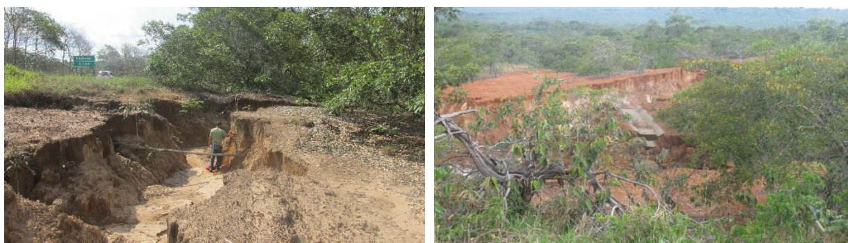
Figura 60: Processos erosivos lineares do tipo voçoroca, adjacentes BR-364 em área de ocorrências dos arenitos da Formação Utiariti. À esquerda km 1313, em Comodoro/MT e km 46, em Vilhena/RO
