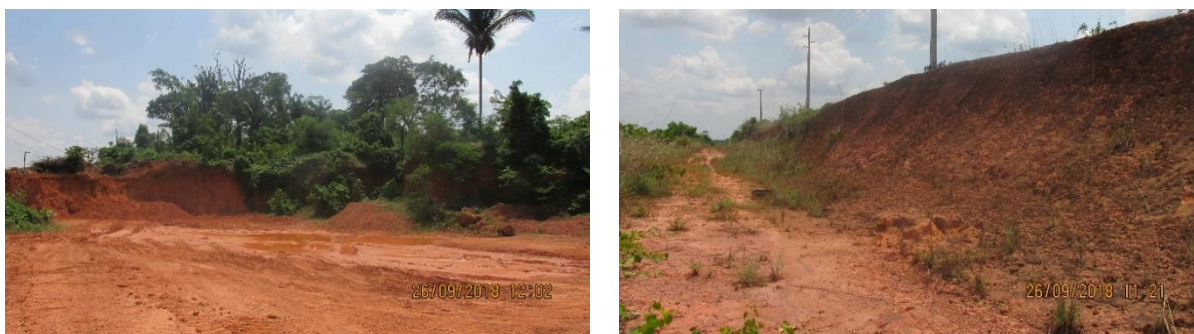
Figura 61: Áreas de Empréstimo em locais de ocorrência de Coberturas Detrito-Lateríticas em Candeias do Jamari/RO
