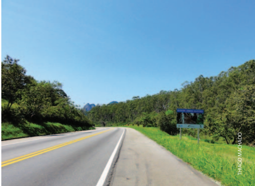
Trecho da Rodovia BR-101 próximo ao km 185.
