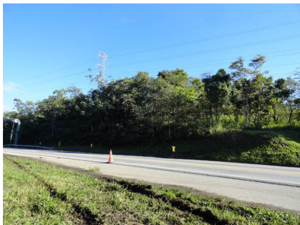
Foto 7.2.2-145. Vista parcial do fragmento inserido no km184+500.
