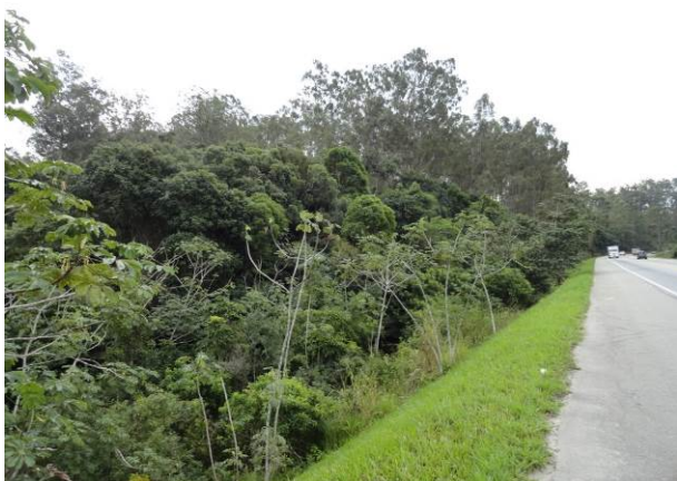
Foto 7.2.2-161. Vista parcial do fragmento inserido no km186+300.
