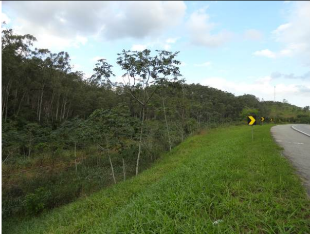
Foto 7.2.2-265. Exemplos arbóreos isolados a serem suprimidos ( Cecropia glaziovii – embaúba-vermelha) inseridos em talude de aterro.
