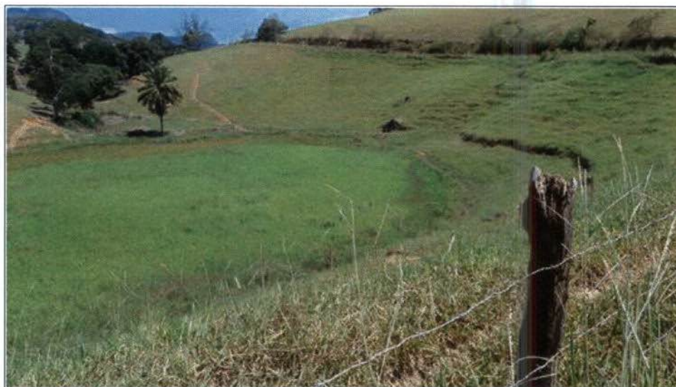
Figura 10. Vista parcial final do trecho com ocorrência de lagoa artificial de acumulação de água com indícios de assoreamento por onde passará o empreendimento rodoviário.
