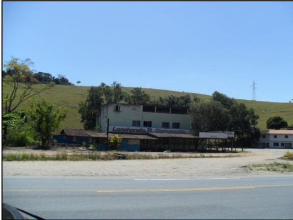
Estabelecimento comercial desativado às margens da BR 101/ES.
