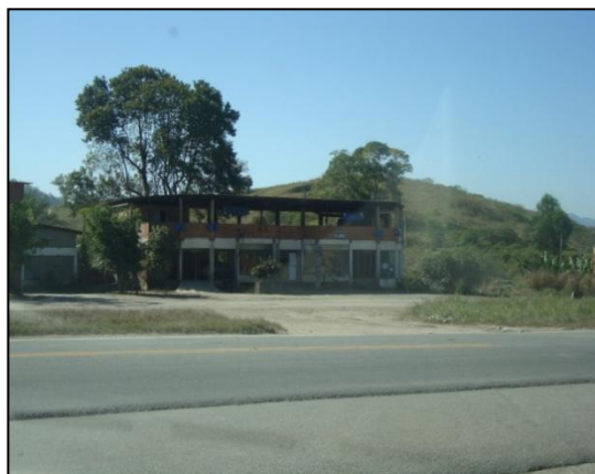
Posto de Combustível e Comércio Desativados, nas margens da BR 101/ES
