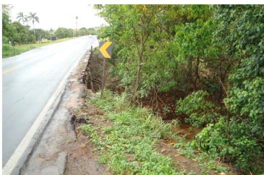
Foto 3. Ponte com barreira de proteção danificada
