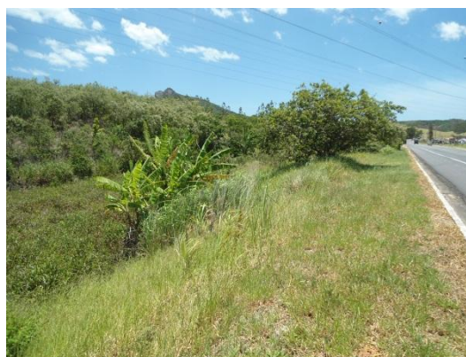
Foto 16. - Vista a jusante
