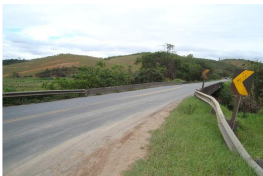
Foto 58. Ponte sobre o Rio Novo
