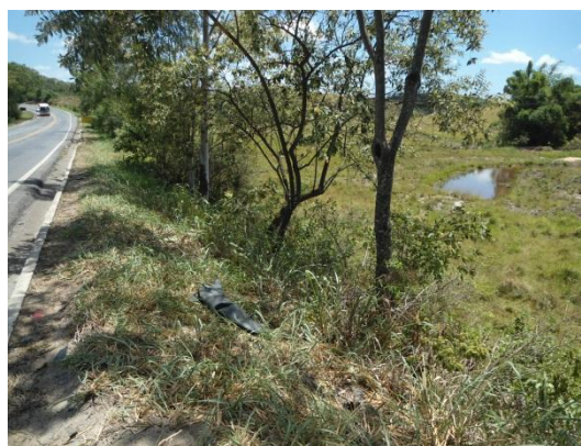
Foto 4. - Área de alagamento a jusante da rodovia
