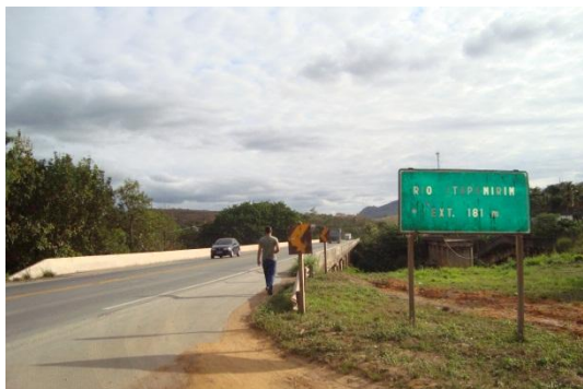
Foto 68. Ponte sobre Rio Itapemirim
