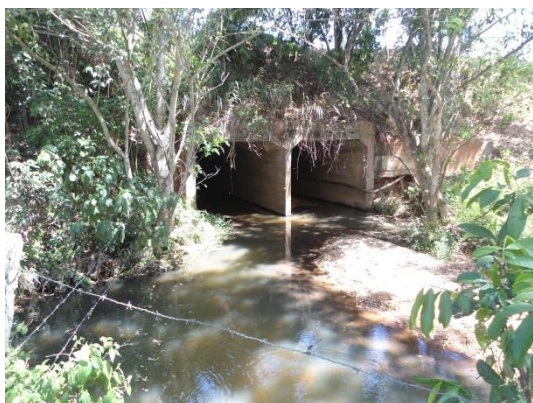
Foto 76. Vista do córrego a montante com destaque para o Bueiro Duplo Celular de Concreto BDCC.
