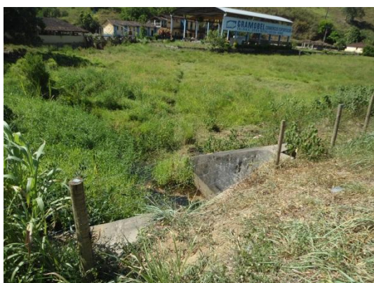
Foto 81. Vista do córrego a montante da rodovia
