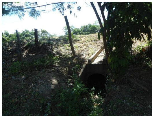
Foto 73. Vista do bueiro da rodovia, com destaque para a falta de água passando por ele
