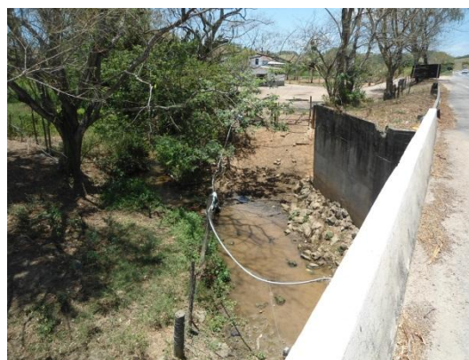
Foto 57. Vista a jusante, com propriedade rural ao fundo
