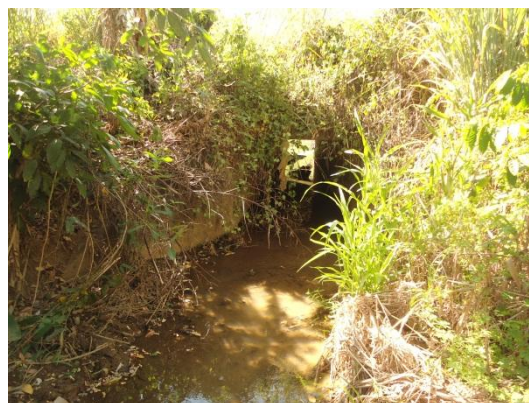
Foto 86. Vista do córrego a jusante, com destaque para a galeria simples usada pela rodovia para transpô-lo.
