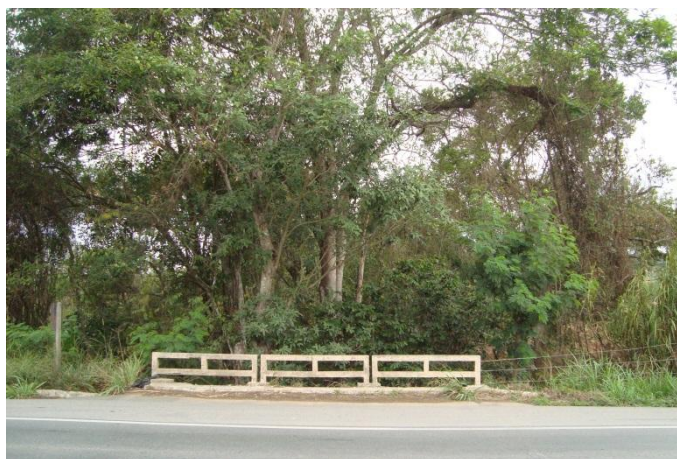
Foto 65. Ponte sobre poço das Antas
