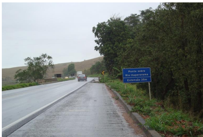
Foto 37. Ponte sobre o Rio Itaperorama
