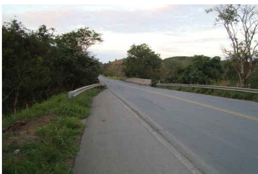
Foto 74. Ponte sobre Rio Muqui do Norte
