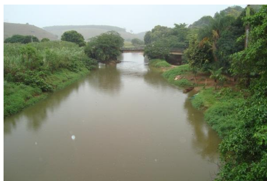
Foto 34. Vista do Rio Benevente sobre a ponte
