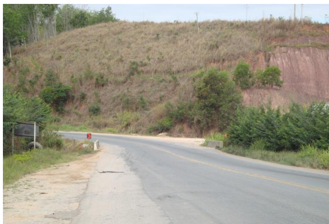
Foto 64. Ponte sobre córrego em área alagável
