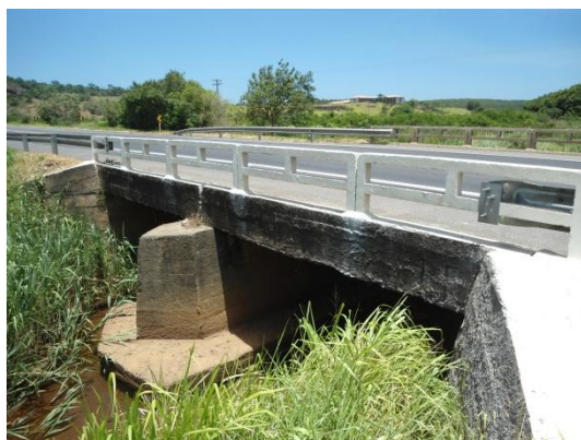
Foto 17. - Ponte sobre o córrego Iguapé.
