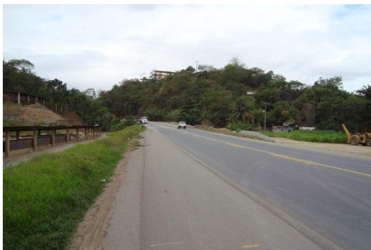
Foto 54. Ponte sobre córrego ao fundo
