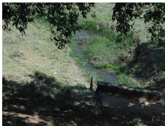
Foto 28. Vista da saída do bueiro, a jusante da rodovia.
