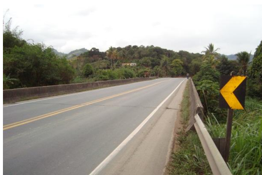
Foto 48. Ponte sobre Rio Itapoama
