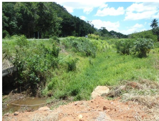
Foto 10. - Bueiro Simples Celular de Concreto BSCC com pequeno volume de água a jusante
