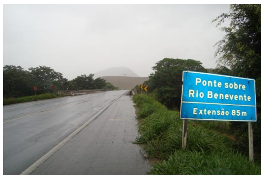
Foto 33. Ponte sobre Rio Benevente
