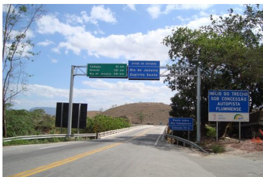
Foto 91. Ponte sobre Rio Itabapoana
