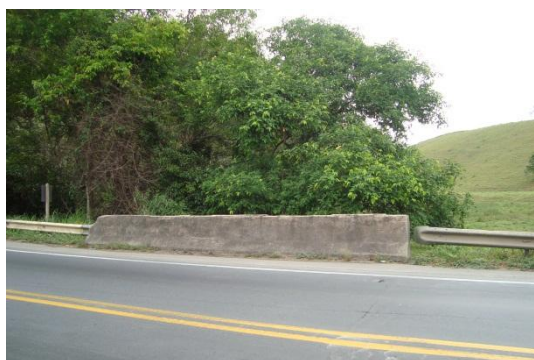
Foto 46. Ponte sobre córrego Tocaia
