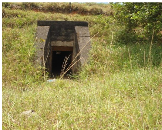
Foto 7. – Bueiro Simples Celular de Concreto BSCC seco a montante
