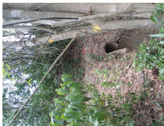
Foto 61. Bueiro Simples Celular Tubular BSCT da rodovia que transpõe o córrego
