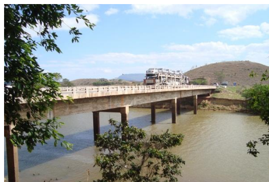
Foto 92. Visão lateral da ponte
