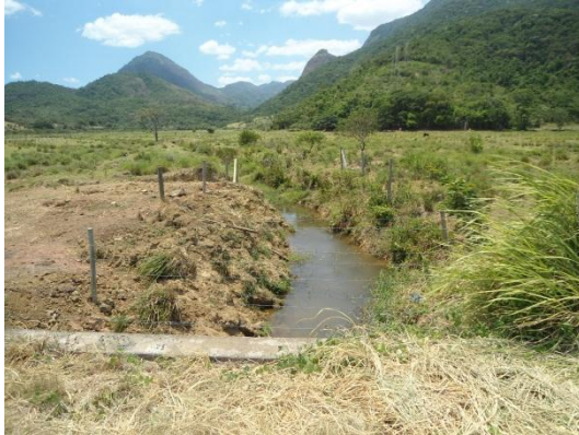
Foto 21. - Vista do córrego a montante da rodovia, evidenciando o pasto e o solo exposto.
