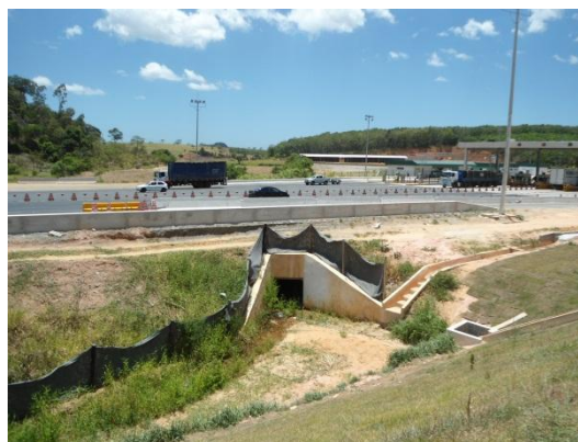
Foto 12. - Vista geral do ponto, com a galeria a montante, a praça de pedágio e o pátio de serviços da concessionária ao fundo.
