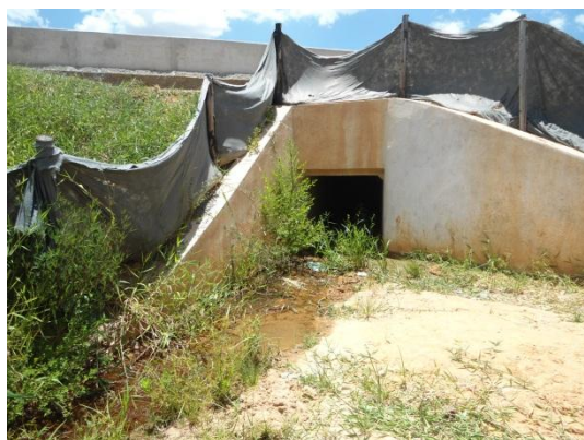
Foto 11. - Bueiro Simples Celular de Concreto BSCC a montante com pequeno volume de água
