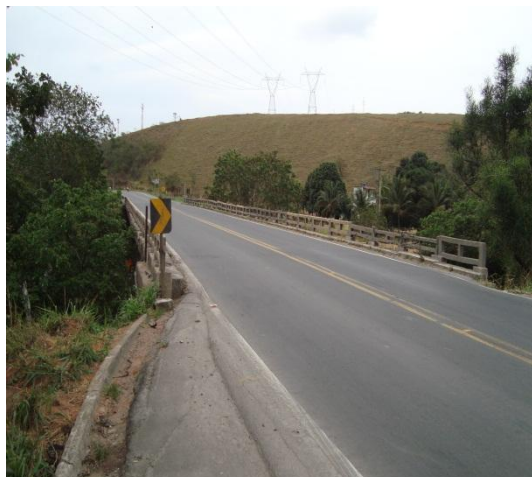
Foto 1. Ponte sobre o Rio Jucu
