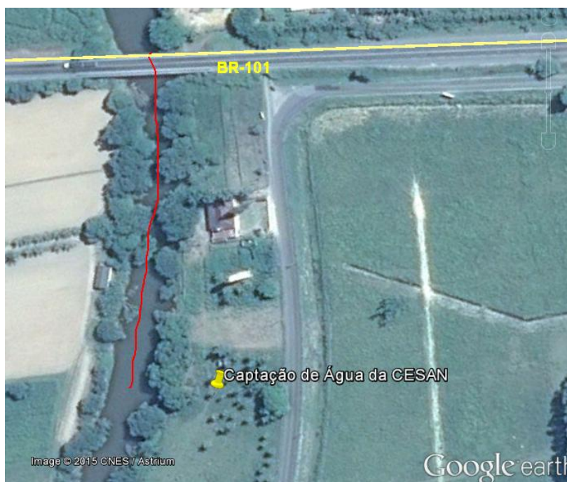
Figura 2 - Captação de Água CESAN
