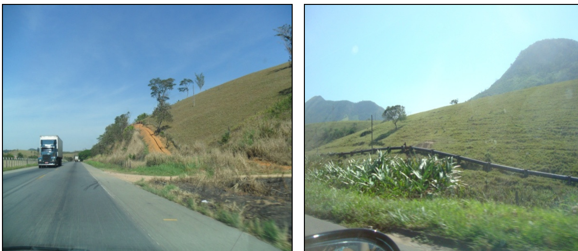
Foto 7-1. Detalhe da instalação de cabos óticos e da presença de gasoduto nas margens da BR 101/ES
