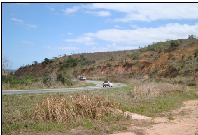
Foto 7-5. Exemplo de taludes em Mimoso do Sul
