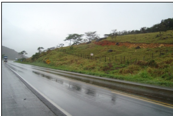
Foto 7-27. Talude formado por solo coluvial e afloramento de rocha às margens da rodovia
