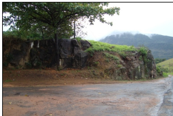
Foto 7-27. Talude formado por solo coluvial e afloramento de rocha às margens da rodovia
