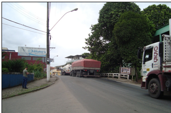
Foto 7-22. Transposição do rio Iconha na cidade de mesmo nome. Observa-se o grande fluxo de veículos pesados atravessando uma ponte de mão dupla e a necessidade da resolução do problema.
