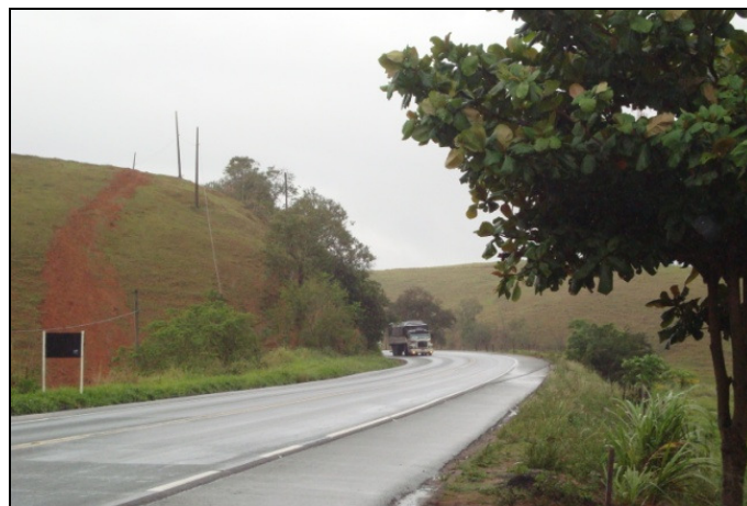
Foto 7-26. Exemplo de taludes de médio porte.
