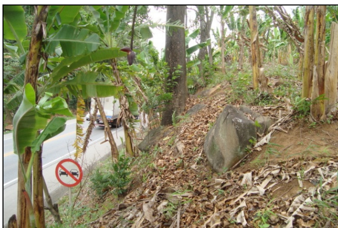
Foto 7-20. Em primeiro plano observam-se os matacões de granito em situação de risco, em segundo plano e em situação topográfica inferior a BR-101/ES (Ponto 54)
