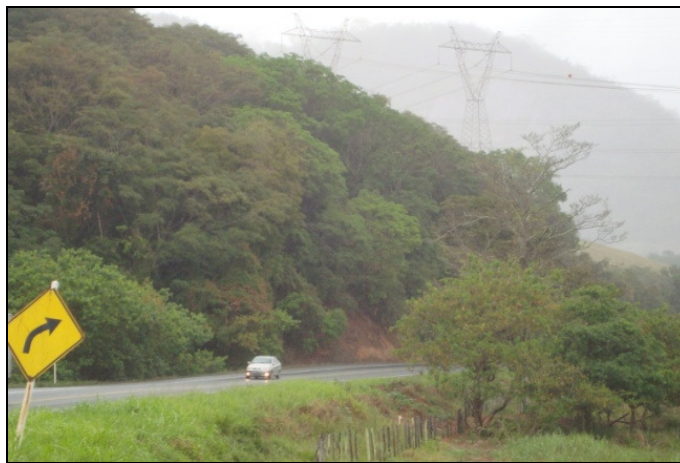
Foto 7-25. Talude de grande dimensão no ponto 35 que merece atenção.
