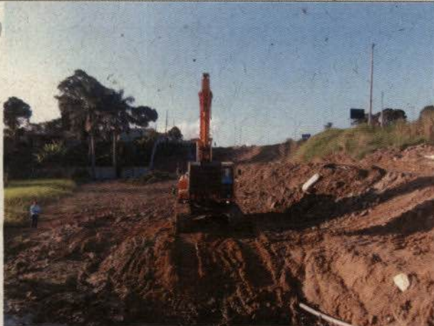
Foto n°03 – Vista do maquinário em área de APP do Córrego Alegre.
