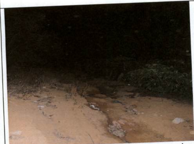
Foto 05 – Voçoroca causada pelas águas oriundas da caixa de drenagem
