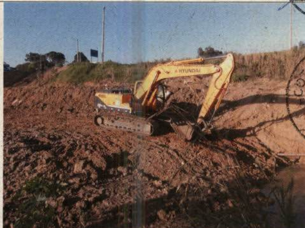
Foto n°02 - Vista do maquinário em área de APP do Córrego Alegre.
