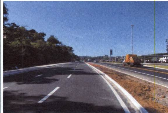
Foto 02: Vista depois da marginal instalada pista Norte no município da Serra - Km 255+300.
