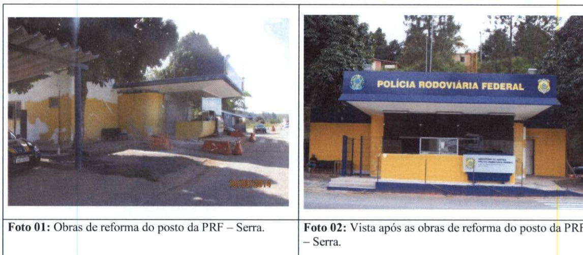
Figura 3.0.d Registro Fotográfico das Obras de Reforma da PRF
