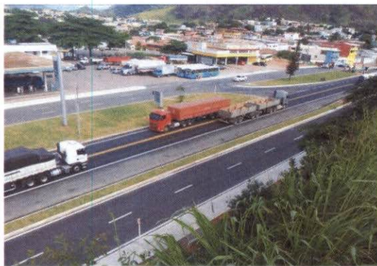
Foto 03: Vista das marginais instaladas no Km 255+300.
