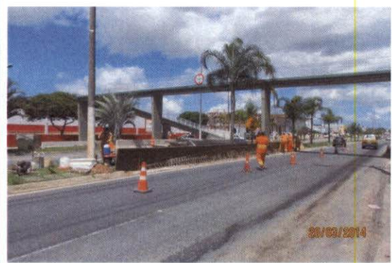
Foto 06: Vista da reforma da passarela no Km 149+000 no município de Linhares.
