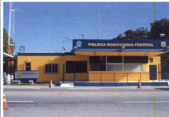
Foto 04: Vista do posto depois das obras de reforma da PRF-Linhares.
