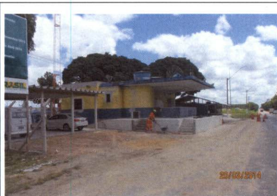
Foto 01: Obras de reforma do posto da PRF – São Mateus.
