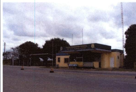
Foto 03: Vista do posto da PRF- Linhares antes das obras de reforma.
