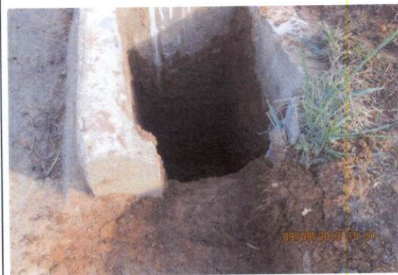
Foto 12: Vista dos sistema de drenagem depois da limpeza.
