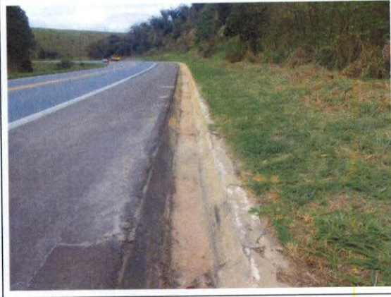
Foto 08: Vista da reforma do posto da PRF – Serra no Km 304+600.
