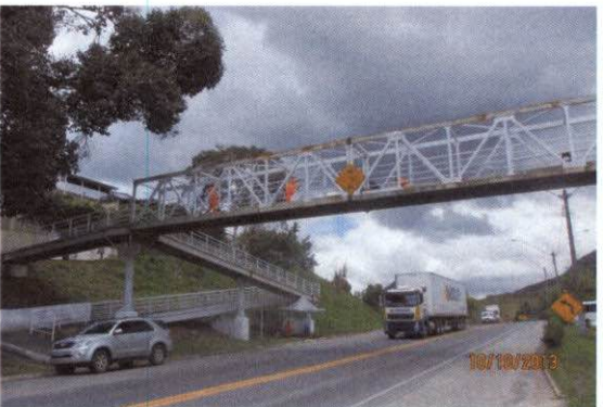
Foto 05: Reforma da passarela no Km 204+000 município de João Neiva.
