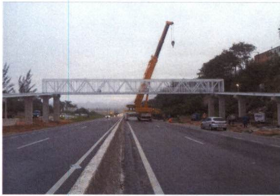
Foto 01: Instalação da passarela no Km 271+800 em Serra.
