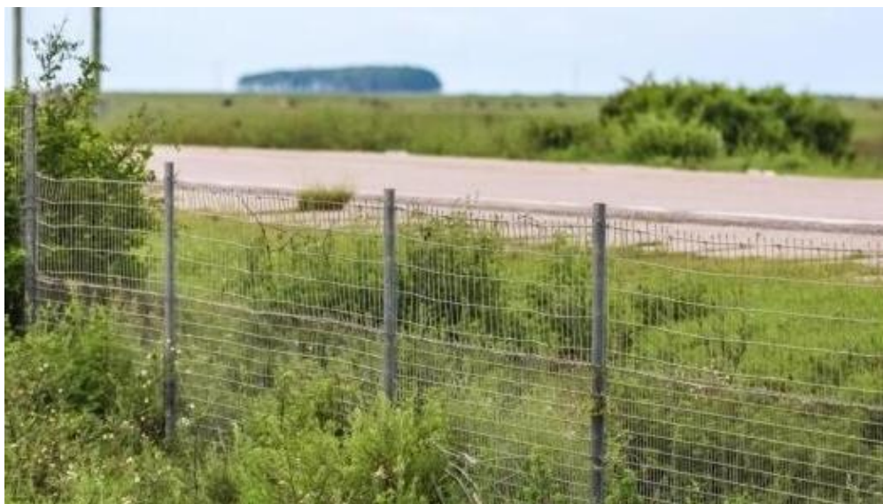
Figura 5.418. Cerca condutora de fauna instalada na rodovia BR-471 no Taim. Foto: Fábio Gomes.
