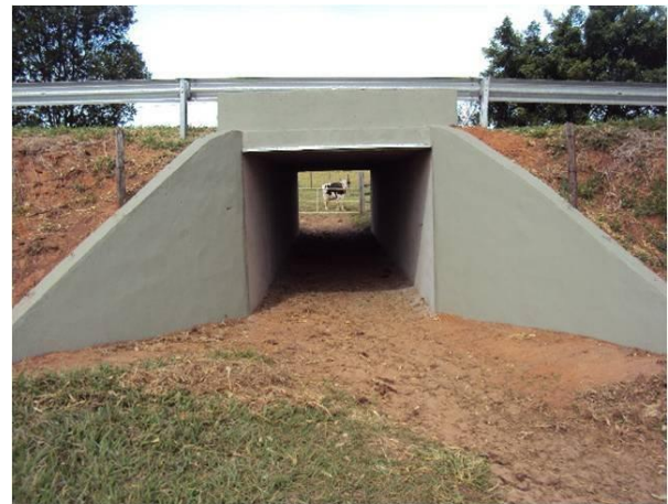
Figura 5.424- Passagem de fauna (passa gado) instalada na rodovia SP-300/BR. Foto: http://www.viarondon.com.br
