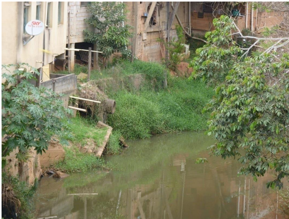
Figura 5.213 - Canos de lançamento de esgoto não tratado no rio São Luiz.
