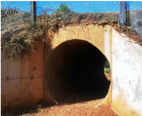
Figura 5.423- Passagem de fauna “inferior” instalada sob ferrovia no sul de Mato Grosso/BR. Foto: Andrey Gabriel.
