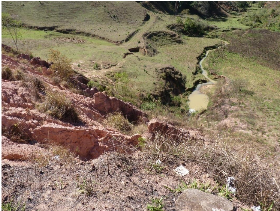
Figura 5.218 - Pequeno corpo d'água interceptado pela BR-262, assoreado pela erosão do talude da rodovia e com ausência de vegetação ciliar.
