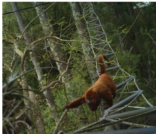
Figura 5.426- Exemplo de passagem de fauna aérea Foto: Acervo do Programa Macacos Urbanos.
