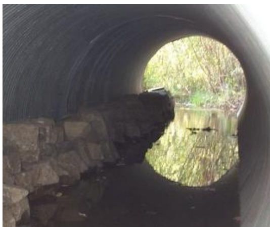
Figura 5.419- Passagem de fauna tipo galeria instalada na rodovia Territorial Hwy-Oregon/EUA. Foto: John Levenhagen.
