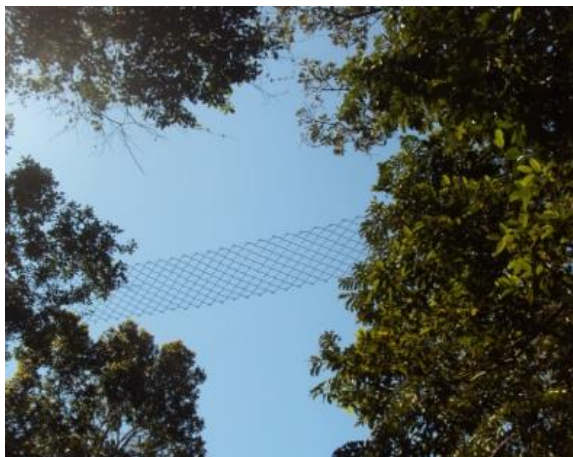
Figura 5.425- Passagem de fauna aérea instalada na rodovia BA-001/BR. Foto: Sandoval Mendes.
