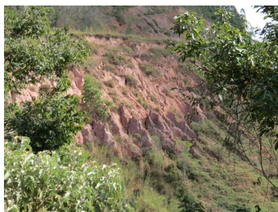
Figura 5.245 - Talude da rodovia erodido, com sedimento carregado para o leito do córrego.
