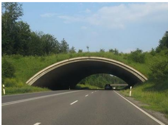
Figura 5.427- Eco duto instalado na rodovia 464/Alemanha. Foto: Klaus Foel.
