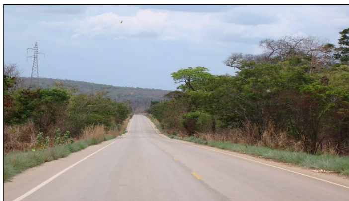
Figura 5.15: Vista de parte do trecho pavimentado da BR-135.
