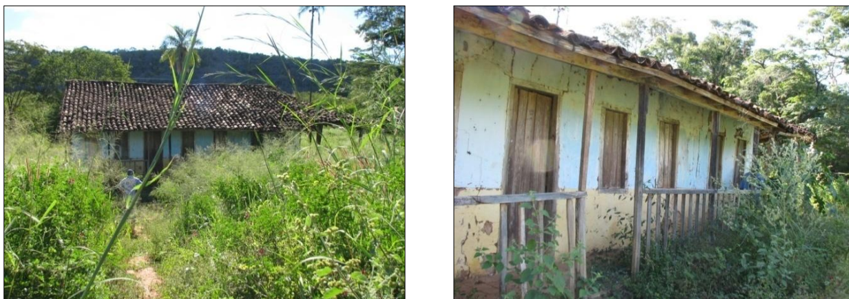
Figura 5.75: Detalhes de antiga residência presente na AID
