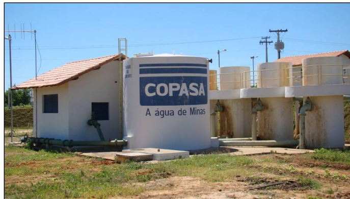
Figura 5.21: Instalações da Copasa responsável pelo abastecimento de água de Itacarambí.
