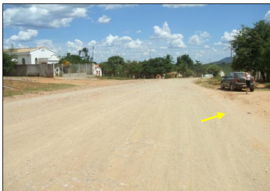
Figura 5.109: 2º Acesso vista sentido Itacarambi
