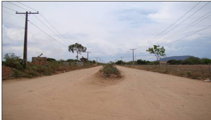
Figura 5.6: Fim do trecho da BR-135 a ser pavimentado, próximo a área urbana de Itacarambi
