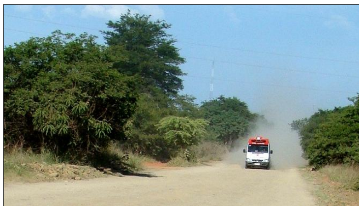
Figura 5.46: Ambulância do SAMU 192 percorrendo trecho da BR-135.
