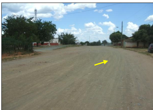
Figura 5.111: 3º Acesso vista sentido Itacarambi
