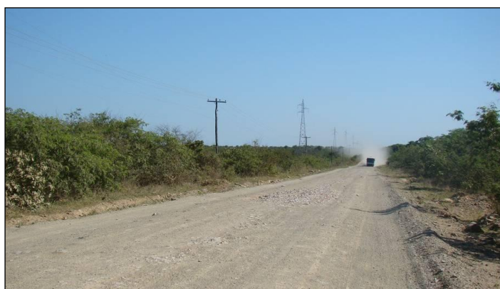
Figura 5.16: Vista de parte do trecho sem pavimentação da BR-135.
