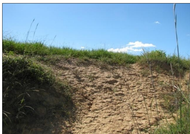
Figura 5.61 e Figura 5.62: Áreas com focos de erosão, cortes e taludes na ADA (São João das Missões e Manga)
