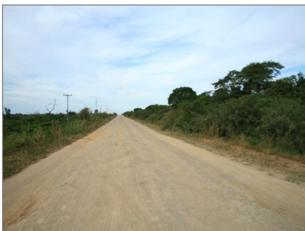
Vista geral da vegetação nas duas margens da rodovia entre Manga e São João das Missões na ADA.
