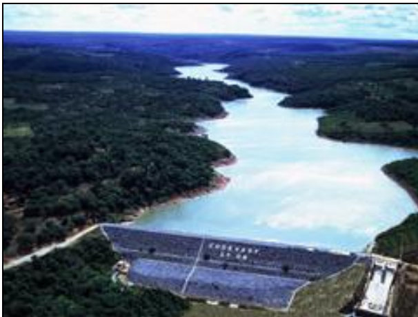
Figura 5.79: Barragem de Itacarambi.
