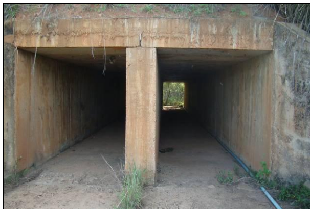
Figura 5.83: Galerias de Drenagem sob a BR-135 em drenagem intermitente
