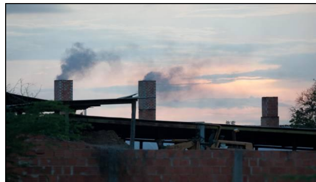
Figura 5.26: Chaminés dos fornos da Serran.
