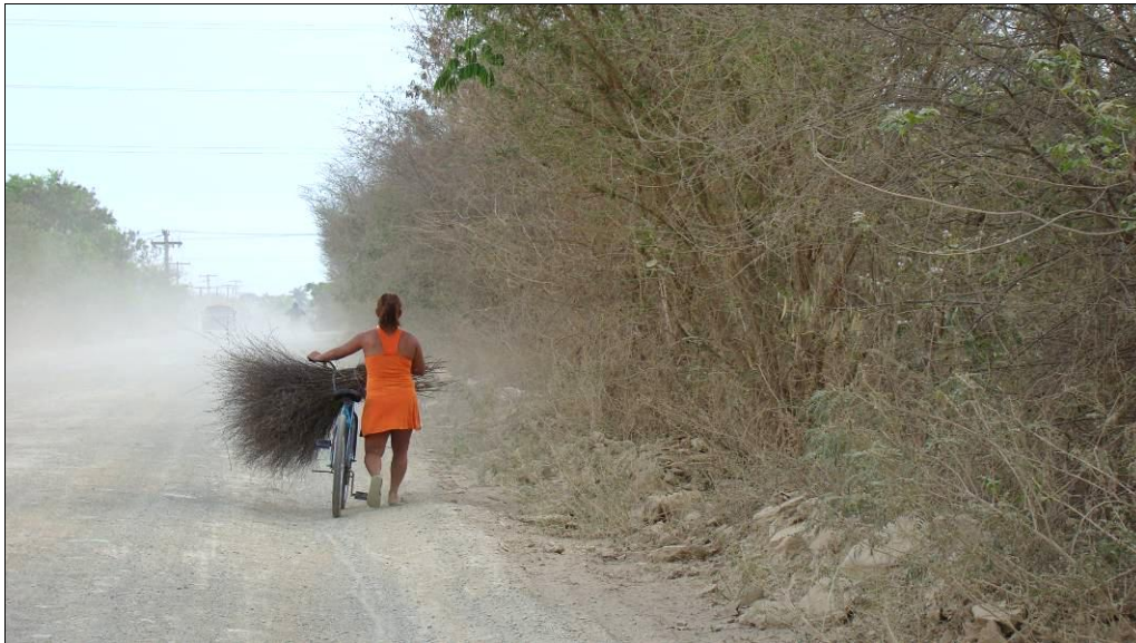
Figura 5.24: Material particulado em suspensão devido condição atual da BR-135 no trecho de estudo.
