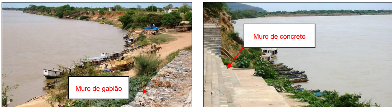
Figura 5.49: Muros de contenção de processos erosivos dos terraços aluviais do rio São Francisco. Município de Itacarambi. Ao fundo, terraços em processo ativo de erosão.
