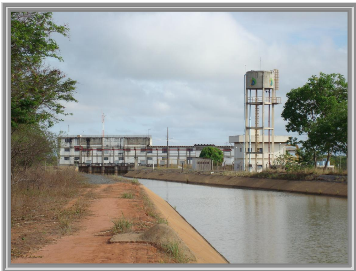
Estação de bombeamento do Projeto Jaíba, Município de Jaíba
