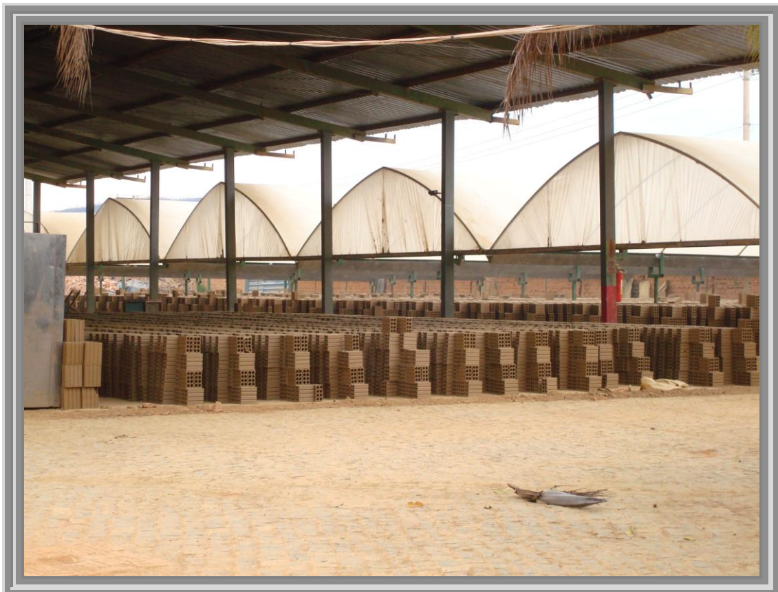
Itacarambi. Cerâmica, pilha de secagem de tijolos.
