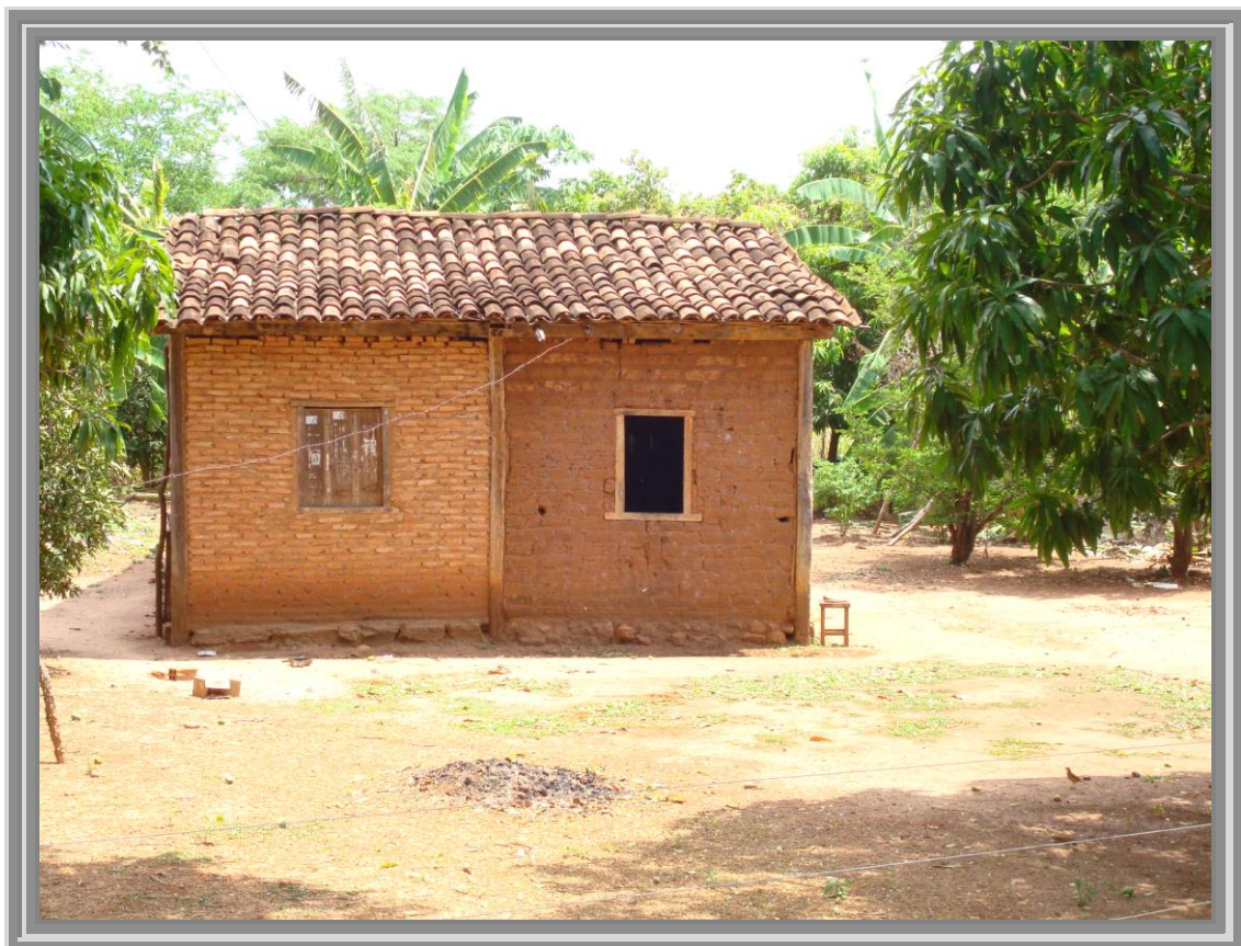
Itacarambi. Casa típica, nas margens da BR 135, saída sul, sentido Januária.
