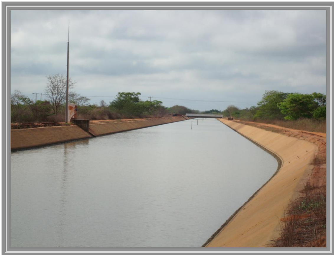
Município de Jaíba. Projeto Jaíba, canal de transposição de água para irrigação, margem direita do Rio São Francisco.
