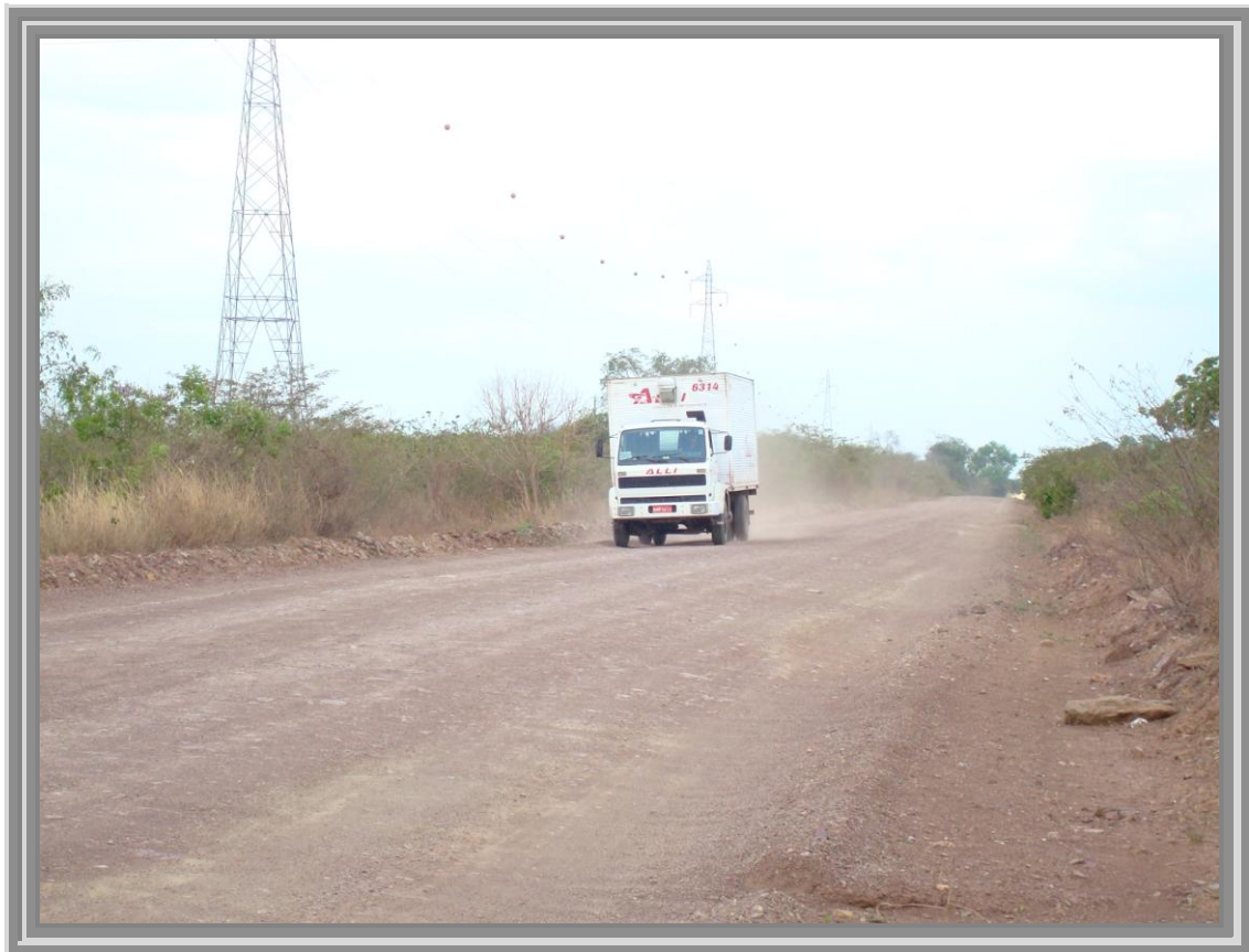
Manga. BR 135, pista força veículo de carga a transitar em velocidade muito baixa.
