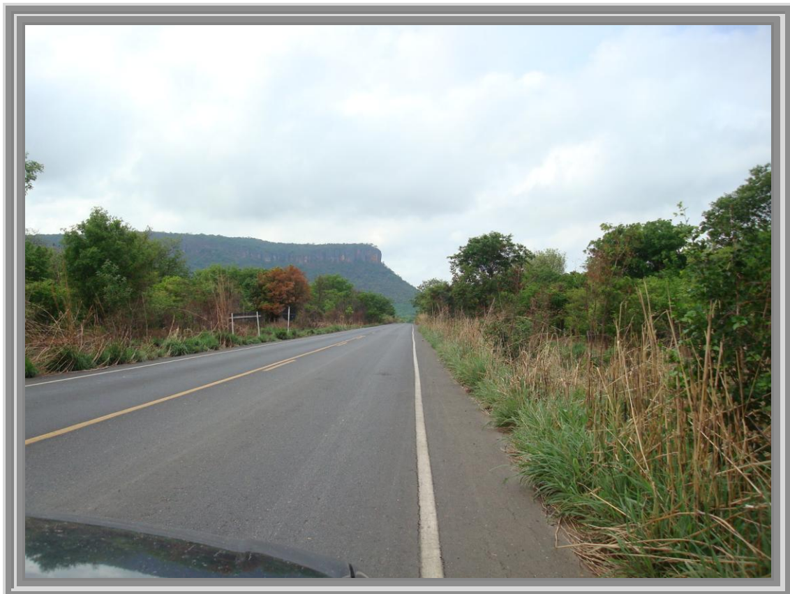
Jaíba – Janaúba. MG 401, asfalto e boa sinalização no município de Janaúba.
