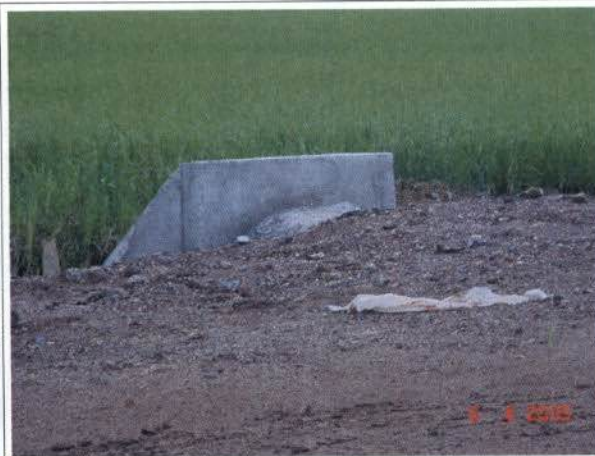
Figura 8.30 - Ilustração – Implantação de dispositivos de drenagem (bueiros)
