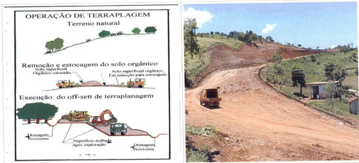
Figura 8.5 - Ilustração – acompanhamento da execução da terraplanagem e drenagem provisória
