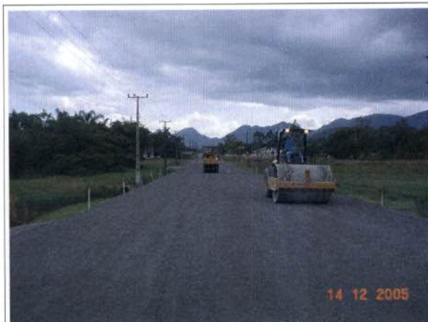
Figura 8.31 - Ilustração - Acompanhamento da execução da camada final de terraplanagem
