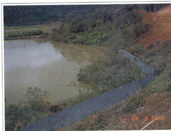
Figura 8.6 - Ilustração – Acompanhamento da colocação de dispositivos de controle de erosão (barreira de siltagem)
