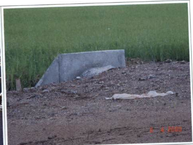
Figura 8.11 - Ilustração – Implantação de dispositivos de drenagem (bueiros)
