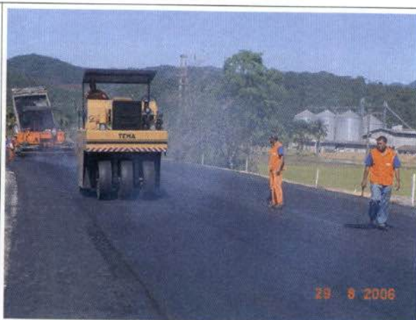
Figura 8.18 - Ilustração - Acompanhamento da execução da pavimentação
