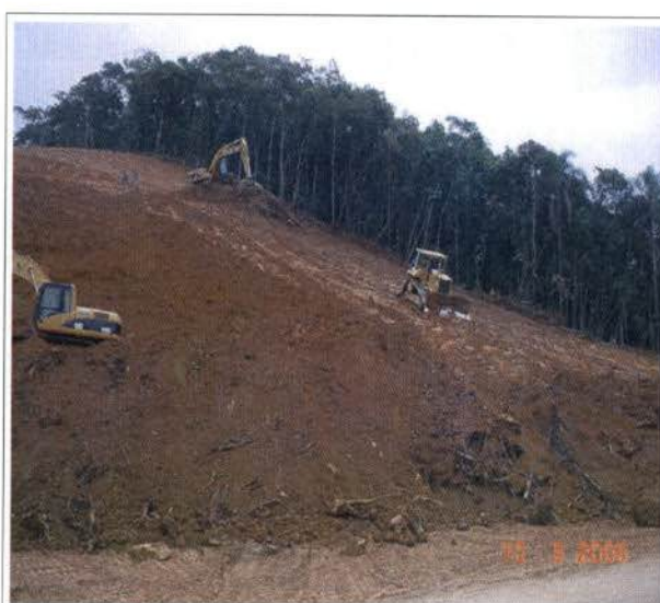
Figura 8.20 - Ilustração – Supressão da vegetação para execução de talude
