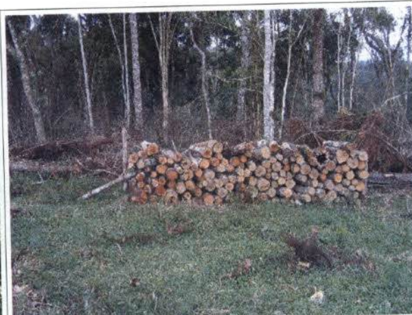
Figura 8.23 - Ilustração - Limpeza e empilhamento adequado da vegetação suprimida
