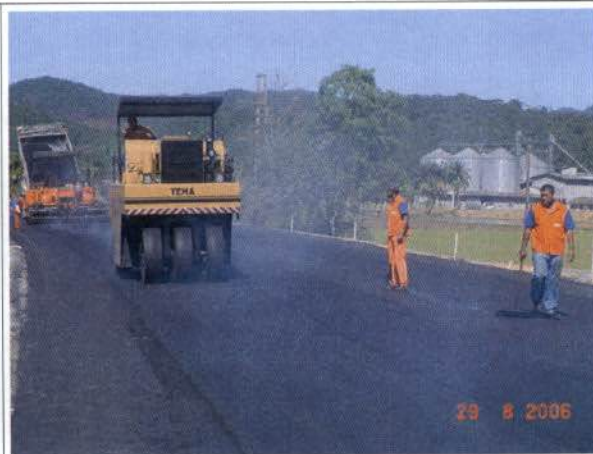
Figura 8.32 - Ilustração - Acompanhamento da execução da pavimentação
