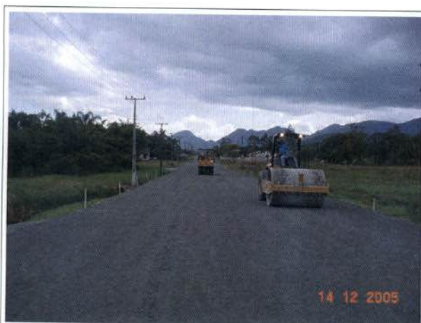
Figura 8.17 - Ilustração - Acompanhamento da execução da camada final de terraplanagem
