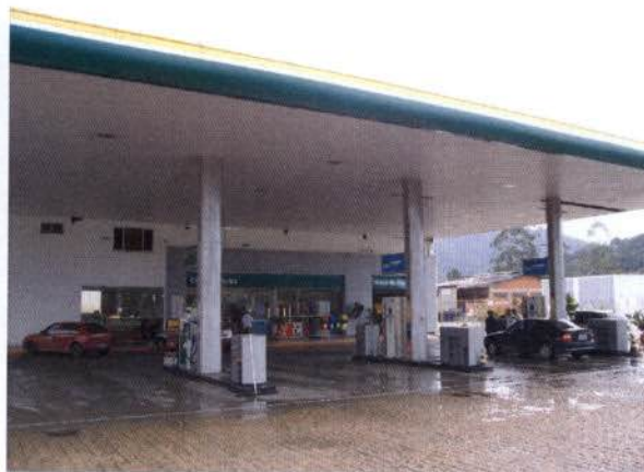
Figura 5.274 - Posto às margens da BR-470. Gaspar.
