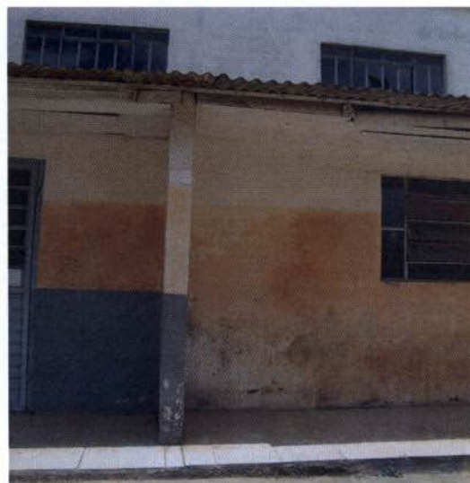
Figura 5.298 - Altura que alcançou nível da enchente em frente à Vila Germânica, em Blumenau (2008)
