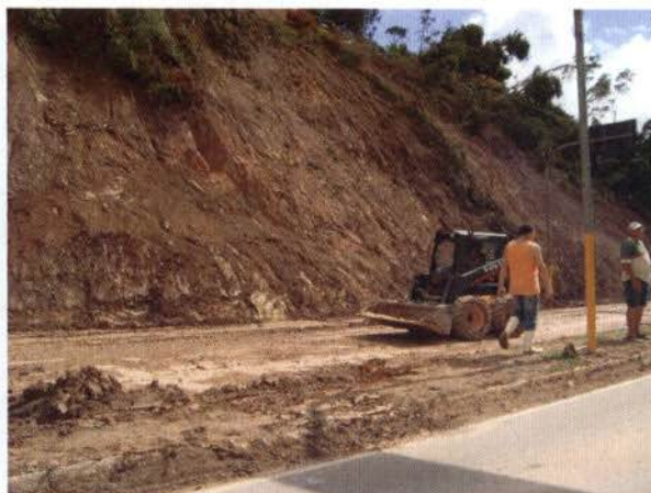
Figura 5.290 - Deslizando na pista (BR-470), em Ilhota (2008)
