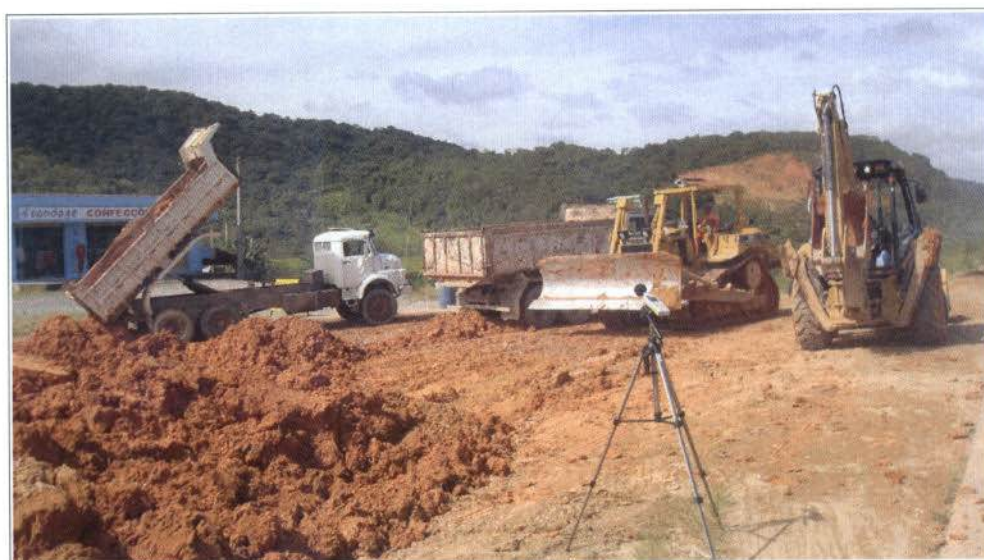
Figura 5.135 - Despejo e conformação do solo retirado do talude no ponto citado anteriormente.
