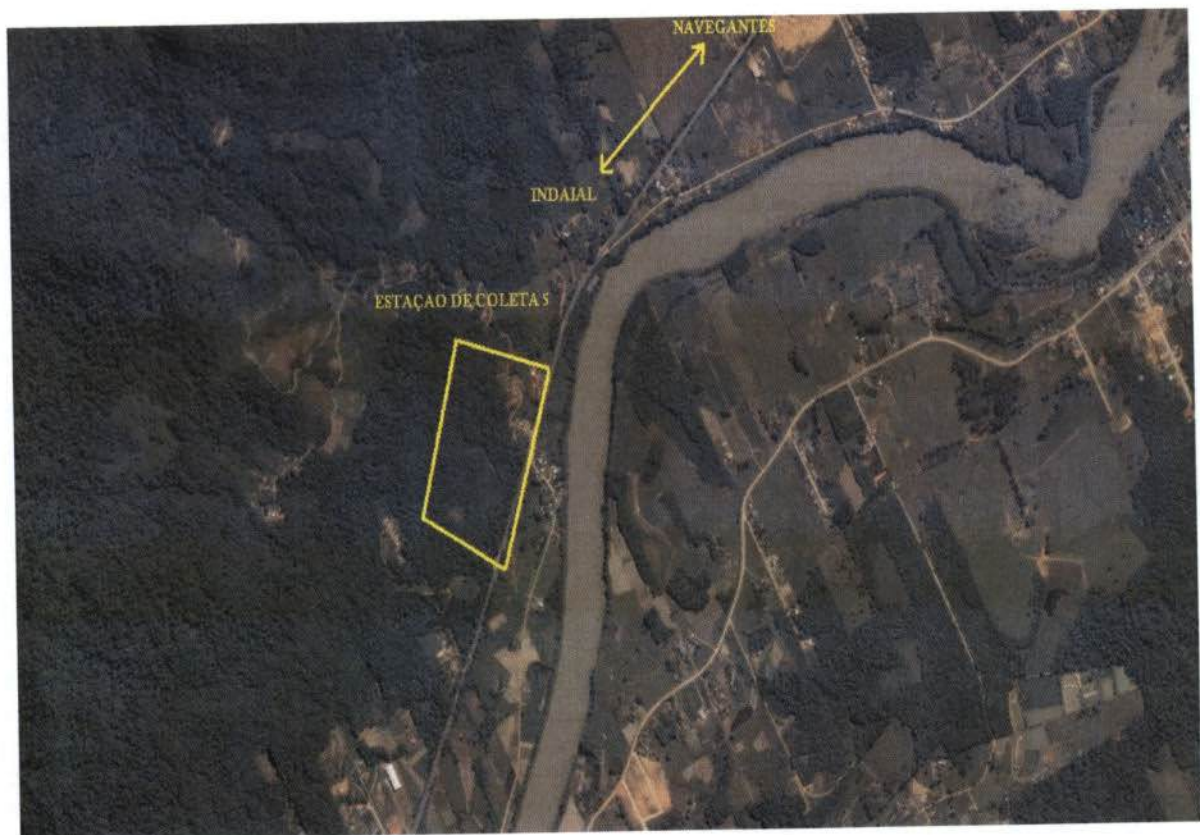
Figura 5.145 - Aspecto geral da Estação 05.
