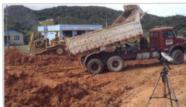
Figura 5.104 - Despejo e conformação do solo retirado do talude no ponto citado anteriormente.
