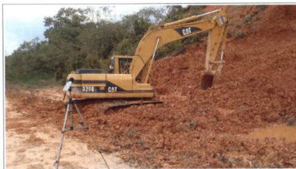
Figura 5.102 - Retirada de solo, por meio de escavadeira, de um talude localizado próximo ao km 35+000.
