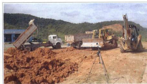
Figura 5.105 - Despejo e conformação do solo retirado do talude no ponto citado anteriormente.
