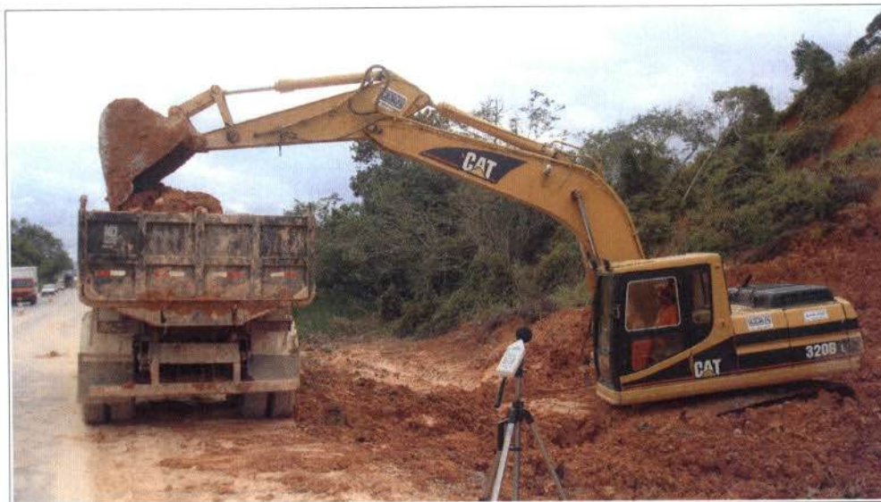
Figura 5.134 - Carregamento de caminhão basculante, por meio de escavadeira, com o material retirado do talude.
