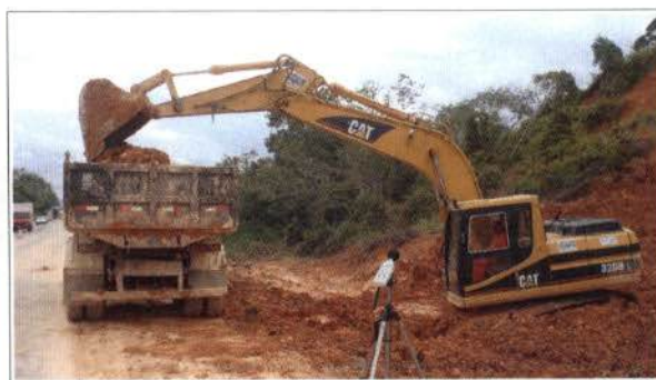
Figura 5.103 - Carregamento de caminhão basculante, com o material retirado do talude.
