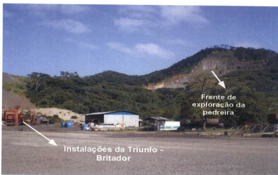
Figura 5.46 - Frente de exploração da pedra e suas instalações (Britador). Fonte: Autoria Prosul
