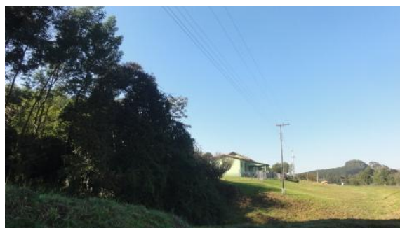
Presença de rede elétrica. 28/06/12.
