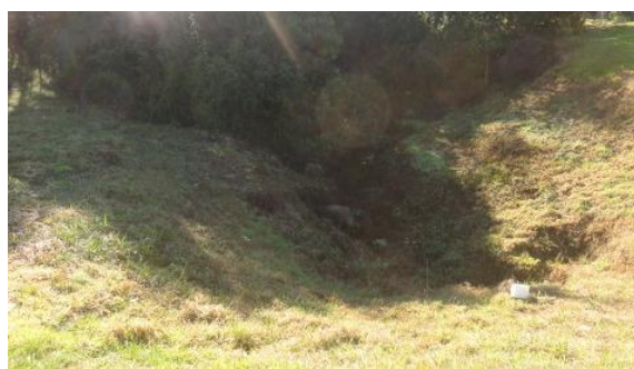
Arroio e bueiro. 28/06/12.
