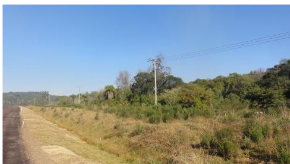
Vista do bota fora coberto por gramíneas; rede de energia elétrica no limite da faixa de domínio com propriedade e vegetação nativa. 28/06/12.
