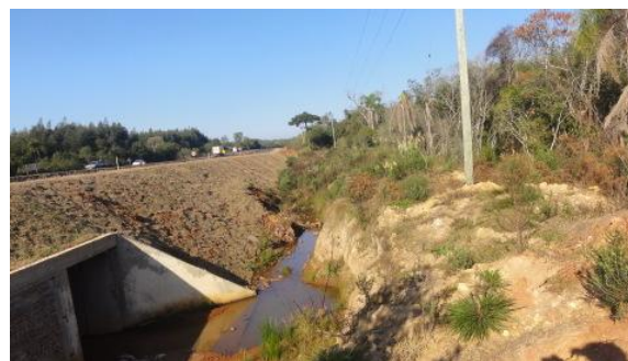
APP, bueiro celular de concreto a ser adaptado como passagem de fauna. 28/06/12.
