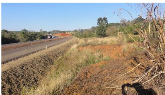
Estreitamento do bota fora, formando com a vala de drenagem um ambiente úmido. 28/06/12.
