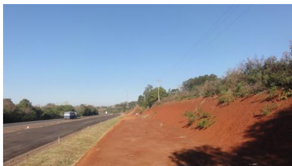
Vista da pista em construção, vala de drenagem, banqueteta e talude do corte. 28/06/12.
