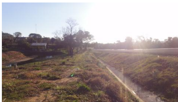
Área de bota fora entre o limite da faixa de domínio e canaleta de drenagem. 21/06/12.
