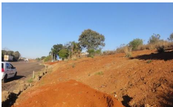
Vista geral da área, sentido Estrela – Fazenda V. Nova. 28/06/12.
