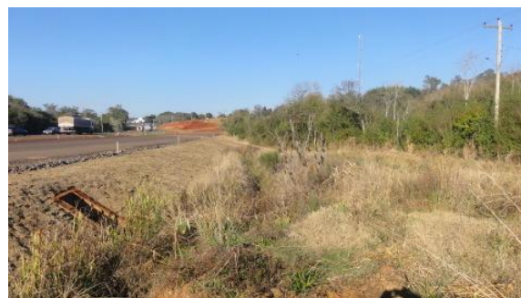
Final do bota fora, bueiro e estrada local. 28/06/12.
