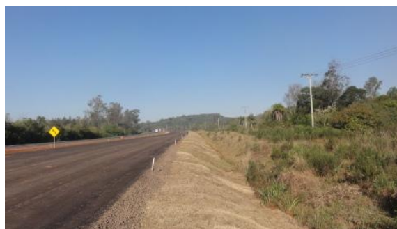
Pista em construção, vala de drenagem e bota fora. 28/06/12.
