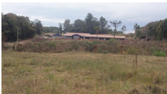
APP do arroio, ao fundo creche municipal em construção. 18/06/12.
