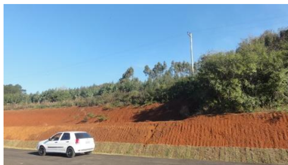
Fragmento de nativas na extremidade, sentido Estrela. Proximidade de rede elétrica. 28/06/12.
