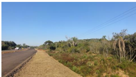
Bota fora, vista do trecho após o bueiro, sentido Fazenda Vila Nova. 28/06/12/.
