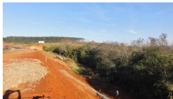
Extensão da área com cordão de nativas junto a cerca (limite da faixa de domínio). 28/6/12.
