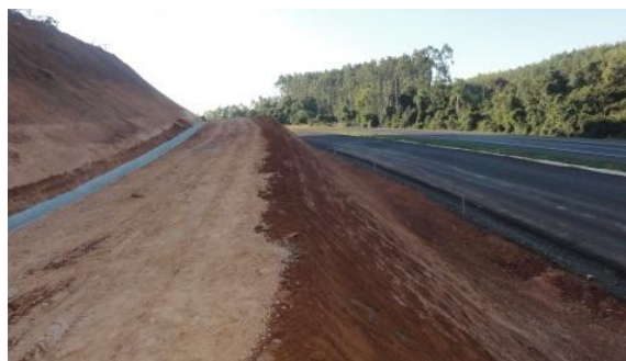
Bancada com canaleta de drenagem e taludes. 28/06/12.
