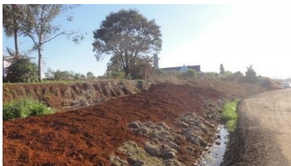
Área a ser conformada na faixa de domínio, vala de drenagem e baia para PO. 28/06/12.
