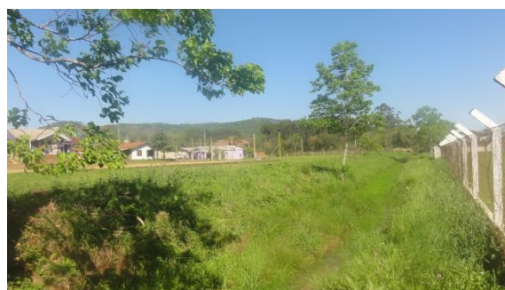
Drenagem próxima a cerca do campo de futebol mantendo o terreno úmido. 30/8/12.
