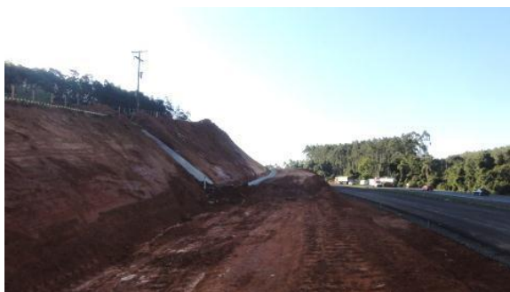
Vista da bancada e taludes. 28/06/12.
