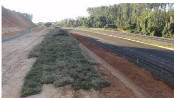
Enleivamento da borda da bancada. 28/06/12.
