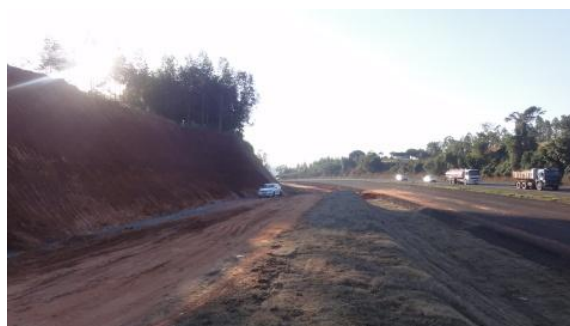
Final da bancada, sentido Fazenda Vila nova. 28/06/12.
