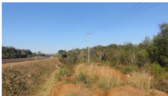
Bota fora próximo a APP; rede elétrica e fragmento de nativas. 28/06/12.
