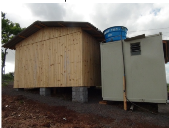
Escola provisória – detalhe do reservatório de água
