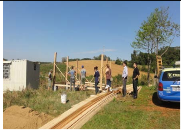
Equipe do DNIT e IBAMA inspecionam obras
