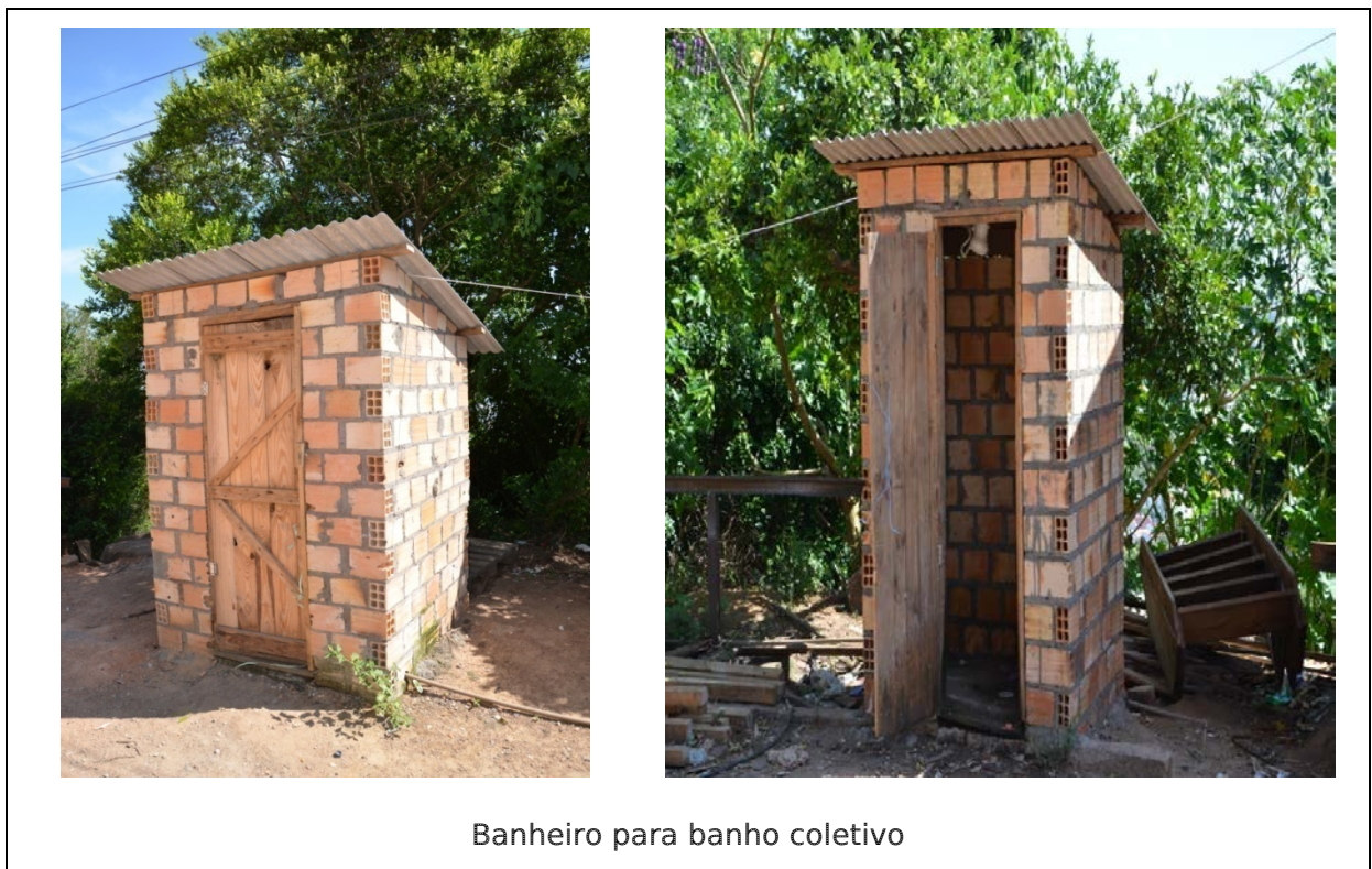
Figura 4 – Banheiros para banhos
