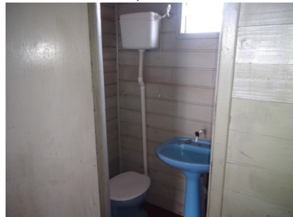
Escola provisória – detalhe dos sanitários.
