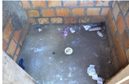
Vista interna do banheiro
