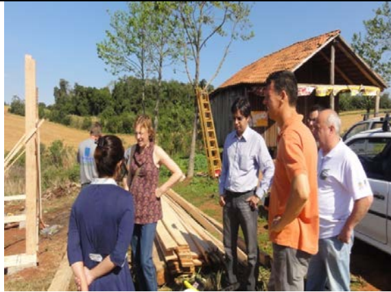
Equipe do DNIT e IBAMA inspecionam obras
