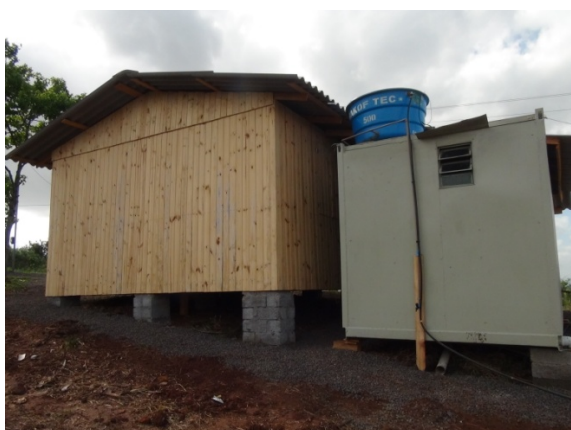
Escola provisória – detalhe do reservatório de água
