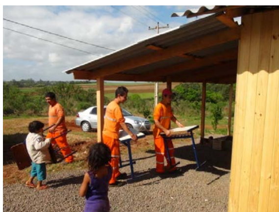
Trabalhadores executando a mudança para escola provisória.
