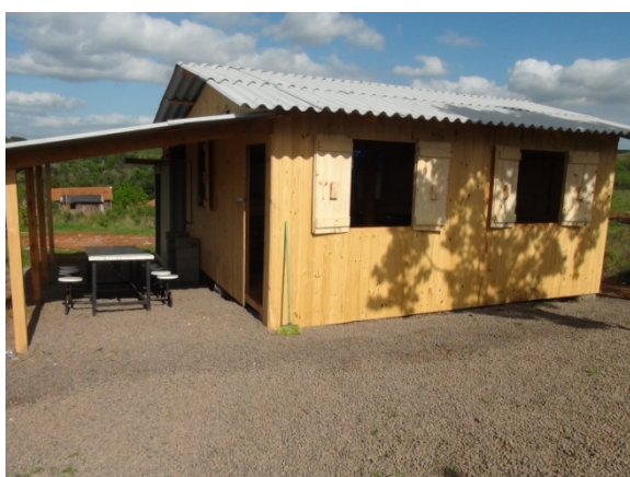
Escola provisória e pátio em condições de receber alunos.
