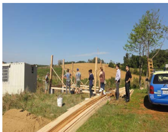
Equipe do DNIT e IBAMA inspecionam obras
