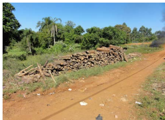
Acesso interno da Aldeia com lenha resultante da supressão de vegetação para as obras.
