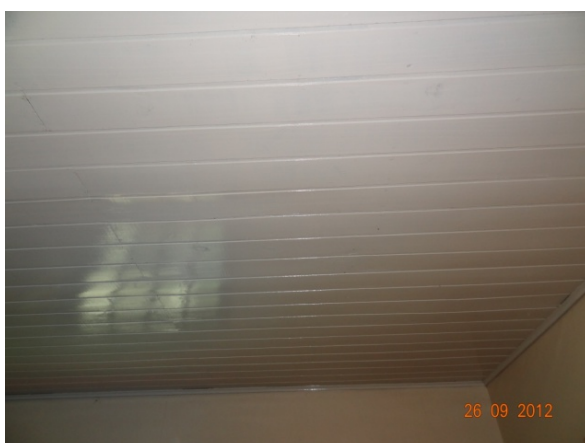
Forro PVC (26/09/2012, 11:23h)
