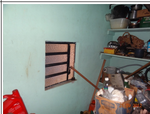
Detalhe – Janela Garagem (25/09/2012, 09:42h)
