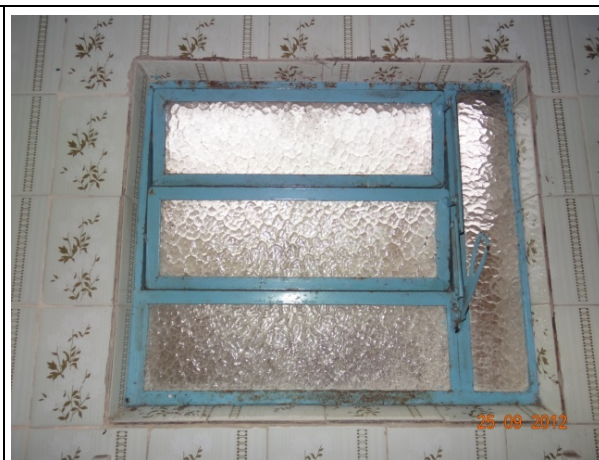
Detalhe – Janela banheiro (25/09/2012, 09:58h)
