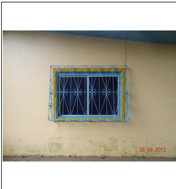
Detalhe – Janela (25/09/2012, 09:50h)
