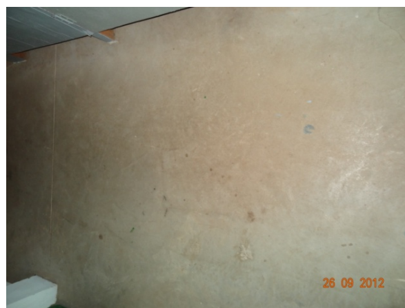
Piso em Concreto (26/09/2012, 15:39h)
