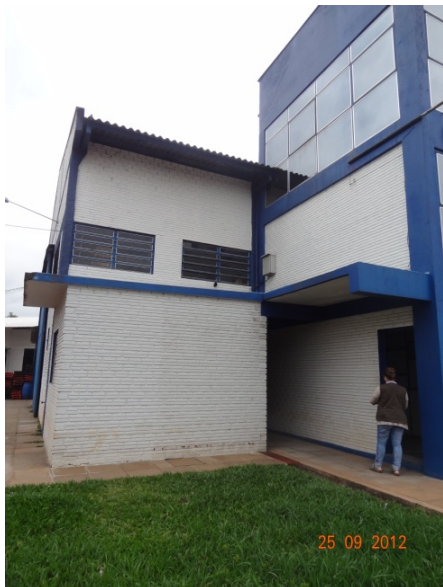
Fachada - lateral (25/09/2012, 11:22h)
