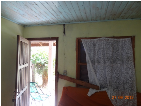
Vista interna porta entrada (27/09/2012, 14:38h)
