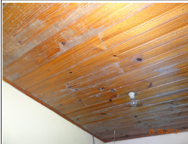
Detalhe – Forro Quarto (25/09/2012, 09:36h)
