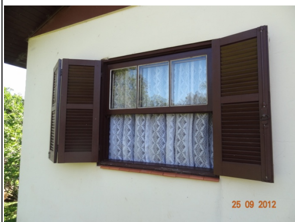
Detalhe – janela (25/09/2012, 14:26h)
