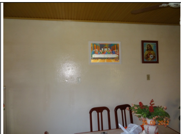
Detalhe – Parede interna (25/09/2012, 09:27h)
