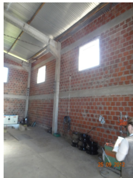
Estrutura em concreto – galpão 2 (25/09/2012, 14:54h)
