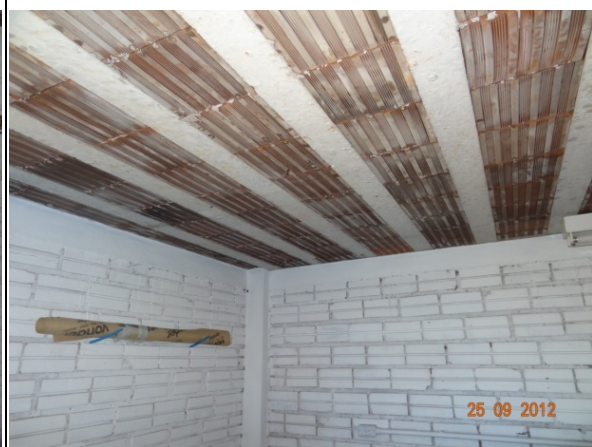
Laje – escritório (25/09/2012, 14:52h)
