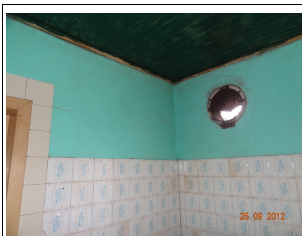
Parede Cozinha (25/09/2012, 09:54h)
