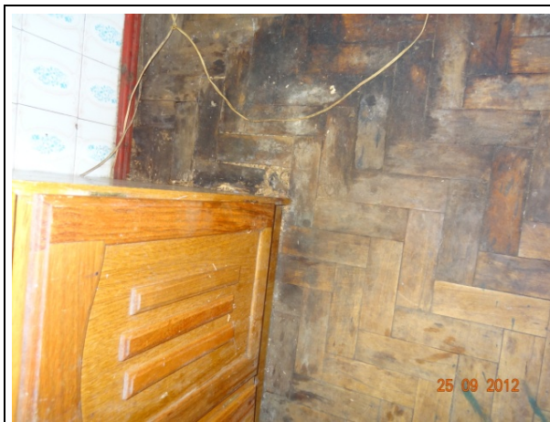
Piso – Taco de madeira - Quarto (25/09/2012, 09:56h)
