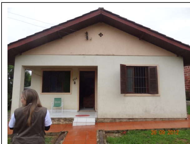
Detalhe – Fachada (26/09/2012, 10:33h)
