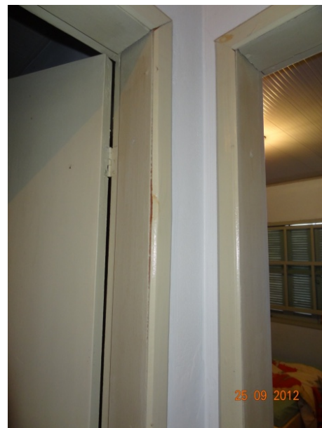
Detalhe – Porta Quarto (25/09/2012, 10:35h)
