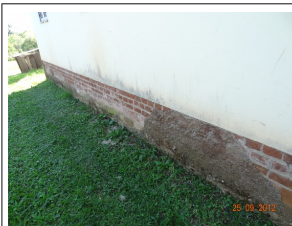
Fachada lateral – sem reboco (25/09/2012, 14:32h)
