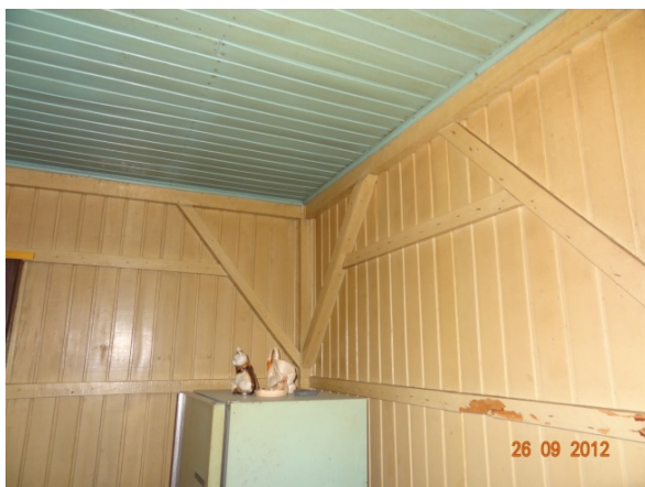
Paredes e forro em madeira – casa em anexo (26/09/2012, 11:30h)
