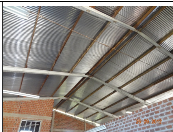
Cobertura - galpão (25/09/2012, 14:48h)
