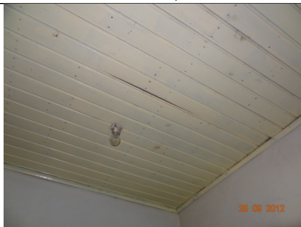
Detalhe – Forro Quarto (25/09/2012, 09:28h)
