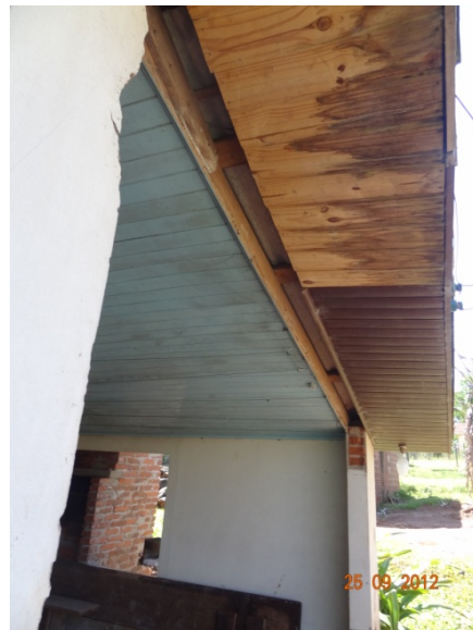
Forro em madeira (25/09/2012, 14:27h)
