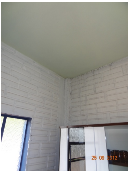
Parede sem reboco - cozinha (25/09/2012, 11:23h)
