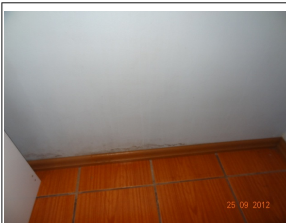
Detalhe – Piso quarto (25/09/2012, 10:38h)
