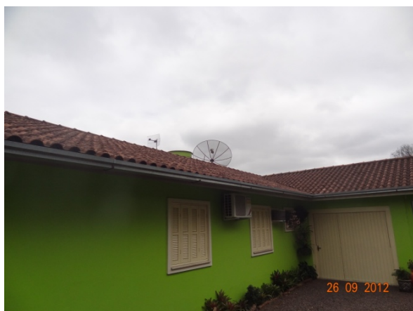
Detalhe – Telhado (26/09/2012, 10:51h)
