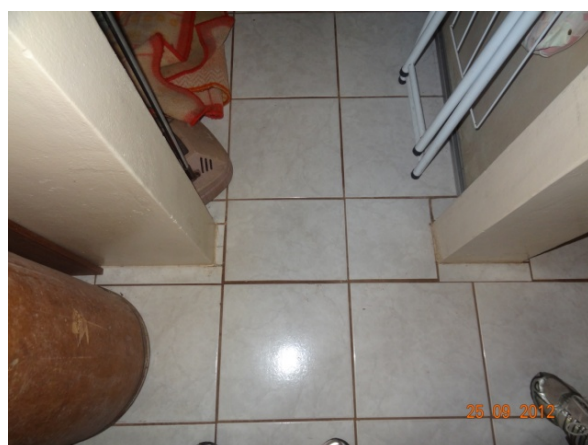
Detalhe – Piso Banheiro (25/09/2012, 09:29h)
