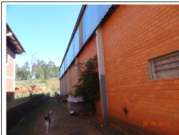
Fachada - Lateral (25/09/2012, 15:12h)
