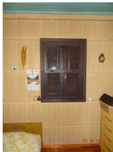
Detalhe – Janela quarto (26/09/2012, 11:31h)
