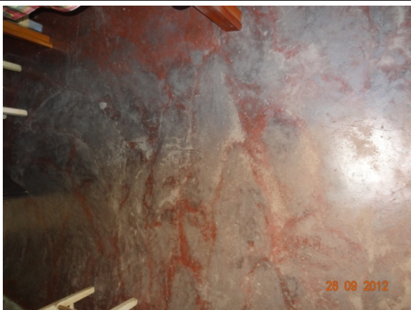
Detalhe – piso em concreto (26/09/2012, 11:29h)
