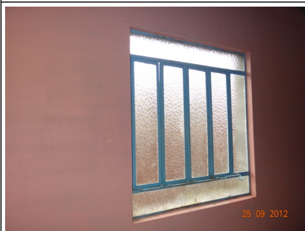
Detalhe – Janela (25/09/2012, 09:58h)
