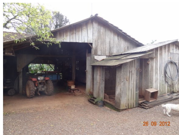
Fachada – Galpão (26/09/2012, 10:59h)
