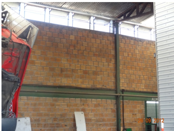
Parede interna sem reboco (26/09/2012, 15:45h)
