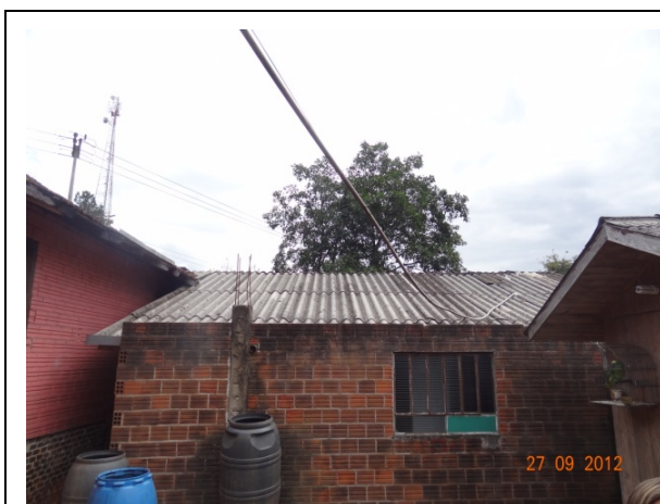
Telhado – casa anexo (27/09/2012, 14:33h)
