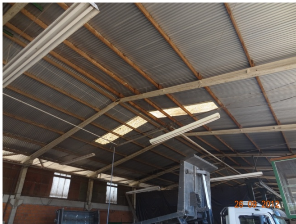
Estrutura em concreto (26/09/2012, 15:46h)
