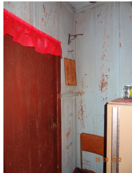
Detalhe – Parede cozinha (25/09/2012, 10:49h)
