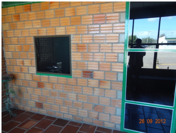
Parede interna - recepção (26/09/2012, 15:26h)
