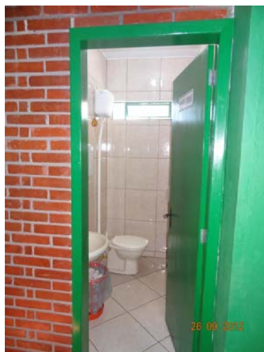
Banheiro – escritório (26/09/2012, 15:29h)
