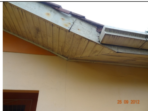
Detalhe – forro telhado (25/09/2012, 09:21h)
