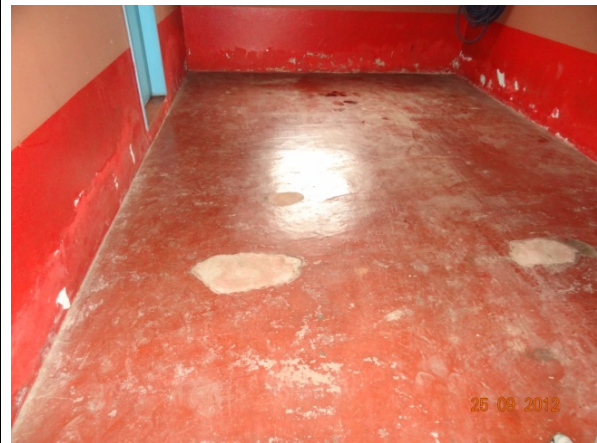
Piso em concreto - garagem (25/09/2012, 10:04h)
