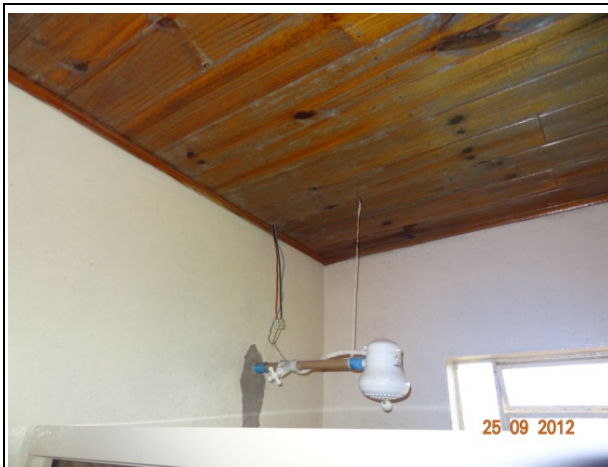
Detalhe – Banheiro (25/09/2012, 09:34h)
