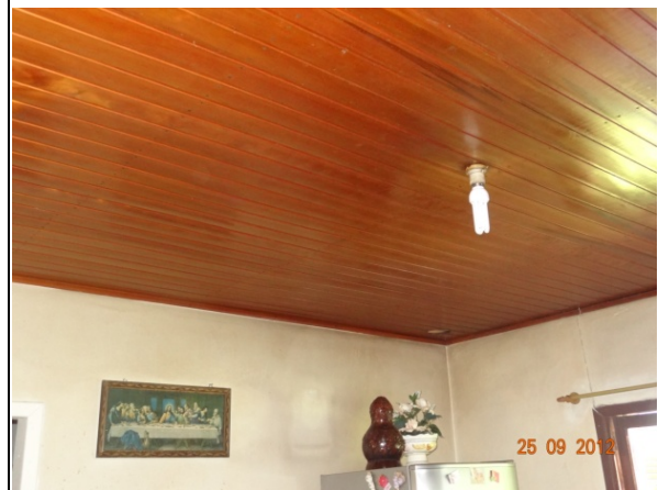
Forro madeira – cozinha (25/09/2012, 14:35h)
