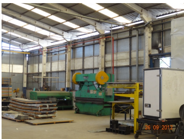
Revestimento interno – sem reboco (26/09/2012, 16:10h)
