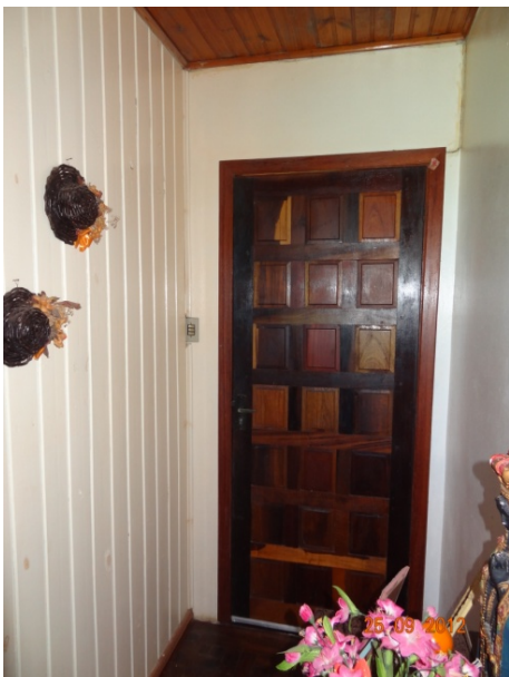
Vista – porta entrada (25/09/2012, 09:33h)
