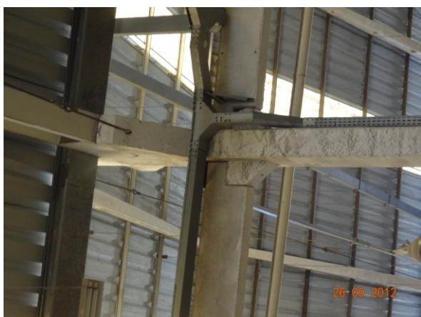
Detalhe da Estrutura - (26/09/2012, 16:12h)
