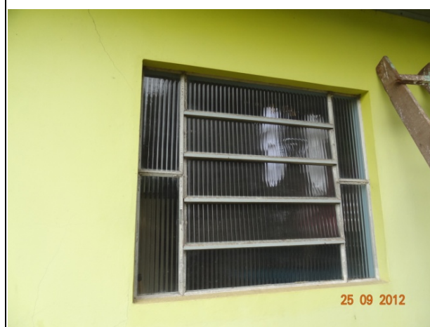
Detalhe – Janela Banheiro (25/09/2012, 10:43h)
