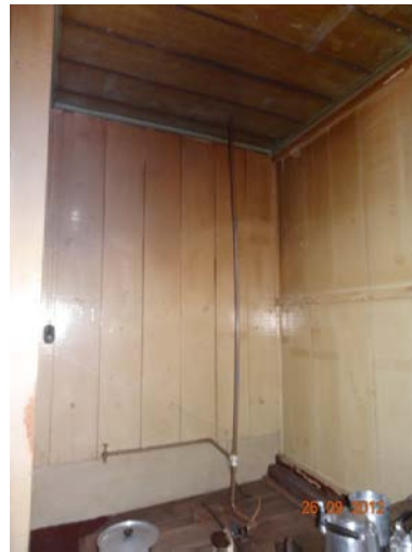
Banheiro – casa em anexo (26/09/2012, 11:29h)
