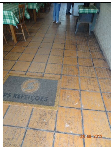
Detalhe – piso refeitório (25/09/2012, 11:38h)
