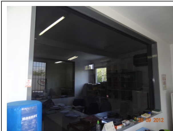
Janela sala – fachada esquerda ((26/09/2012, 15:48h)
