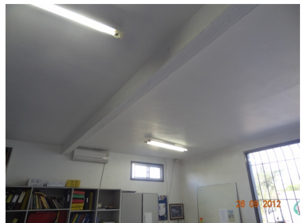
Laje em concreto - (26/09/2012, 15:48h)
