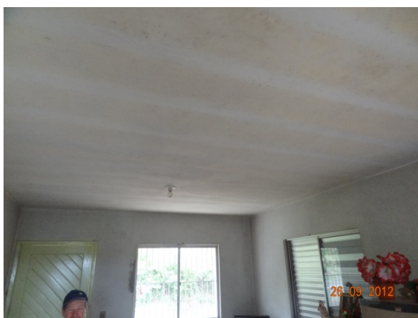
Laje em concreto (26/09/2012, 11:07h)
