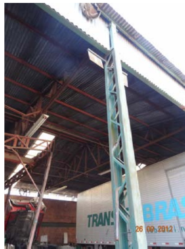
Estrutura Metálica – Galpão (26/09/2012, 15:44h)
