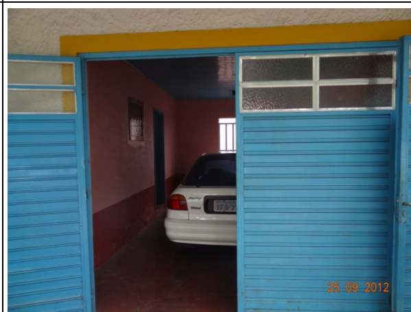
Detalhe – Portão Garagem (25/09/2012, 09:59h)
