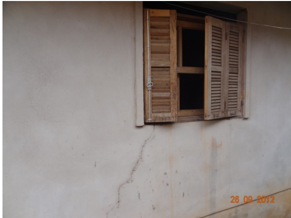
Construção - Fundos (26/09/2012, 10:36h)
