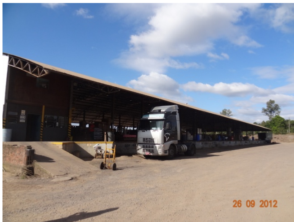
Fachada Galpão 3 (26/09/2012, 15:48h)
