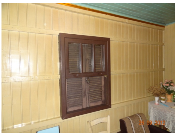
Detalhe – janela sala (26/09/2012, 11:32h)
