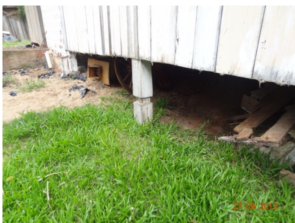
Detalhe – Pilar da casa (27/09/2012, 14:48h)
