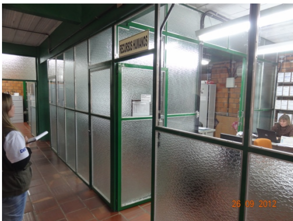
Divisórias em vidro (26/09/2012, 15:29h)
