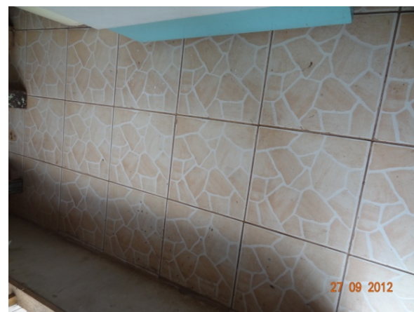
Piso cerâmica (27/09/2012, 14:36h)
