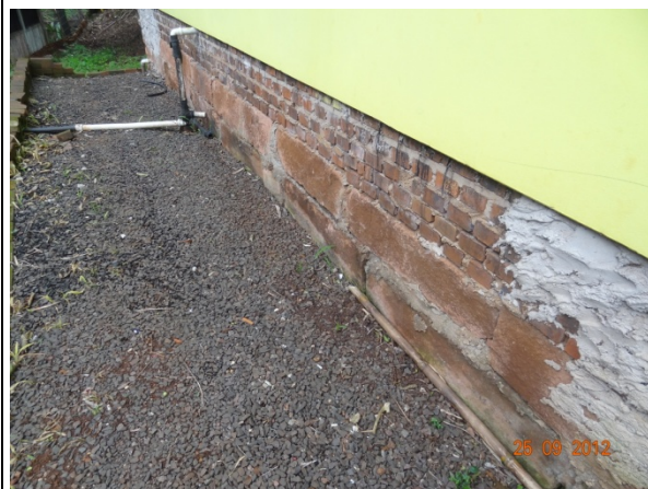
Detalhe – Parede Lateral (25/09/2012, 10:42h)
