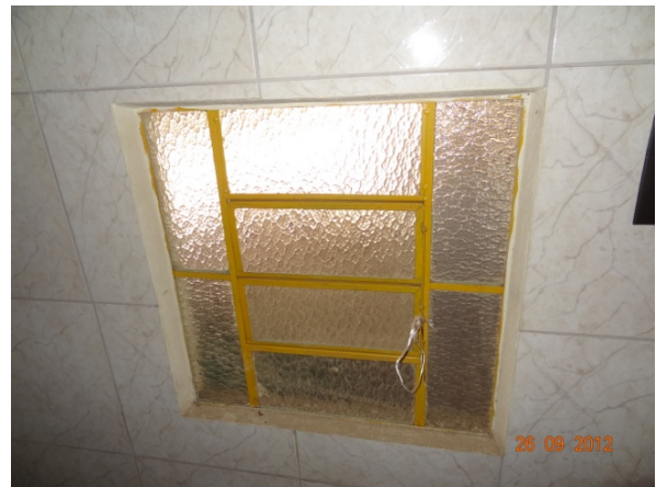
Cerâmica banheiro (26/09/2012, 15:49h)
