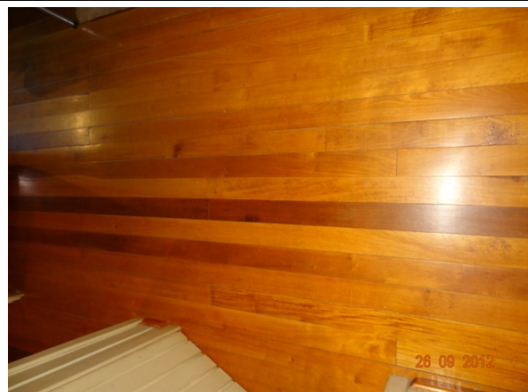
Detalhe – Piso em madeira nos quartos (26/09/2012, 11:30h)
