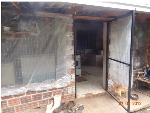
Fachada – fundos (27/09/2012, 14:32h)
