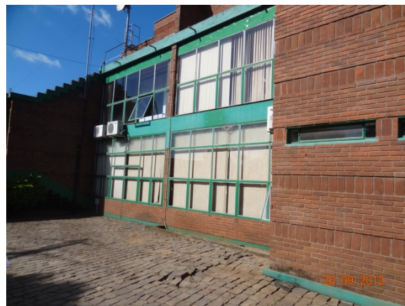
Fachada Lateral (26/09/2012, 15:33h)
