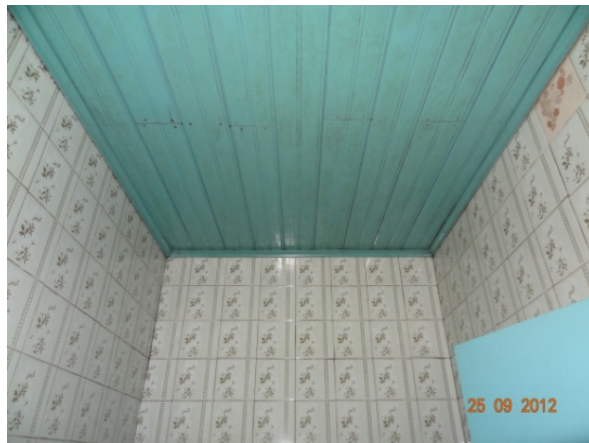
Detalhe – Forro Banheiro (25/09/2012, 10:03h)
