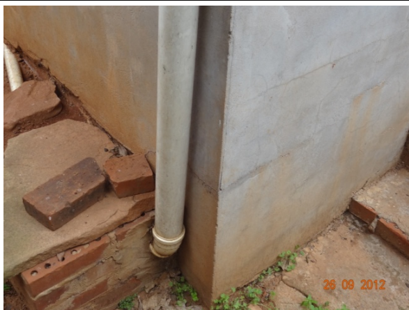
Detalhe – calçada fundos (26/09/2012, 10:37h)
