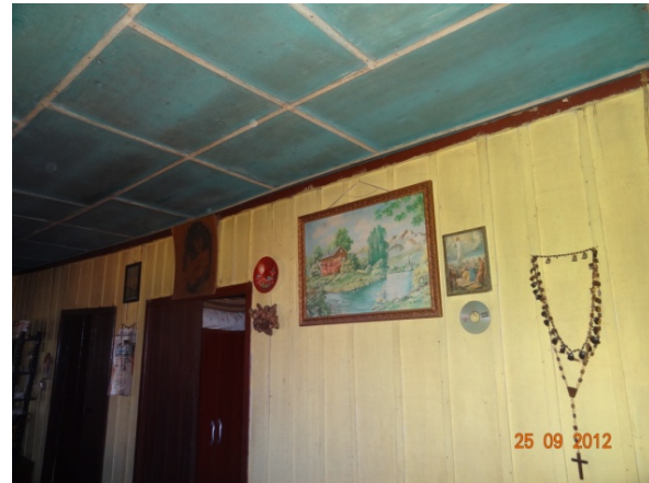
Paredes internas em madeira (25/09/2012, 15:37h)
