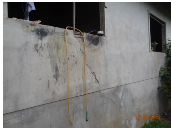
Detalhe – Construção Lateral (26/09/2012, 10:37h)
