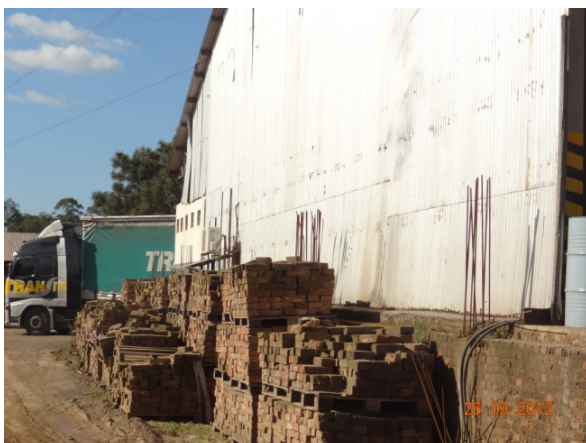
Fachada Lateral – Galpão 3 (26/09/2012, 15:50h)
