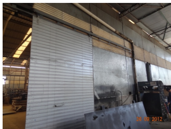
Detalhe entrada lateral (26/09/2012, 16:14h)
