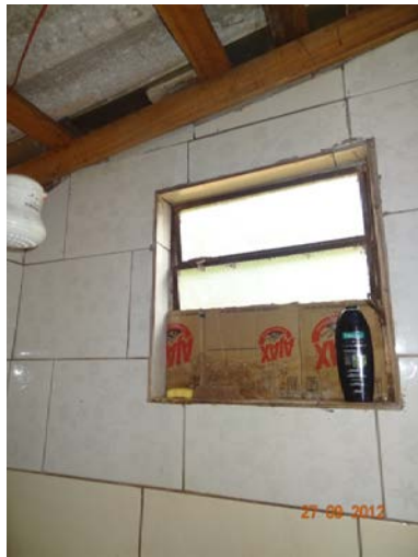
Detalhe – Janela Banheiro (27/09/2012, 14:38h)
