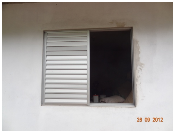
Detalhe – Janela (26/09/2012, 11:05h)
