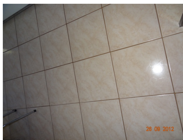
Detalhe – Piso banheiro (26/09/2012, 10:53h)
