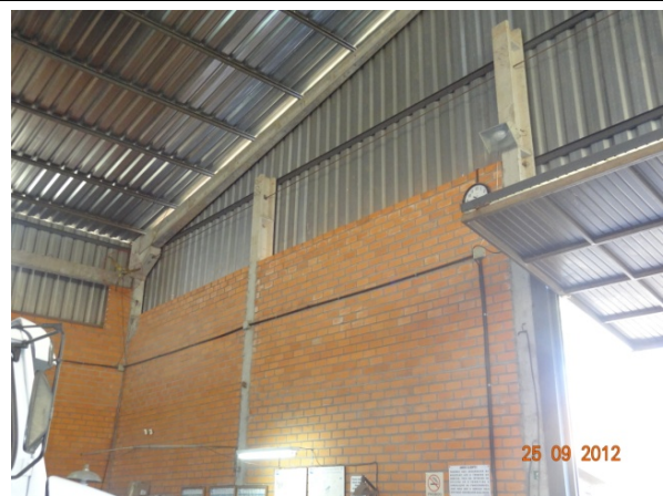
Detalhe – vigas em concreto (25/09/2012, 15:14h)
