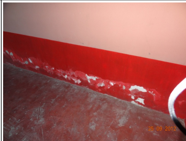
Parede Garagem (25/09/2012, 09:59h)
