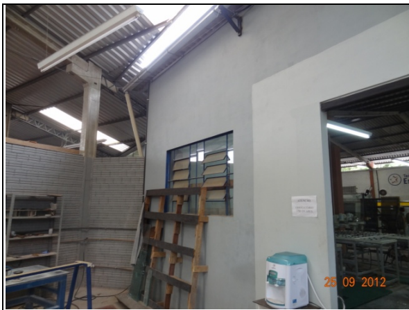
Fachada – Galpão 3 (25/09/2012, 11:36h)
