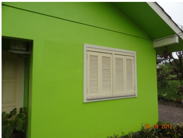
Detalhe – Janela (26/09/2012, 10:50h)
