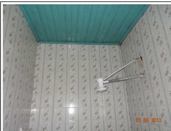
Cerâmica - Banheiro (25/09/2012, 09:58h)
