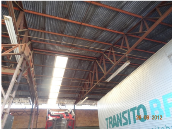
Telhado Galpão (26/09/2012, 15:44h)
