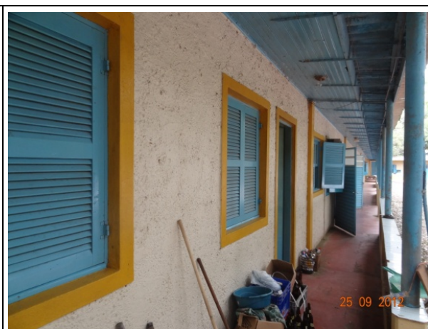
Vista Lateral – Fachada (25/09/2012, 09:52h)
