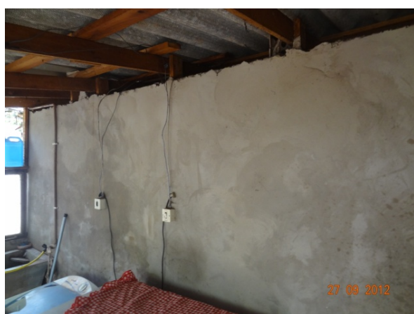
Parede interna área de serviço (27/09/2012, 14:37h)
