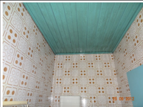
Detalhe – cerâmica banheiro (25/09/2012, 10:04h)
