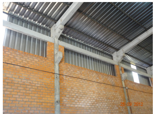
Estrutura em concreto (25/09/2012, 15:13h)
