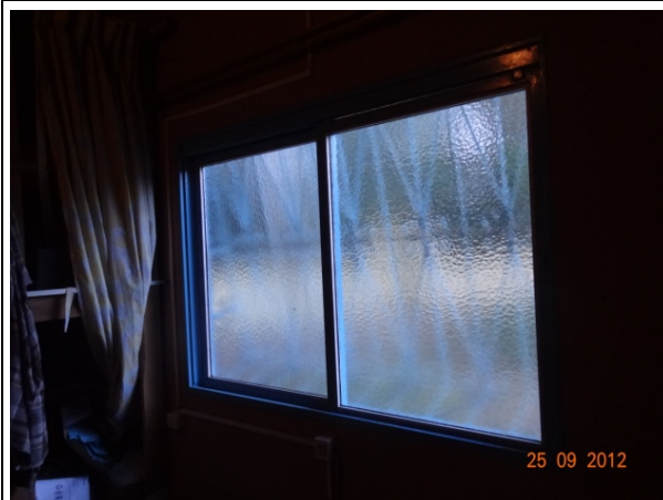
Detalhe – Janela (25/09/2012, 09:57h)
