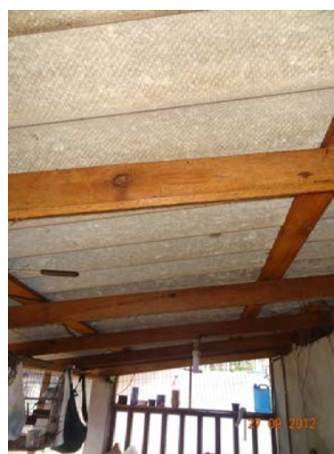
Telhado – sem forro (27/09/2012, 14:37h)
