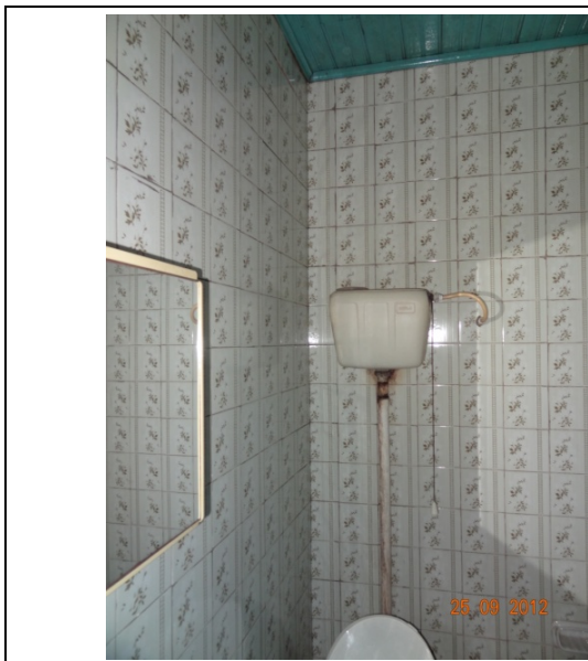
Detalhe – Banheiro (25/09/2012, 10:02h)
