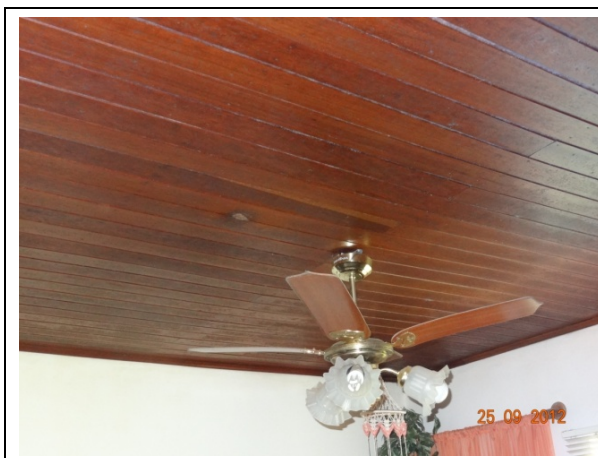
Detalhe – Forro sala (25/09/2012, 09:30h)
