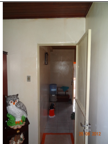
Detalhe – Porta Interna (25/09/2012, 09:30h)
