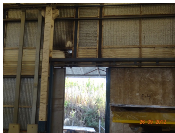
Revestimento interno – sem reboco (26/09/2012, 16:10h)
