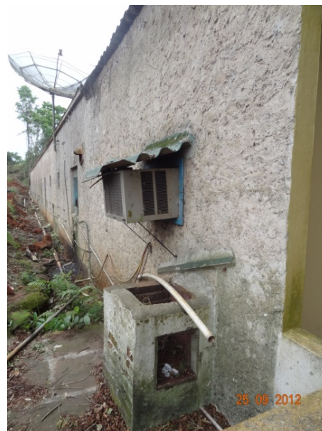
Fachada – fundos (25/09/2012, 09:50h)
