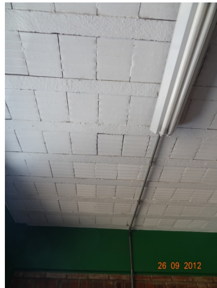
Laje – sem reboco (26/09/2012, 15:27h)
