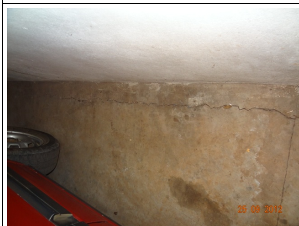
Piso em concreto - garagem (25/09/2012, 09:41h)
