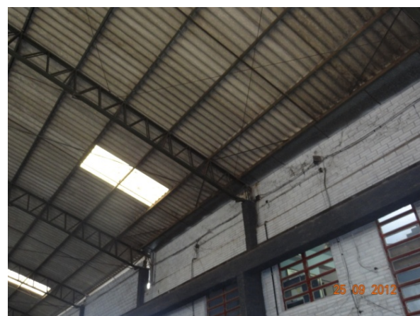
Estrutura em aço (25/09/2012, 11:26h)
