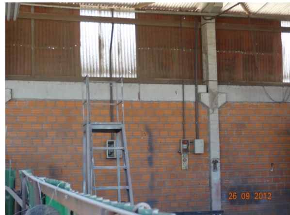
Parede em alvenaria e acrílico (26/09/2012, 15:47h)
