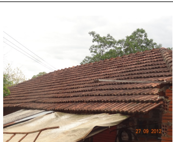
Detalhe – telhado (27/09/2012, 14:32h)
