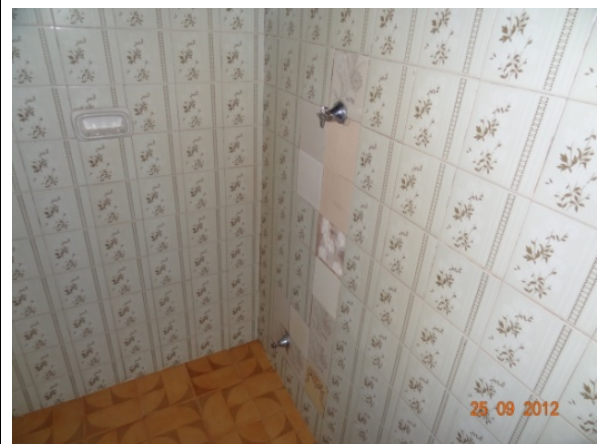
Cerâmica banheiro (25/09/2012, 10:03h)
