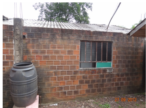
Fachada fundos – casa anexo (27/09/2012, 14:33h)
