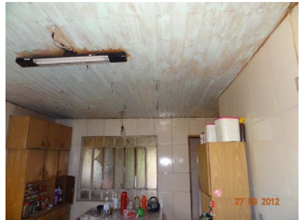
Vista interna cozinha (27/09/2012, 14:38h)
