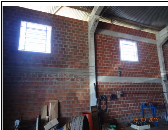
Paredes internas – galpão 1 (25/09/2012, 14:48h)
