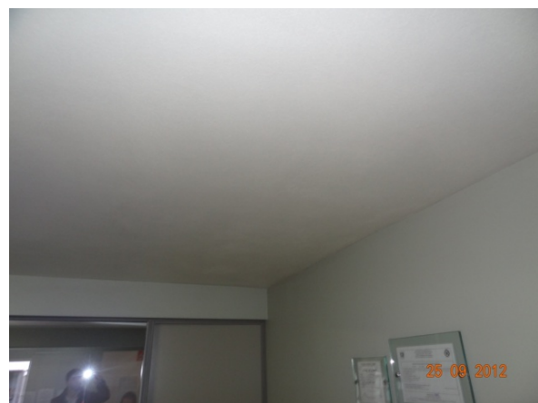
Laje – escritório 3 (25/09/2012, 11:28h)
