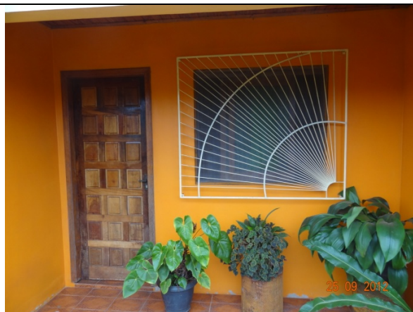
Fachada - entrada (25/09/2012, 09:20h)
