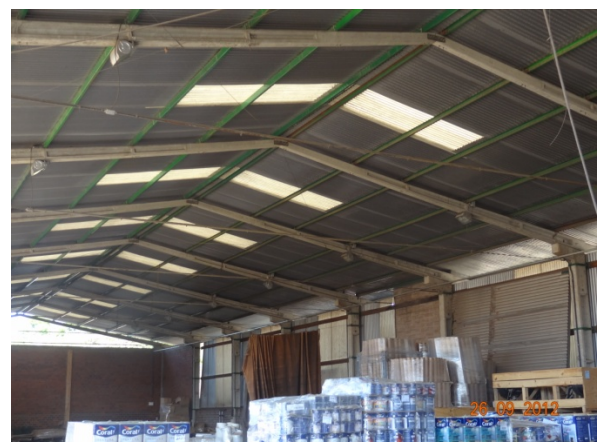
Telhado – Galpão 2 (26/09/2012, 15:46h)
