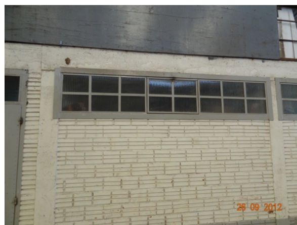
Parede interna – sem reboco (26/09/2012, 16:15h)
