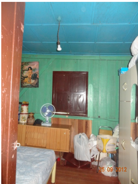
Detalhe - Quarto (25/09/2012, 15:37h)
