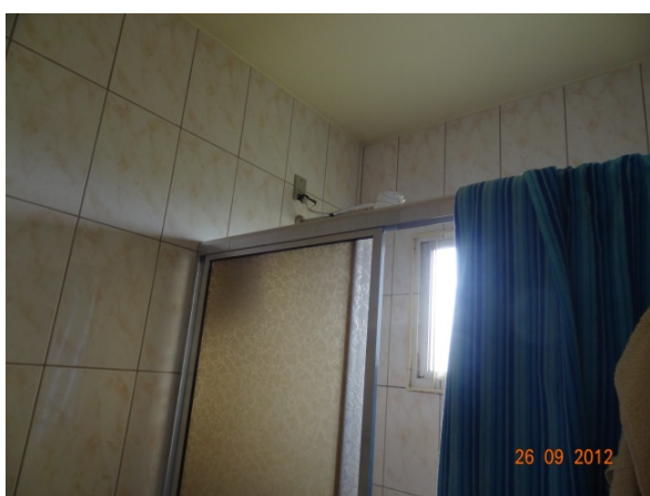
Box Banheiro (26/09/2012, 10:53h)
