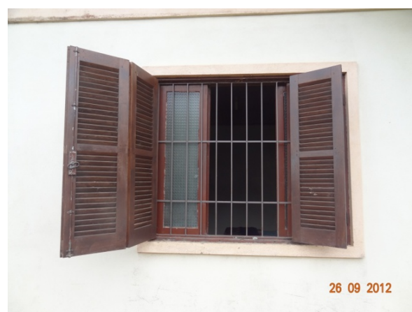
Janela - Fachada (26/09/2012, 10:33h)
