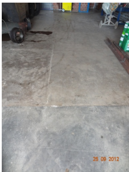
Piso em concreto – galpão 1 (25/09/2012, 14:49h)
