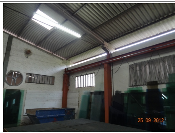
Estrutura em concreto (25/09/2012, 11:37h)
