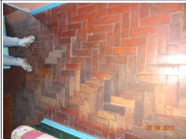
Piso – taco de madeira (25/09/2012, 10:03h)
