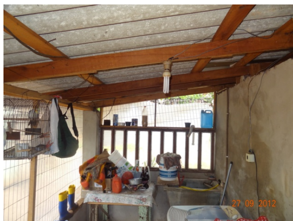
Área de serviço (27/09/2012, 14:36h)
