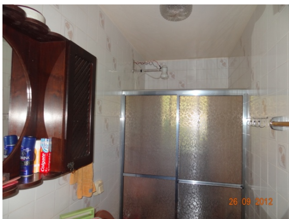
Laje do Banheiro (26/09/2012, 10:54h)
