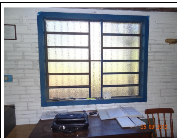
Janela – Escritório (25/09/2012, 14:51h)
