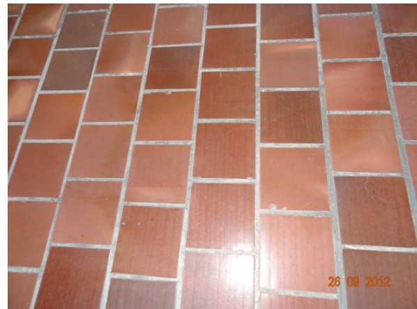
Piso – cerâmica (26/09/2012, 15:27h)
