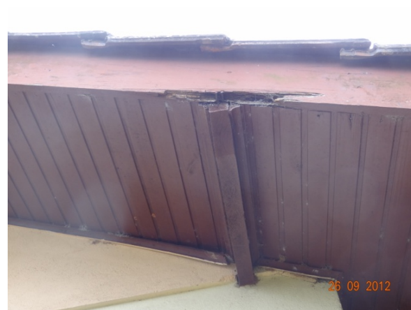
Detalhe – Forro Telhado (26/09/2012, 10:34h)
