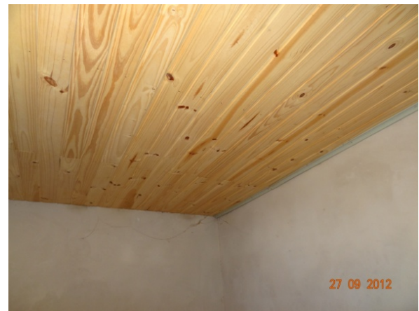
Forro em madeira (27/09/2012, 14:39h)
