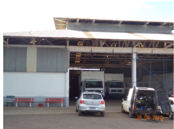
Detalhe – porta garagem (26/09/2012, 16:18h)
