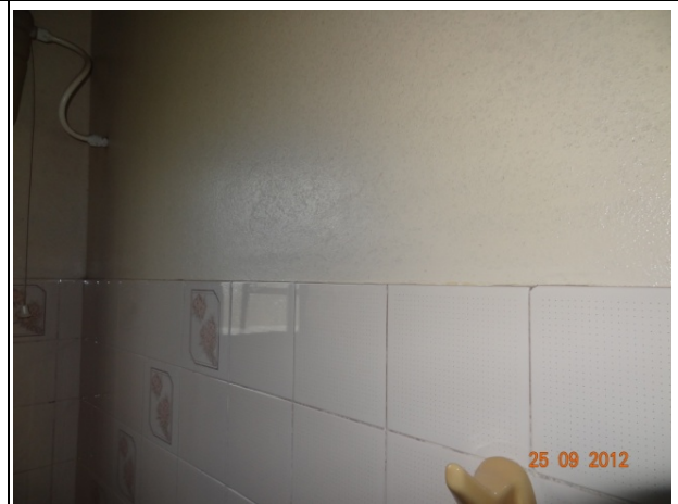
Cerâmica Banheiro (25/09/2012, 09:36h)
