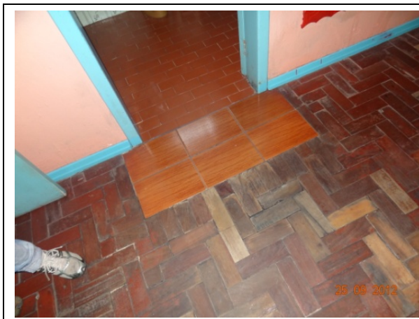
Detalhe – Piso Quarto (25/09/2012, 10:03h)
