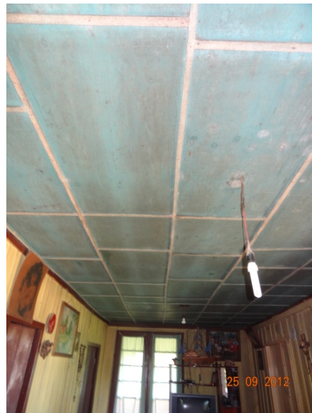
Detalhe – forro sala (25/09/2012, 15:38h)
