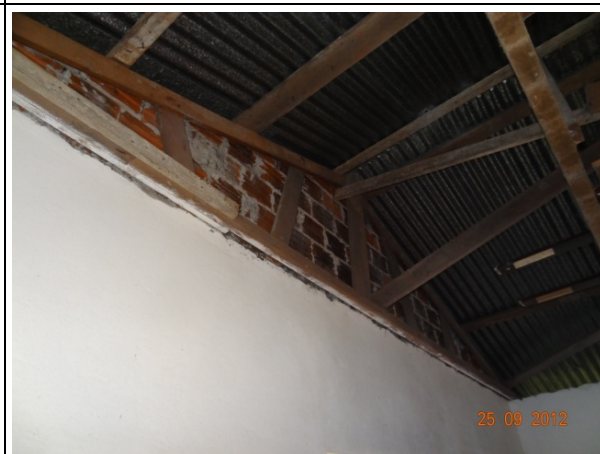
Cobertura – sem forro (25/09/2012, 09:40h)
