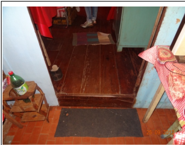
Detalhe – Piso sala (25/09/2012, 10:48h)
