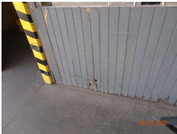
Detalhe – Forro Banheiro (26/09/2012, 15:49h)
