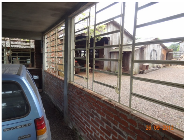
Parede – Garagem externa (26/09/2012, 10:52h)
