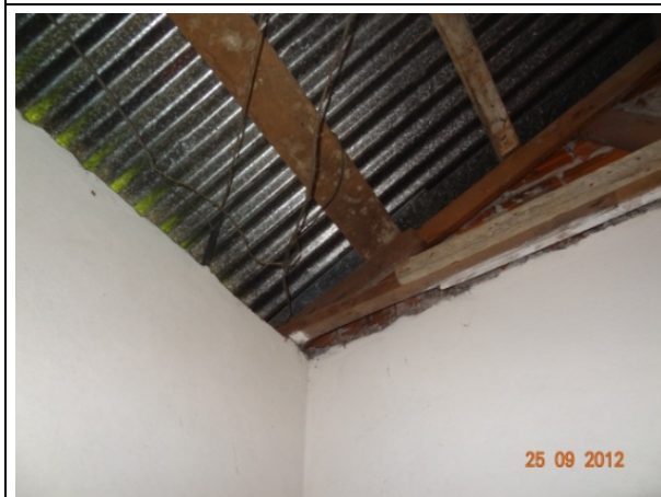
Cobertura Garagem (25/09/2012, 09:39h)
