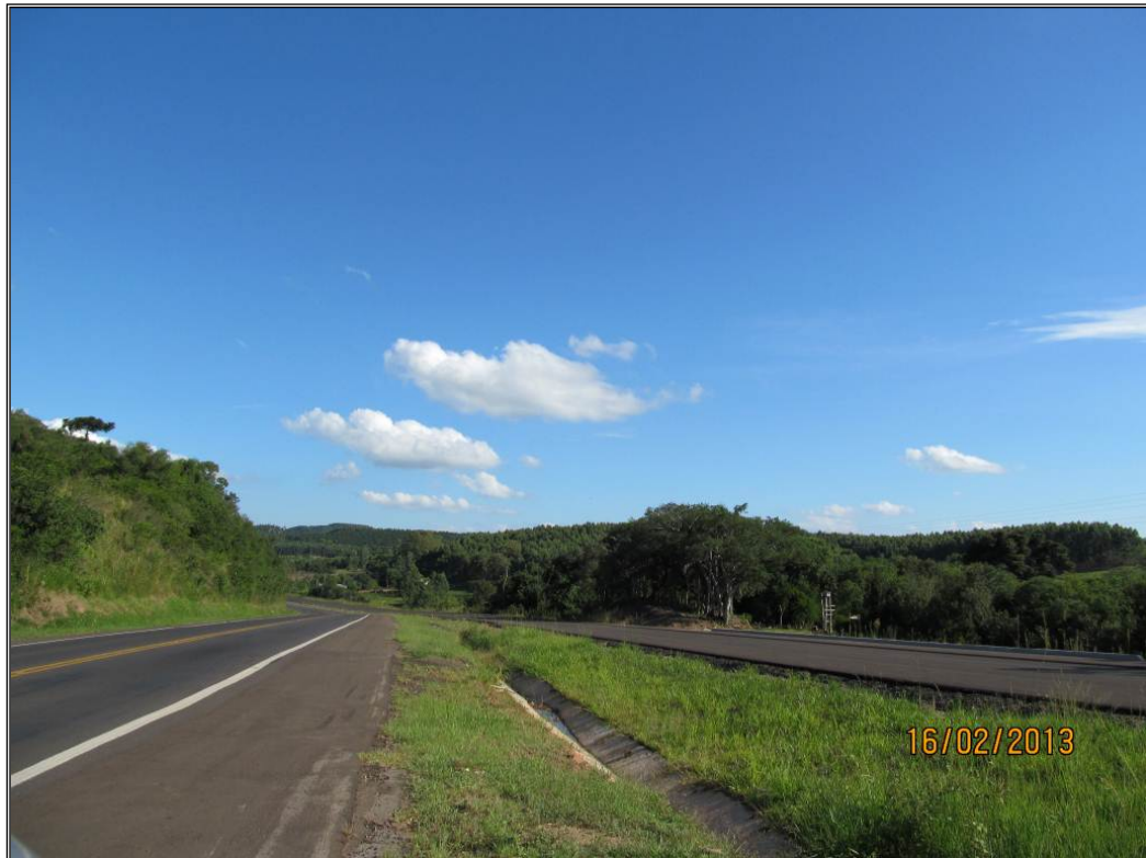
Figura 6 - Presença de vegetação nativa na margem direita da rodovia na EST 3 (estaca de referência 25+200).
