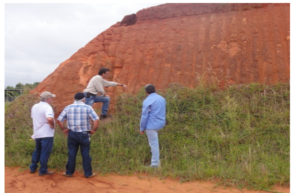
Execução PRAD – enleivamento de talude da EC 10, km 18+200, vistoriado pelo IBAMA. Situação em 19.2.13.
