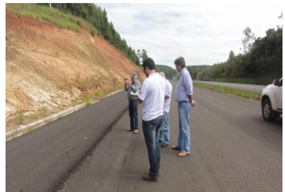
Vistoria conjunta (Gestão Ambiental, Supervisora de Obras e Consórcio) para verificação da situação dos taludes de corte.
