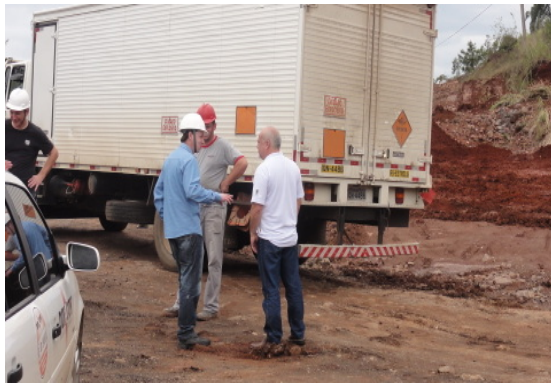
Orientações na frente de obra - desmanche de rocha com explosivos. E:1+960 em 4/10/12 -29,5146947S - 51,9403547W
