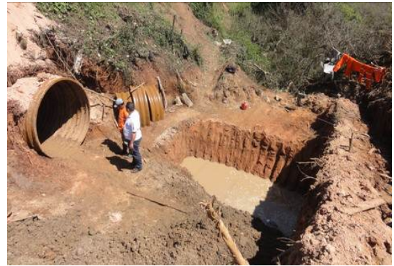
Bacia de sedimentação e barreira com material de decapagem e resíduos vegetais. E:25+70 em 19/10/12 -29,6447583S - 51,7669017W
