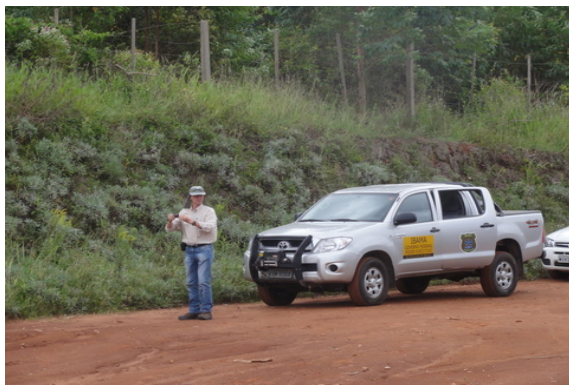
Execução PRAD - enleivamento taludes da EC18, 14+300 LD, vistoriado pelo IBAMA . Situação em 19.12.12.
