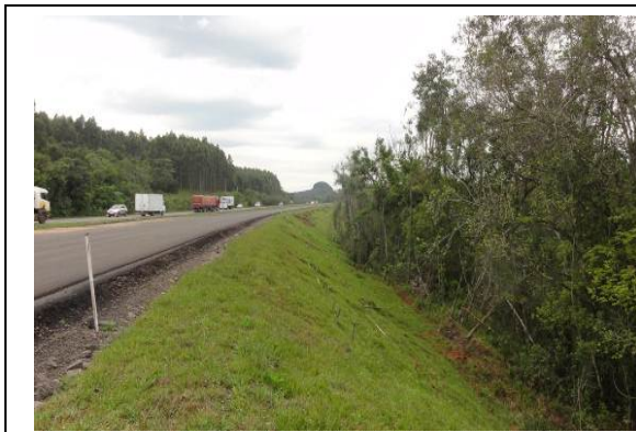
Enleivamento de talude de aterro com bom desenvolvimento. E:29+880 em 2/10/12 -29,6694767S - 51,7359214W
