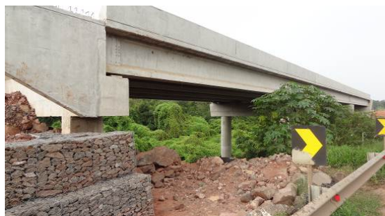
Ponte sobre o Arroio Estrela, detalhe do gabião (margem esquerda), km 1,740 LD, 26.03.13.
