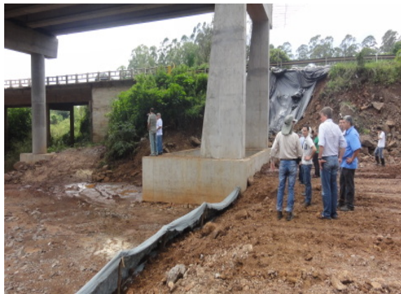
Acompanhamento vistoria do IBAMA, em 5/10/12. Ponte sobre Arroio Estrela.
