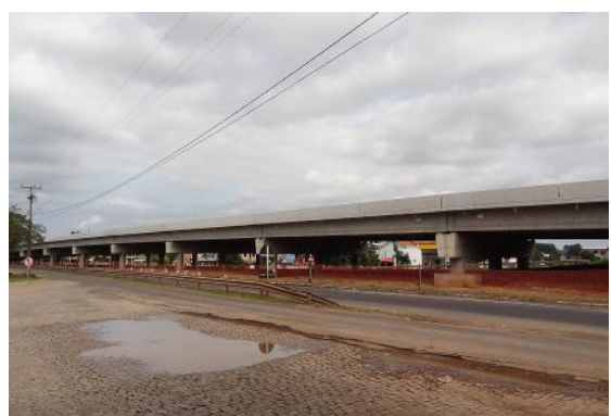
Viaduto fazenda Vila Nova, vista lateral, onde se observa a tela de isolamento da área inferior, km 16,310 LD. 26.03.13
