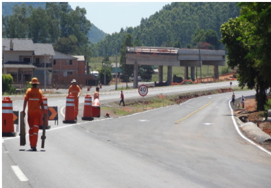
Viaduto de Tabai – ativação do desvio para continuidade das obras, km 29,680. 29.1.13.
