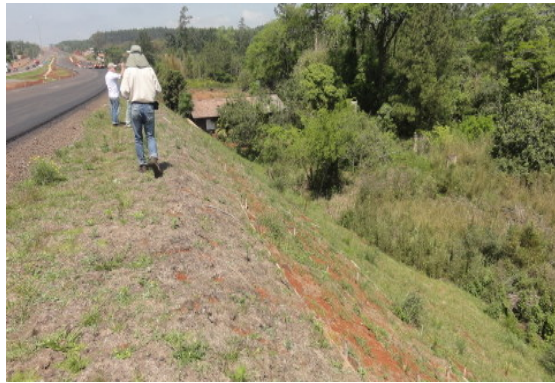
Enleivamento de talude de aterro vistoriado pelo IBAMA, LD. 05.10.12.
