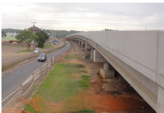
Viaduto Fazenda Vila Nova, vista geral. E:16+320 em 19/12/12 -29,590105S - 51,8268183W
