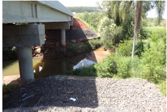
Ponte sobre Arroio Concórdia, pilares colchão reno e gabião, km 29,600. 28.2.13.
