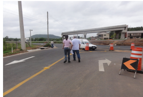
Viaduto de Tabai – vistoria do IBAMA, Km 29,680. 19.2.13.
