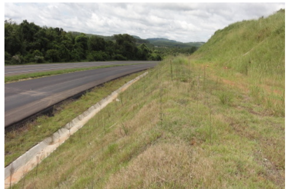
Km 23+180, vista da bancada e taludes enleivados. 21.3.13.
