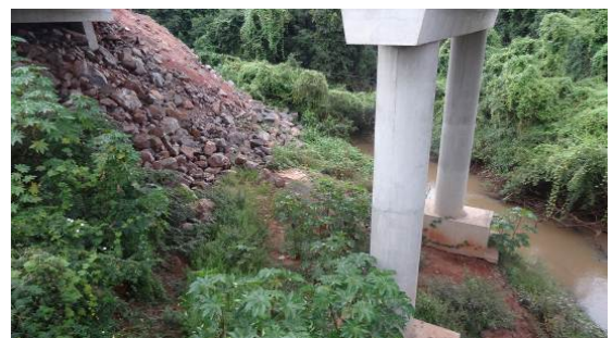
Ponte sobre o Arroio Estrela – detalhe dos pilares, enrocamento do aterro e vegetação ciliar em recuperação.
