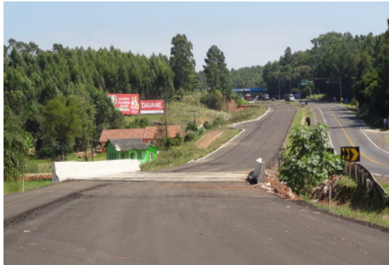
Ponte sobre Arroio Concórdia, km 29,600. Elevação do aterro concluída, com pavimentação em andamento. 28.2.13.
