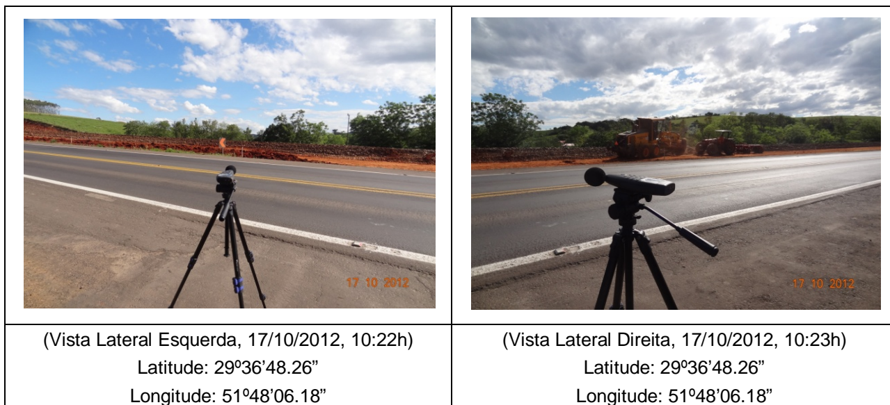
Fotos - Km 378, Frente de Obras – ao longo da rodovia BR-386
