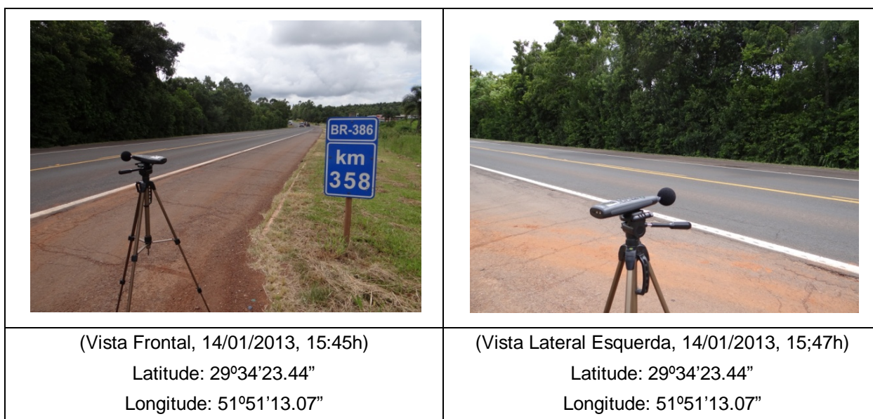
Fotos - Km 358, Frente de Obras – ao longo da rodovia BR-386
