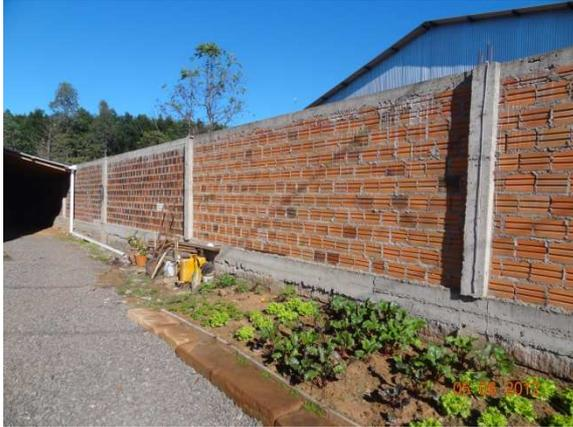
Muro sem reboco (06/06/2012, 10:41h)
