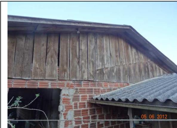
Detalhe do telhado do anexo, parede sem reboco e tábuas para cobrir a parede e o beirado – fundos (05/06/2012, 17:17h)
