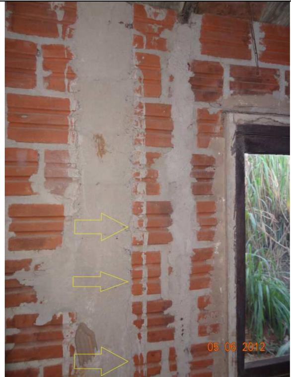
Fissuras entre a coluna de concreto e a parede de tijolos (05/06/2012, 17:23h)
