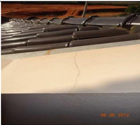
Fissura no reboco do parapeito (06/06/2012, 10:33h)
