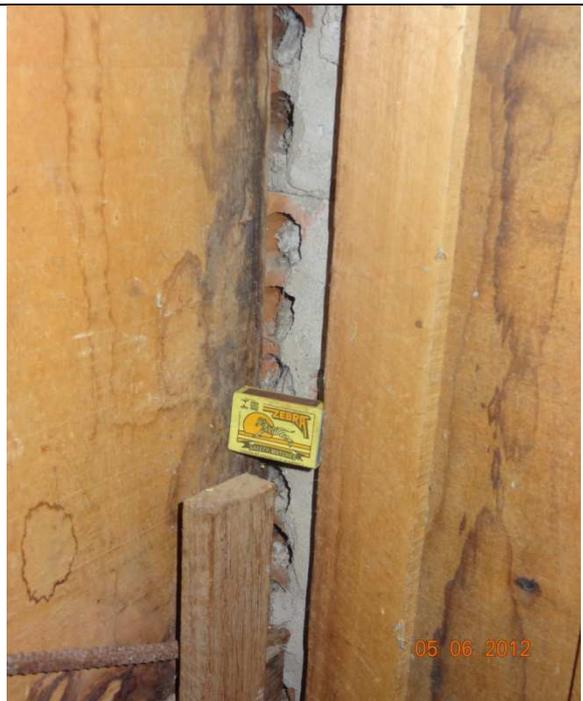
Diferença entre a parede de madeira e de alvenaria entre a cozinha e a área de serviço (05/06/2012, 17:29h)
