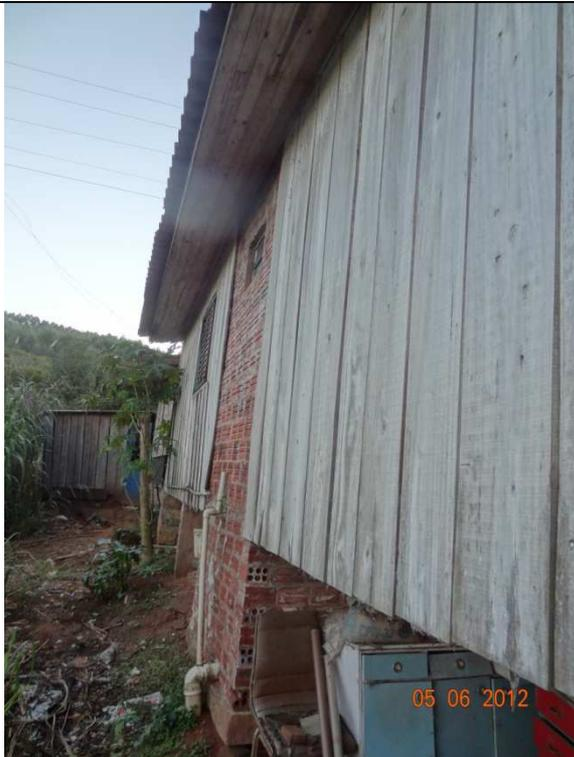
Visão panorâmica – observação da frente para os fundos – lateral esquerda – beirado forrado, sem calçada, parede do banheiro sem reboco (05/06/2012, 17:21h)
