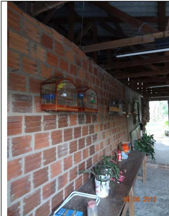
Garagem, sem forro, sem piso cerâmico, sem reboco nas paredes de alvenaria, parede da direita fora do prumo - visão da frente para os fundos da residência (05/06/2012, 17:22h)
