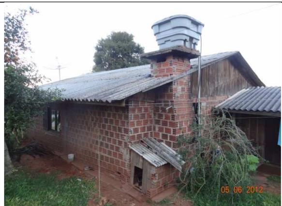
Caixa d'água, telhado de fibrocimento e paredes externas da lateral direita e fundos sem reboco (05/06/2012, 17:16h)
