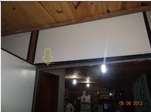
Quarto 1 - detalhe da estrutura danificada pela falta de prumo da edificação (05/06/2012, 17:36h)
