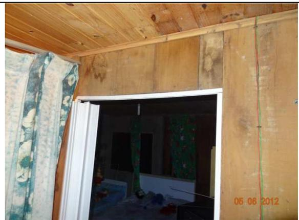
Cozinha – vista para o quarto 2 mostrando o detalhe da estrutura da porta deformada (05/06/2012, 17:45h)
