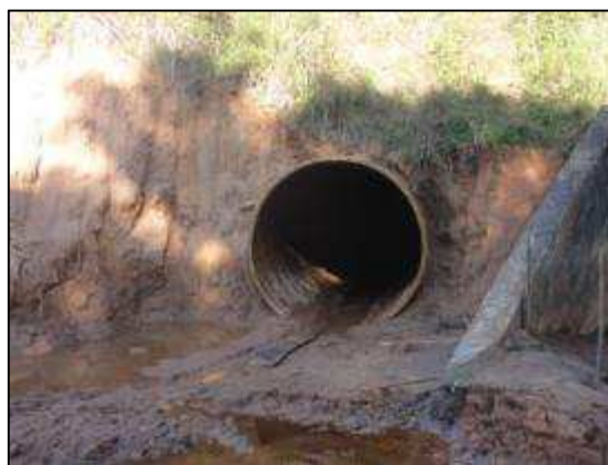
Detalhe bueiro armico com ala de concreto da galeria existente.
