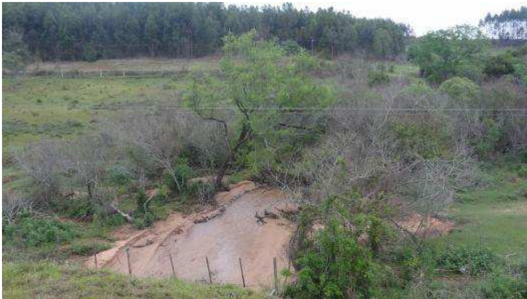
Figura 32 - Abertura da drenagem (passafauna).
