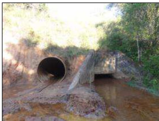
Vista Geral bueiro armico novo e galeria antiga.
