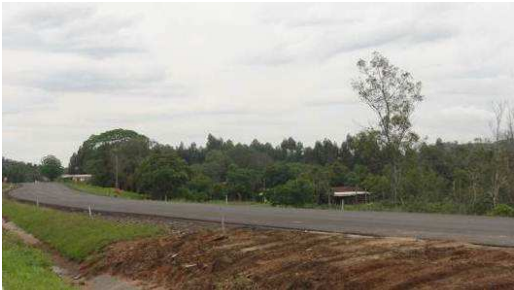
Figura 35 - Vista geral do local da PS 10.
