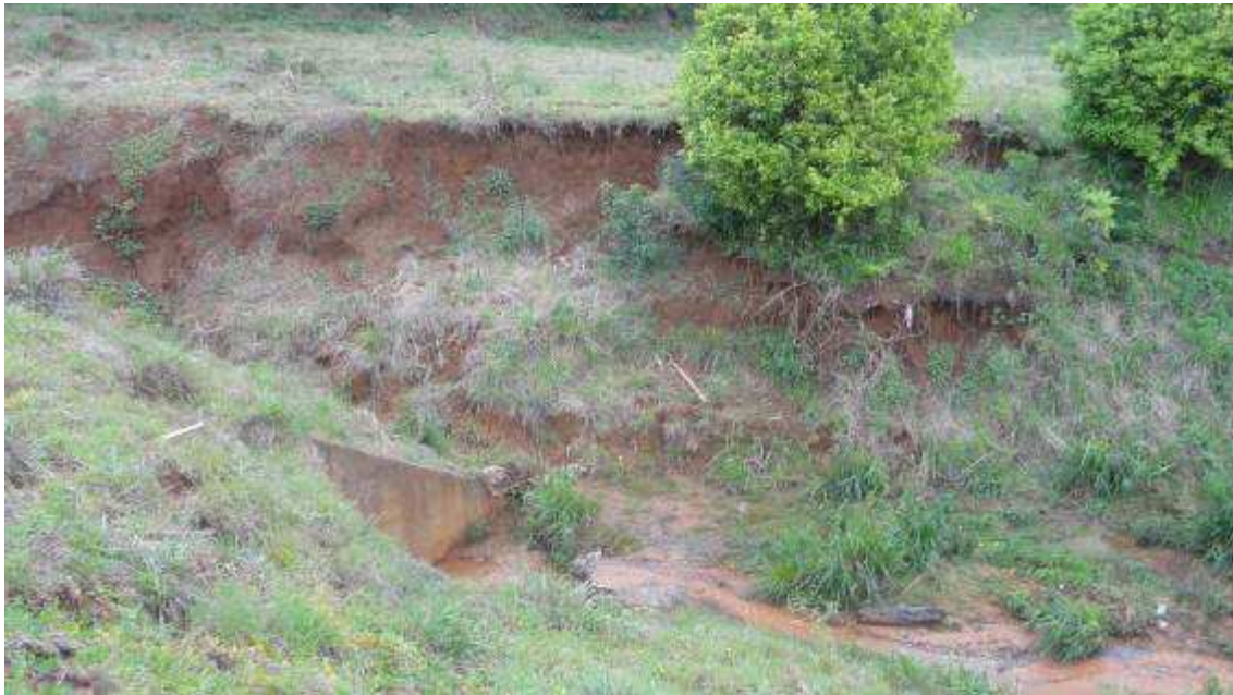
Figura 24 - Abertura da estrutura da passafauna (drenagem).
