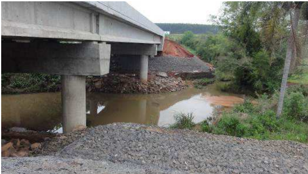
Figura 16 - Porção inferior da ponte, onde será implantada passagem seca.
