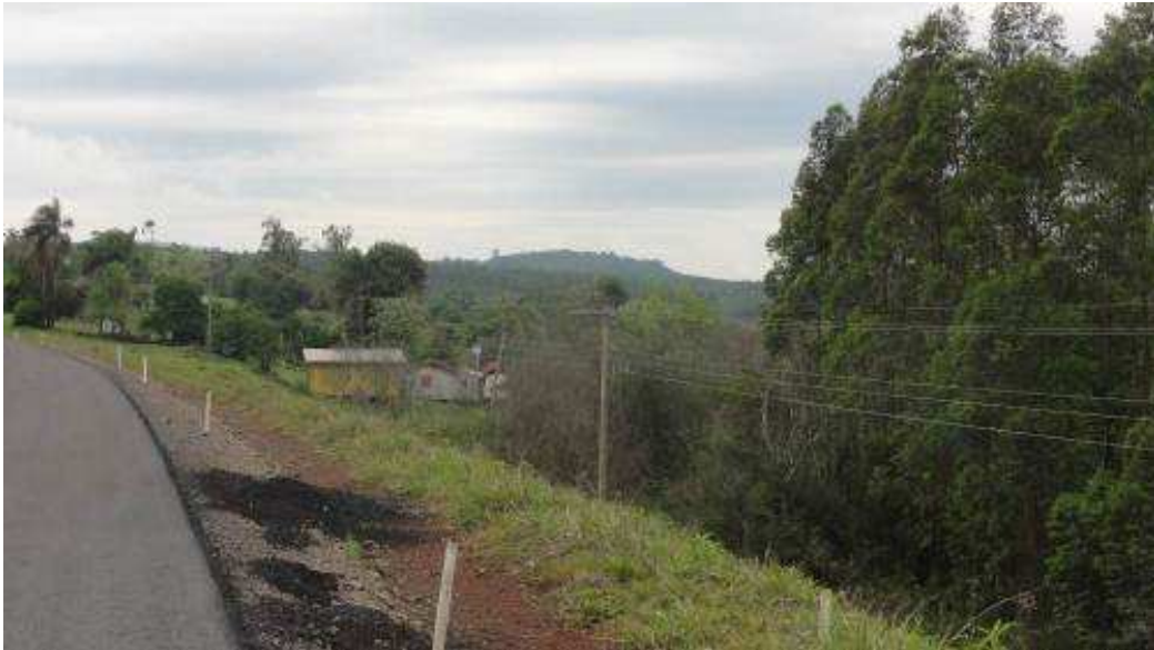
Figura 30 - Residências próximas do local, margem direita (Estrela-Tabaí).
