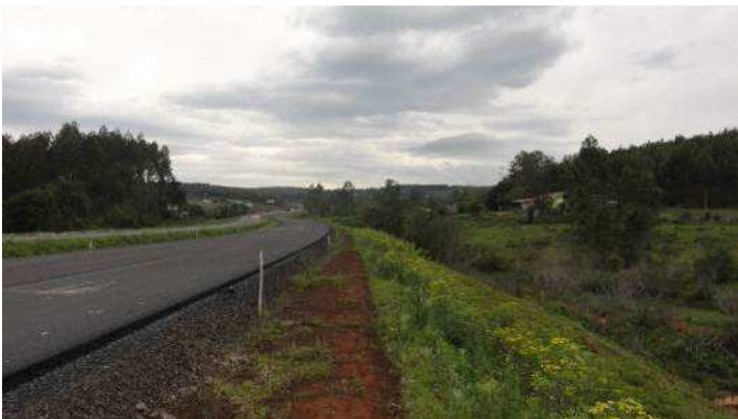
Figura 31 - Vista geral do local da PS 9.
