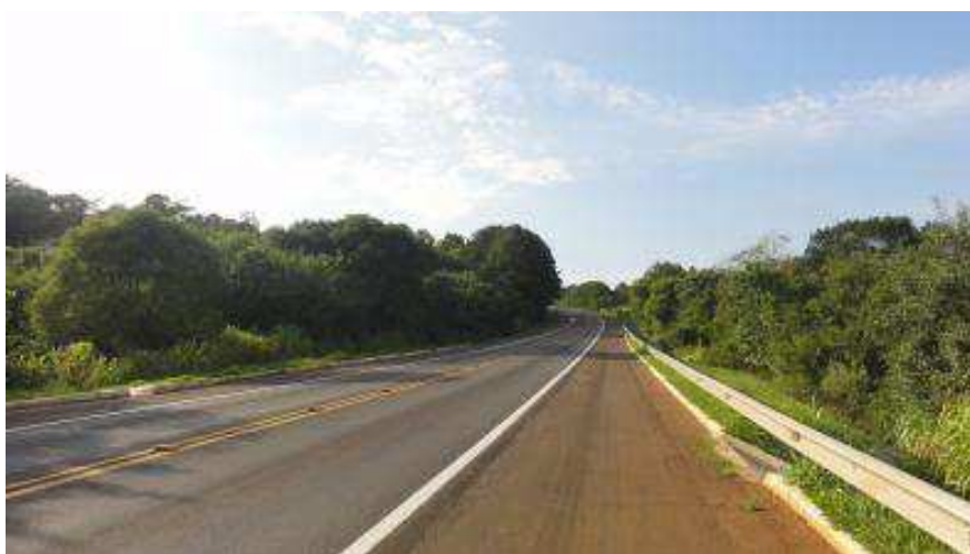
Figura 10 - Vista geral do local da PS 3.
