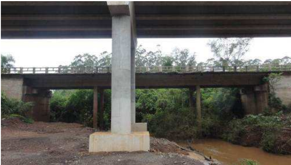
Figura 4 - Local da PS 1, sob ponte do arroio Estela.
