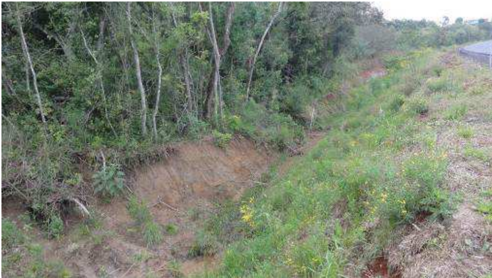
Figura 21 - Local da abertura da drenagem utilizada como passafauna.
