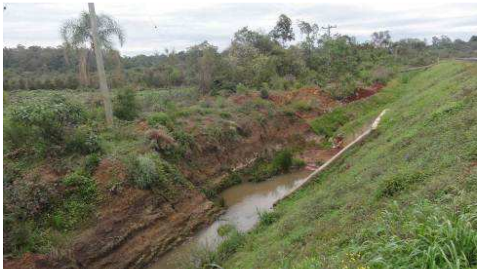
Figura 13 - Abertura da drenagem, utilizada como passafauna também.
