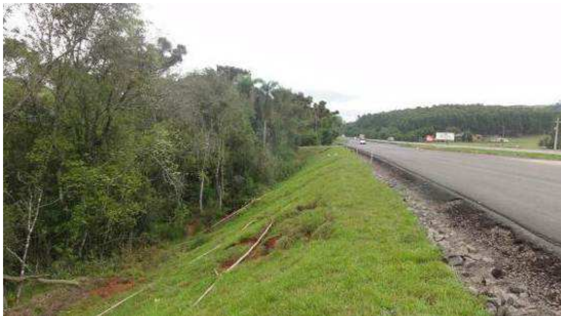
Figura 38 - Vista geral do local da PS 10 (Tabaí-Estrela).
