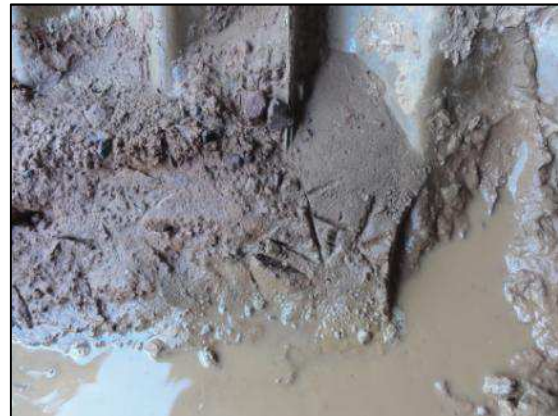
Pegadas de ave, provavelmente saracura, no interior do bueiro armico.
