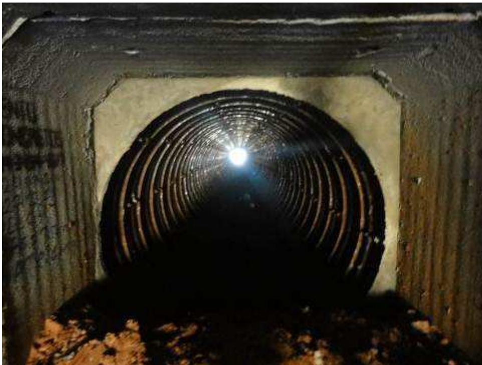
Figura 57 - Transição entre bueiro simples e tubo armado na mesma drenagem.
