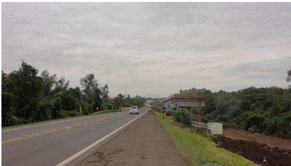
Figura 3 - Visão geral do local, ponte sobre Arroio Estrela.
