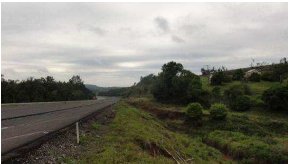
Figura 23 - Vista geral do local da PS 7.
