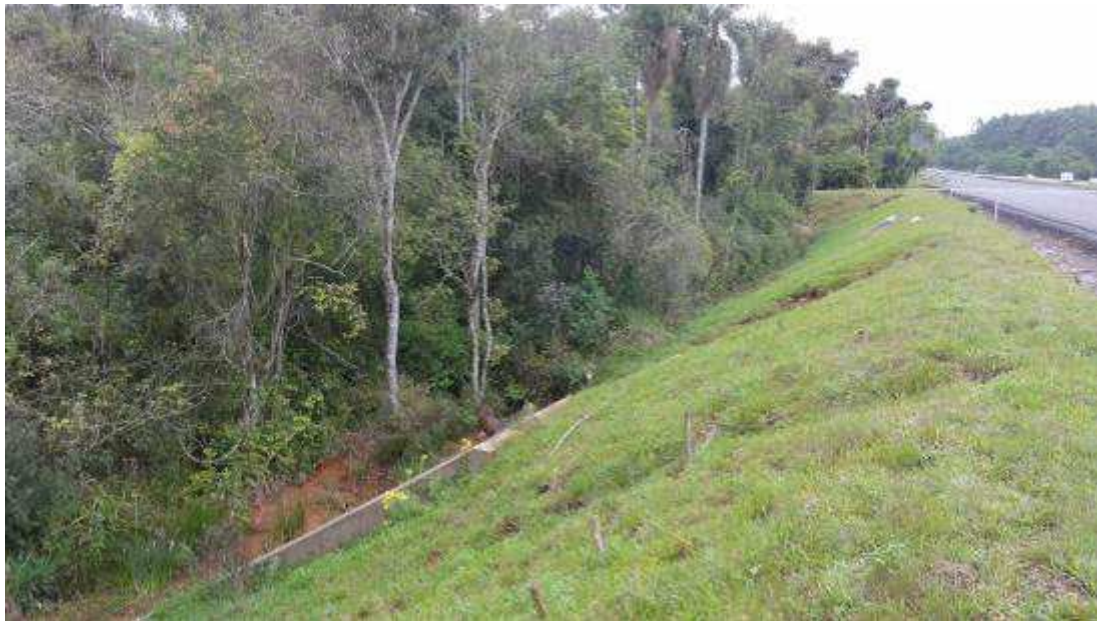
Figura 37 - Abertura da drenagem (passafauna).
