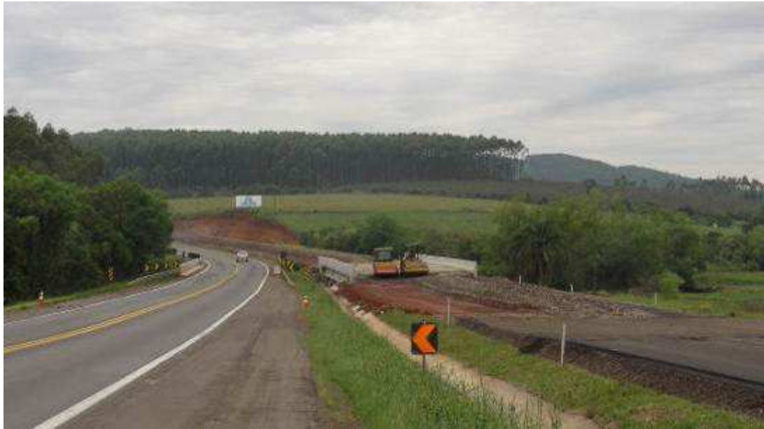
Figura 15 - Vista geral da ponte em duplicação, sobre arroio Concórdia.
